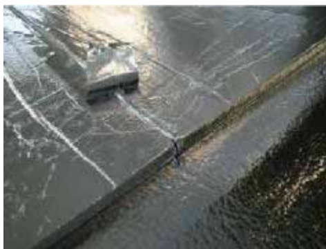
VIP als Fußbodendämmung mit 15 mm Dämmstärke; Fugenabklebung mit Alu-Klebeband
