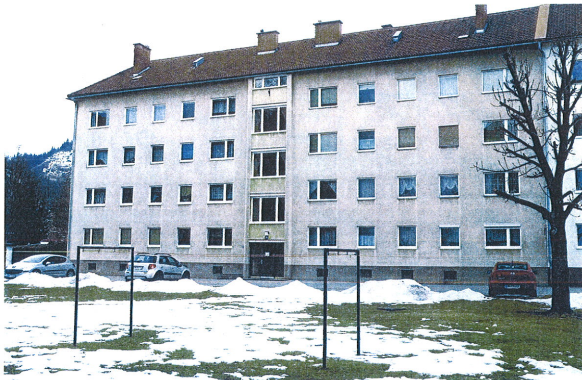
◀ Abbildung 1 Bestandsgebäude mit Vorfertigungspotential
