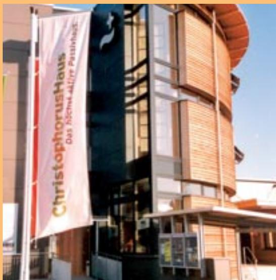
Brettschichtholz sowie über 7.000 m<sup>2</sup> Holzwerkstoffplatten wurden verarbeitet. Für die Wärmedämmung kamen ausschließlich ökologische Dämmstoffe (Hanf, Zellulose und Steinwolle) zum Einsatz. In die Gebäudehülle wurde eine 33 m<sup>2</sup> große Solarfassade integriert.
