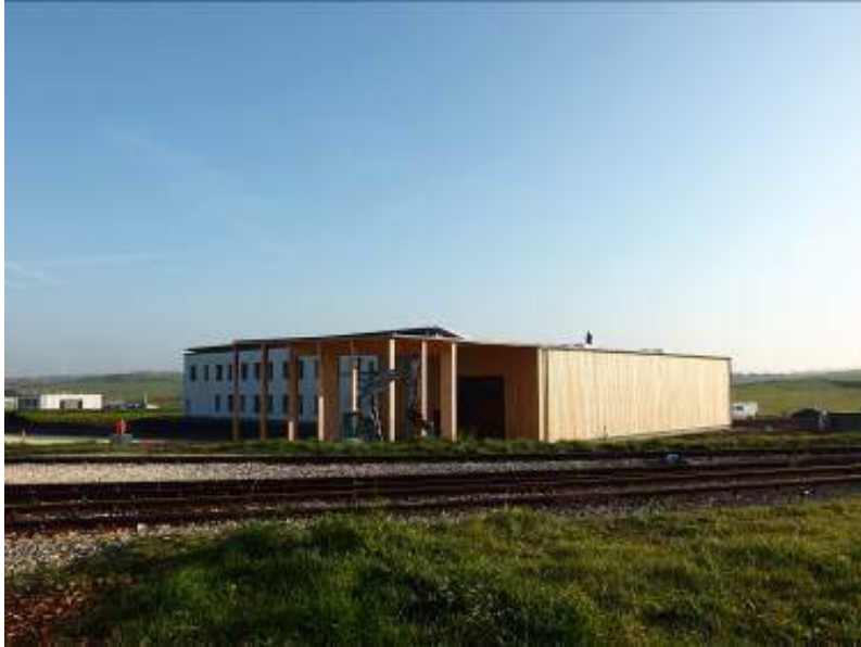
Abbildung 11: Baufortschritt März bis Oktober 2013
