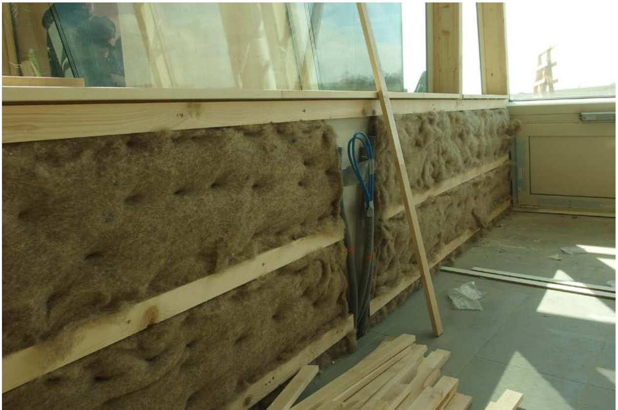
Wand zwischen Besprechungsraum und Halle
