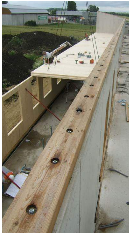
Abbildung 144: Holzkonstruktion Wand und Decke Büros
