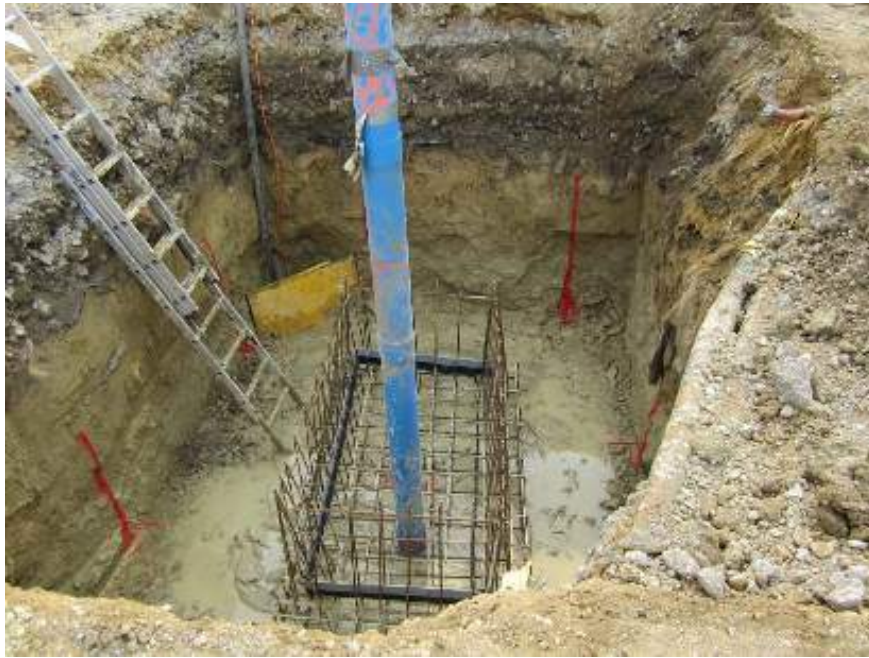
Abbildung 49: Aushub für Fundamente
