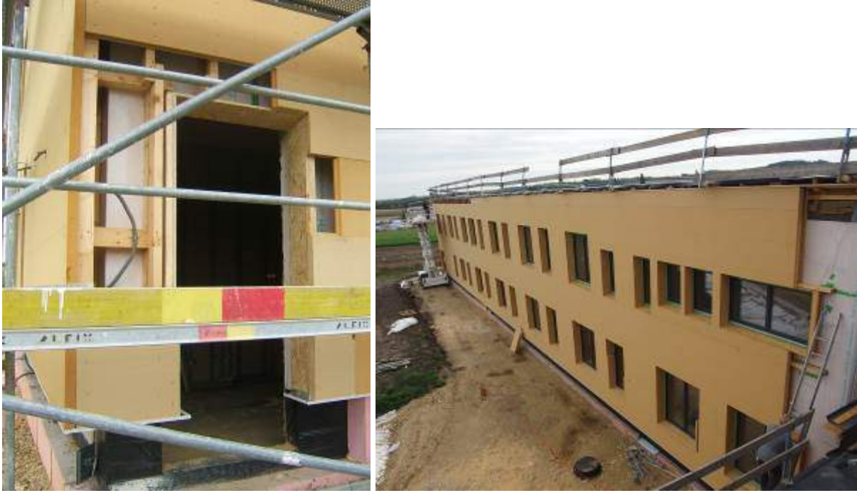
Abbildung 150: Holzkonstruktion Außenwand Nord gedämmt mit Zellstoff
