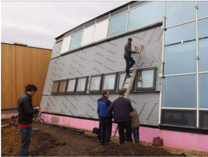
Abbildung 134: Naturmaß durch die Kollektorfirma, mit anschließender 9 wöchiger Fertigungszeit
