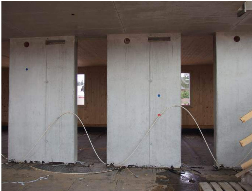
Abbildung 99: Betonkernaktivierung – Ausführung:
