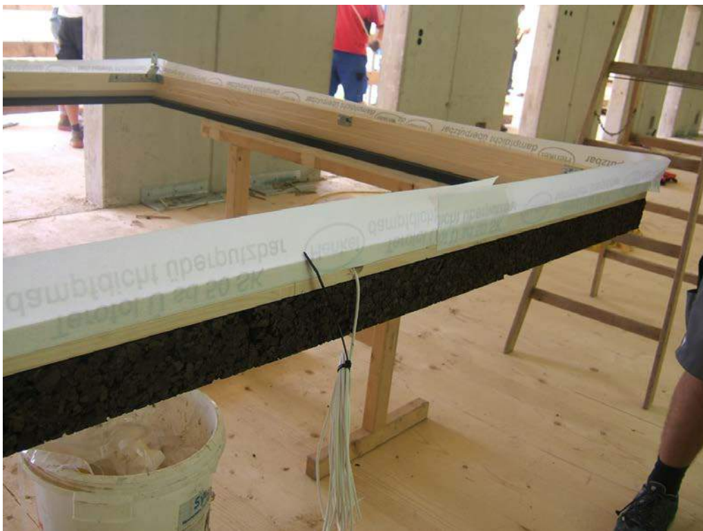
Abbildung 146: Passivhausfenster aus Holz und Wärmedämmung aus Kork
