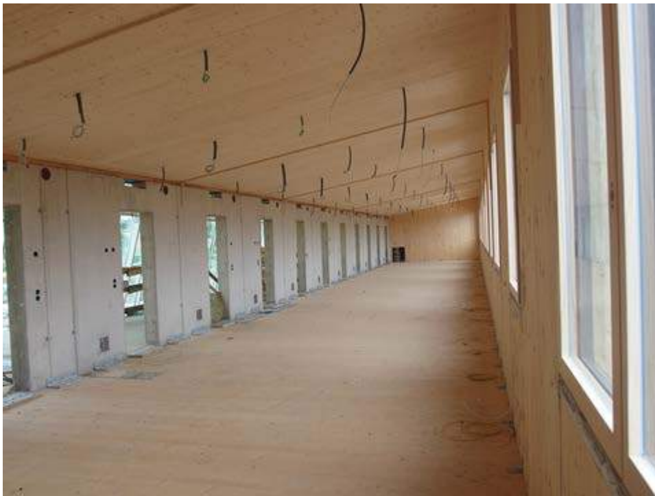
Abbildung 144: Holzkonstruktion Wand und Decke Büros
