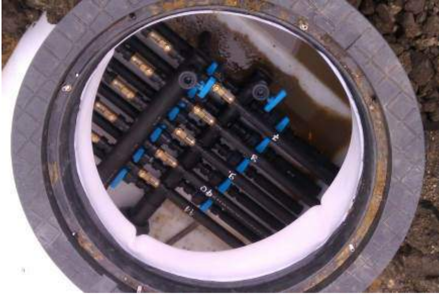
Abbildung 54: Ausführung der Tiefenbohrungen und Zusammenfassung der Leitungen
