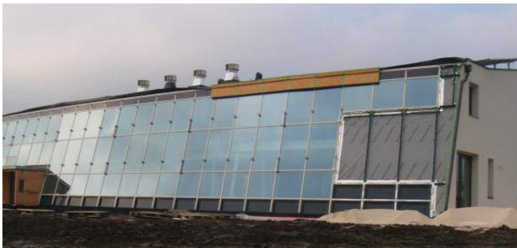
Abbildung 32: Detail vergrößerter Lüftungsbereich- Zuluftklappen
