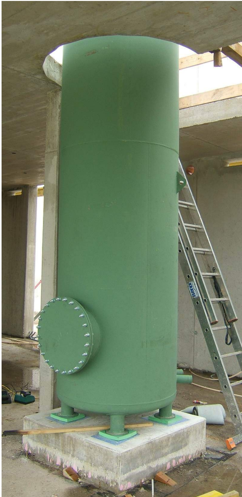
Abbildung 137: Speicher – Thermisch getrennt von der Konstruktion
