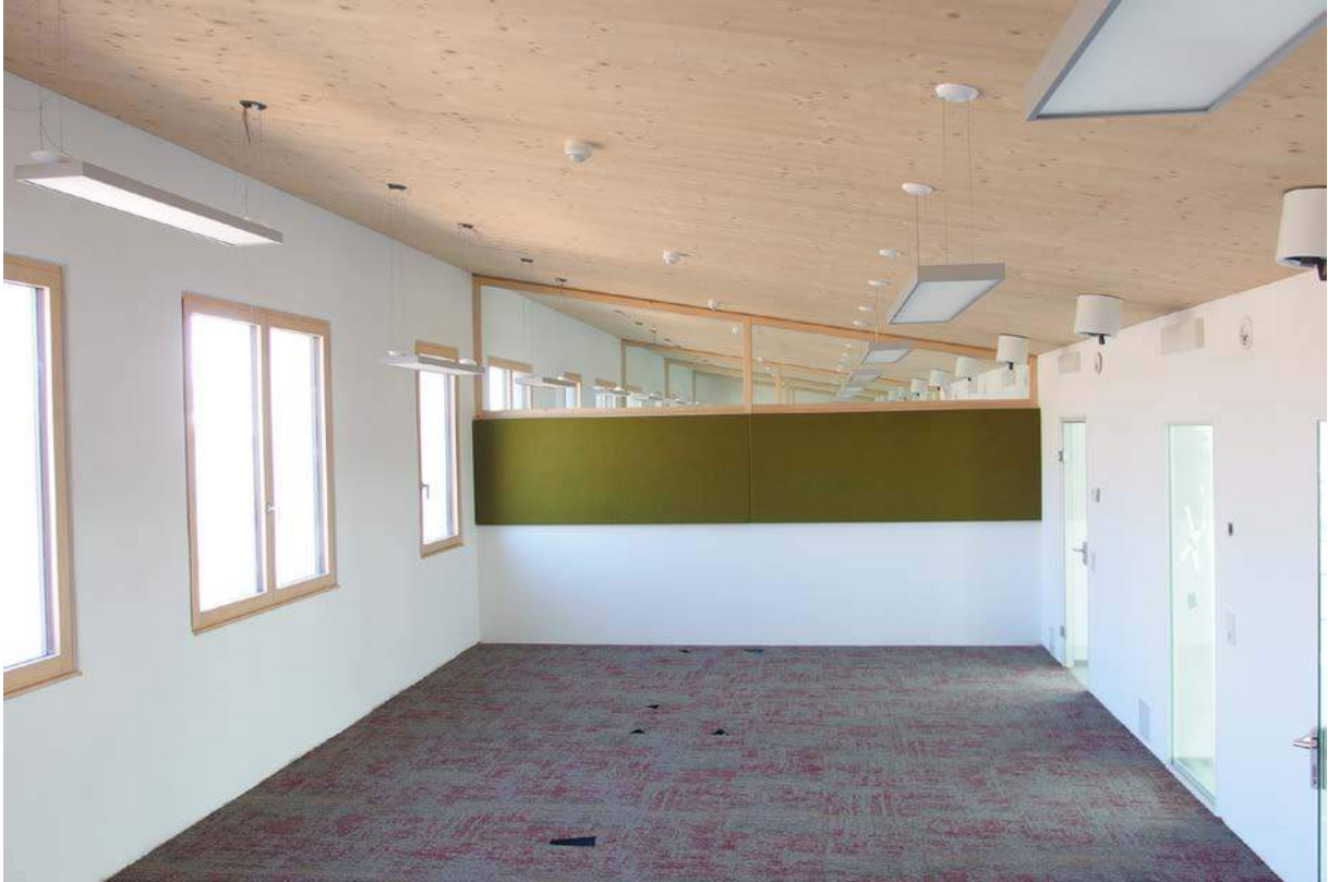
Abbildung 17: Büros mit flexiblen Trennwänden und Pinnwand als Akustikelement
