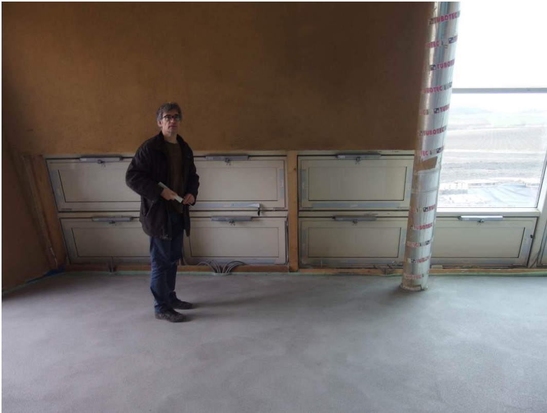
Abbildung 33: Vergrößerter Lüftungsbereich- Zuluftklappen
