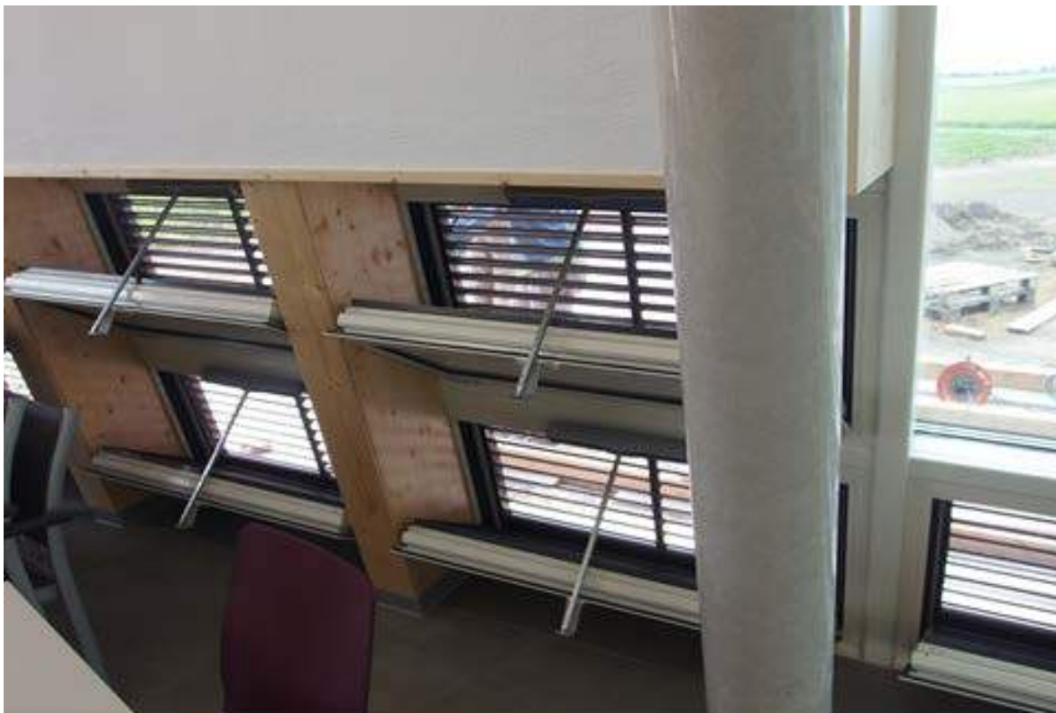
Abbildung 33: Vergrößerter Lüftungsbereich- Zuluftklappen
