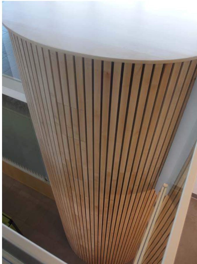
Abbildung 142: Thermischer Speichers (gleichzeitig Akustikelement).
