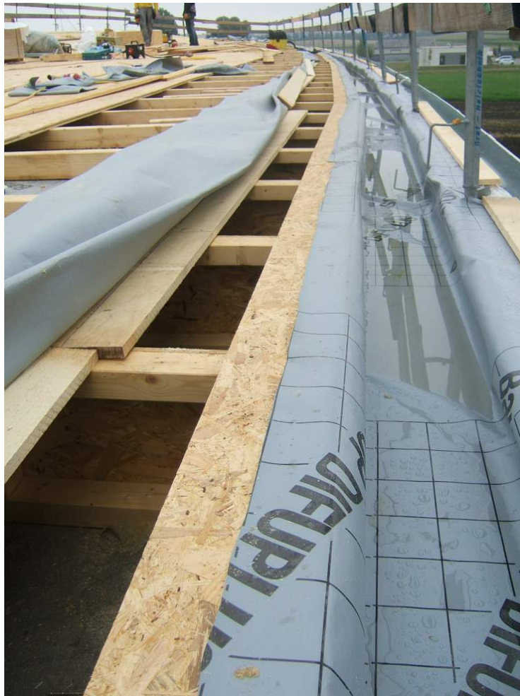
Abbildung 151: Dachaufbau mit anschließender Zellulosedämmung
