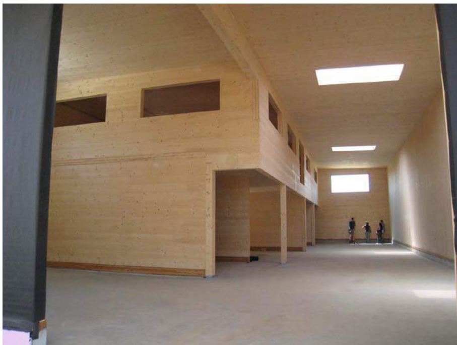
Abbildung 143: Vollholzkonstruktion Lagerhalle
