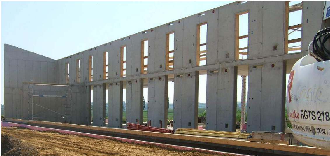
Abbildung 106: Massiver Kern als Speichermasse
