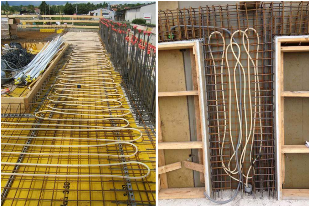
Abbildung 98: Einbausituation der Kältschlägen in der Decke und der Wand
