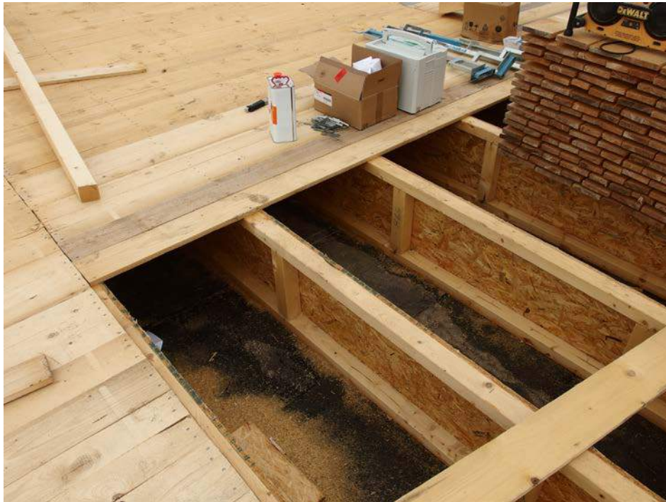
Abbildung 145: Holzkonstruktion zur Ausnahme der Wärmedämmung (Zellstoff) über der obersten Geschossdecke
