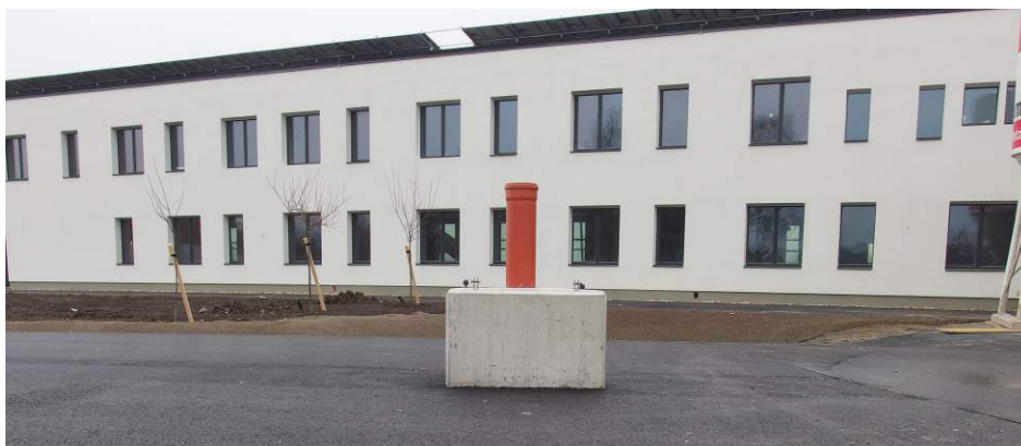
Abbildung 51: Fundament für den Langsamläufer
