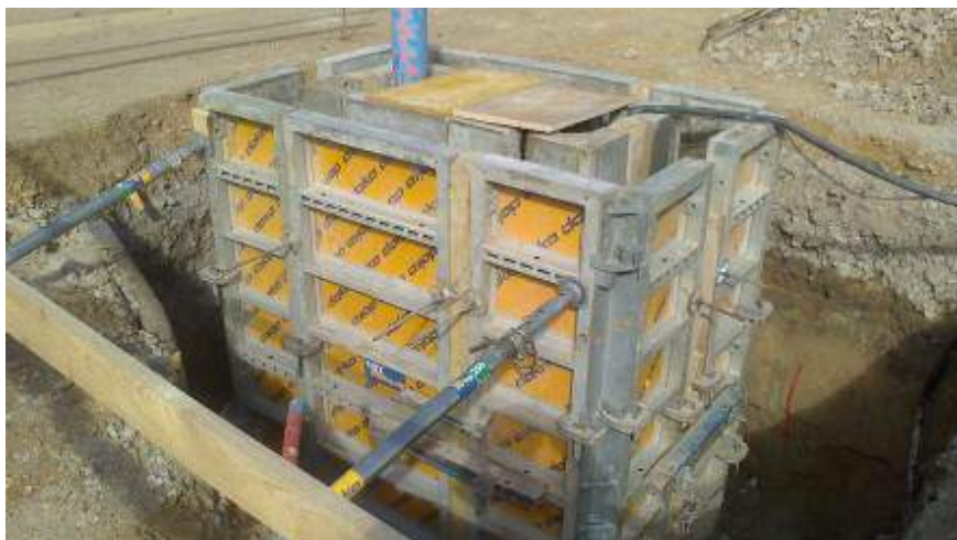
Abbildung 50: Wartungsschacht und Fundamentarbeiten für den Langsamläufer
