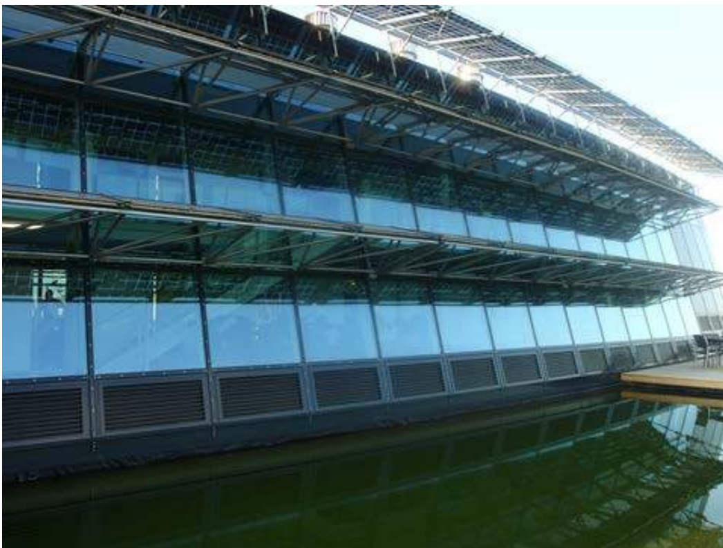
Abbildung 124: PV in der Fassade
