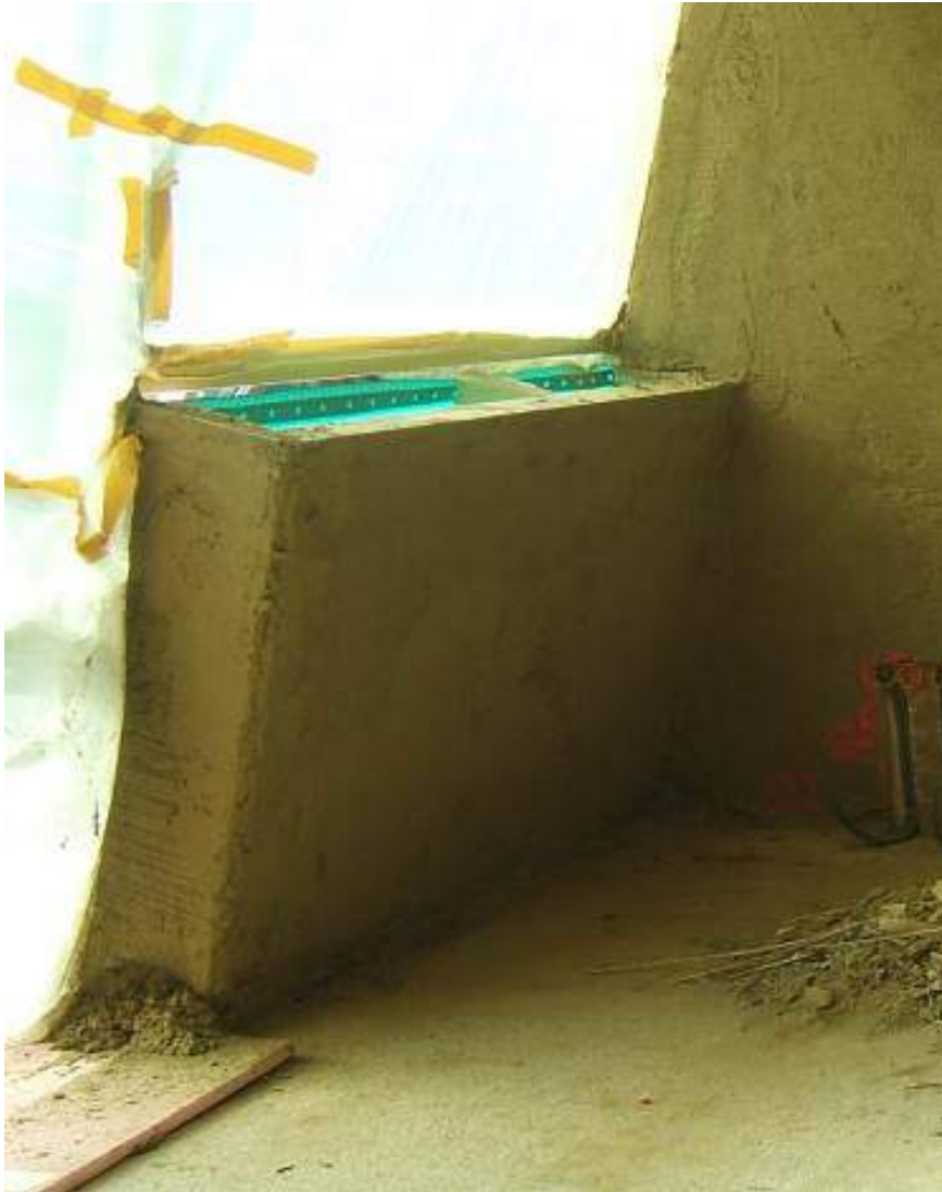
Abbildung 131: Kollektor Unterkonstruktion – Innenseite (mit Lehmputz)
