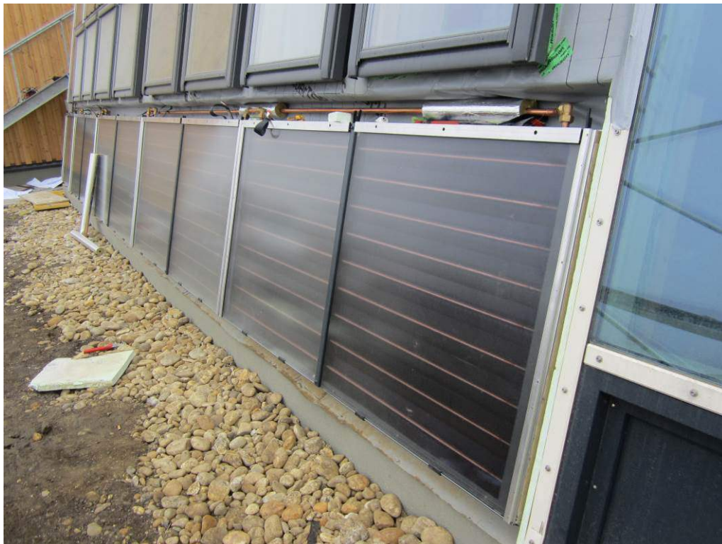
Abbildung 135:Montage der Fassadenkollektoren:
