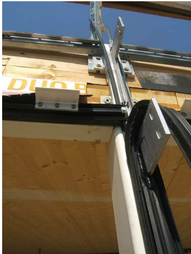
Abbildung 118: Detail Traufpunkt über Büro-Südfassade mit PV
