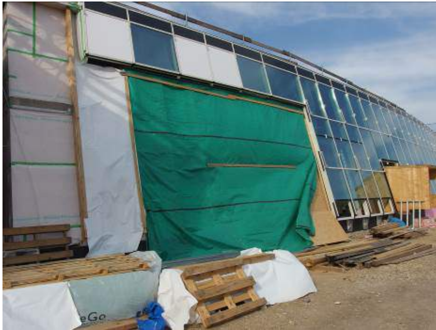
Abbildung 132: Provisorische Abdeckung der Fassadenkollektorbereiche
