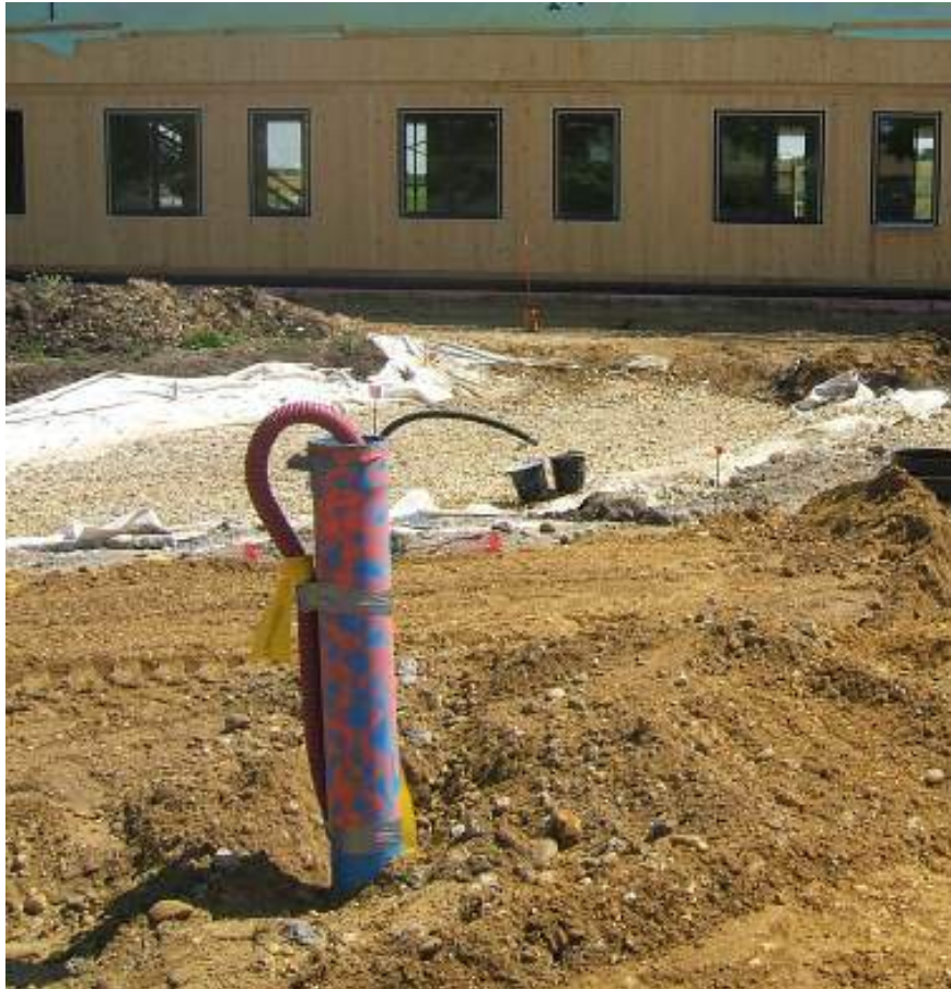
Abbildung 48: vorhandener Testbrunnen (aus Voruntersuchung)
