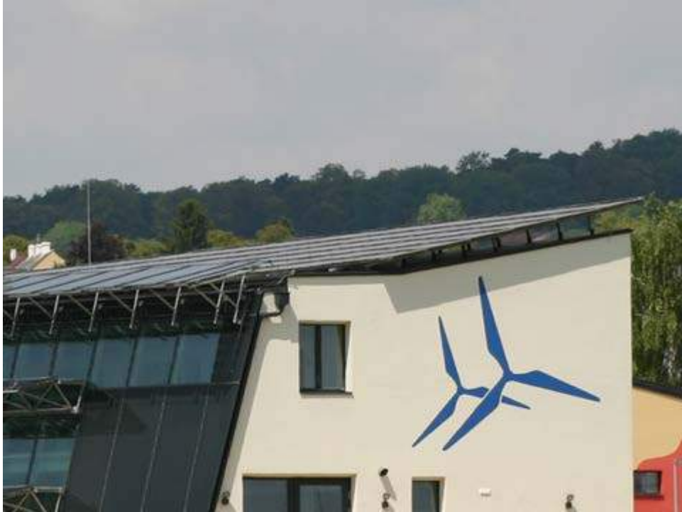
Abbildung 121: vollständig belüftete PV am Dach
