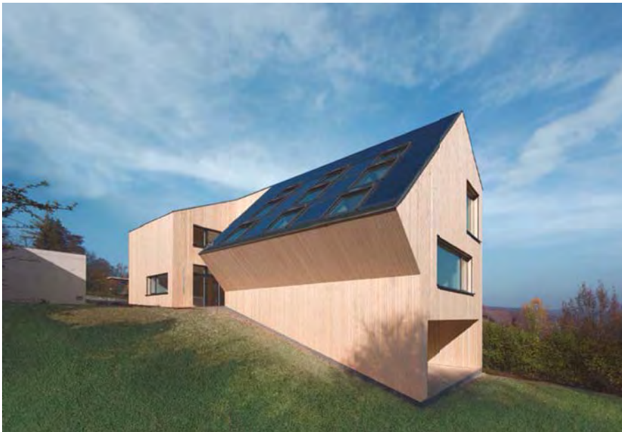
Abbildung 1: Velux Sunlighthouse, Pressbaum, Niederösterreich, Blick von Süden
