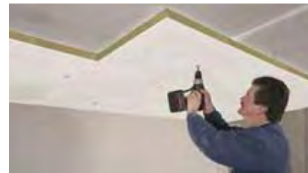
PU Platten mit Nut und Feder System, Randbefestigungsklammern
