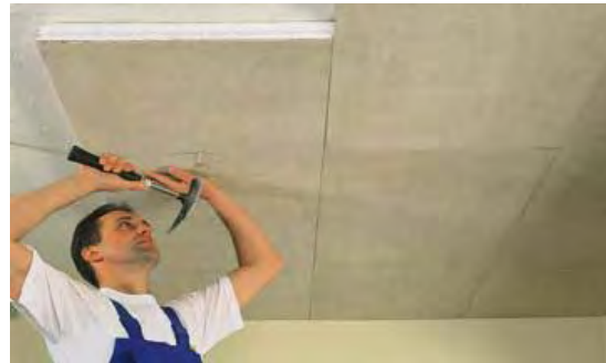
Mehrschichtplatte aus Holzwolle und Polystyrol-Hartschaumstoff, verdübelt
