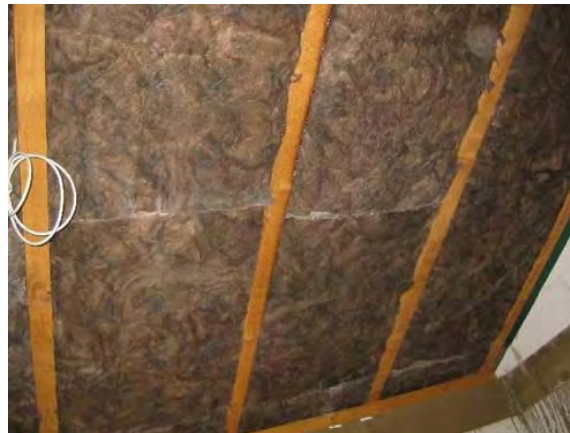
Vollsparrendämmung mit Klemmfalz
