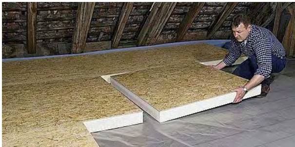
Polyurethanplatte mit Deckschicht aus Spanplatten, begehbar
