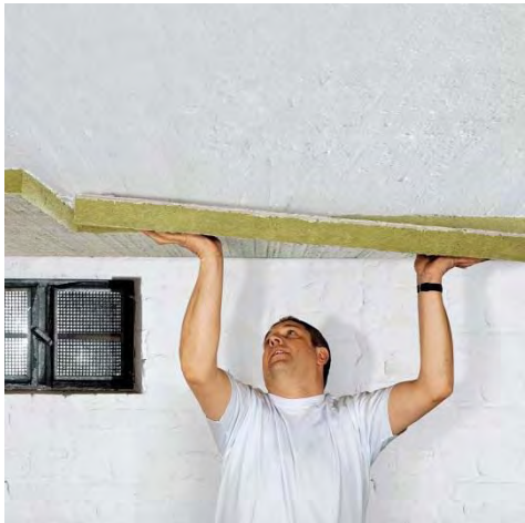
Mehrschichtplatte aus Holzwolle und Polystyrol-Hartschaumstoff, verdübelt
