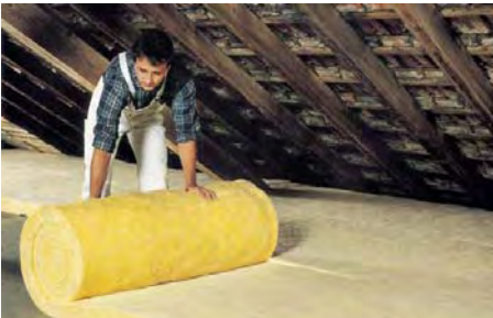
Mineralwolle fugendicht verlegt, nicht begehbar
