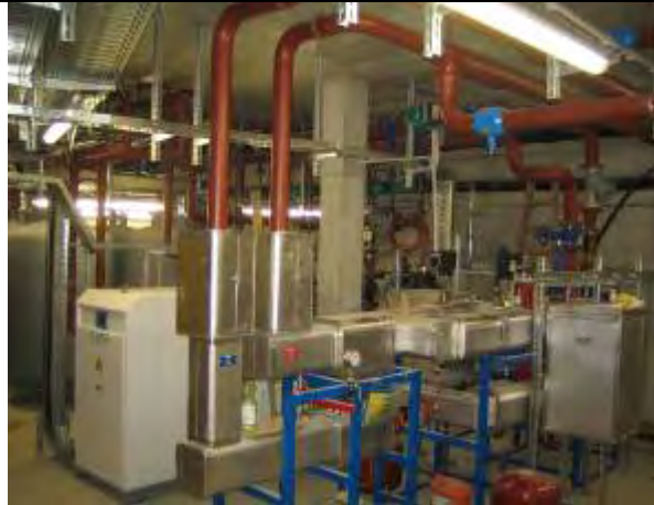
Verteilerzentrale mit Wärmepumpe
