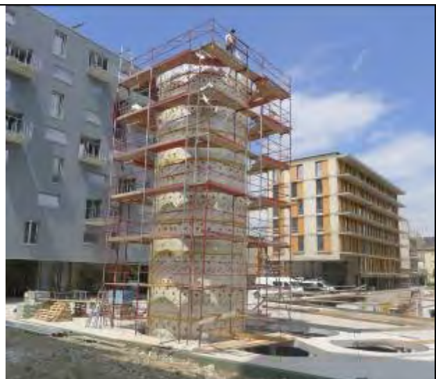
Der Pufferspeicher wird vor Ort mit 30cm Mineralwolle gedämmt.
