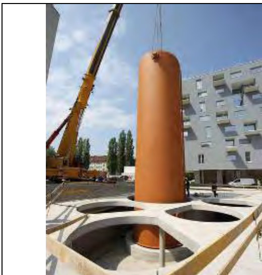
200.000 Liter Pufferspeicher wird vorgefertigt angeliefert und versetzt.
