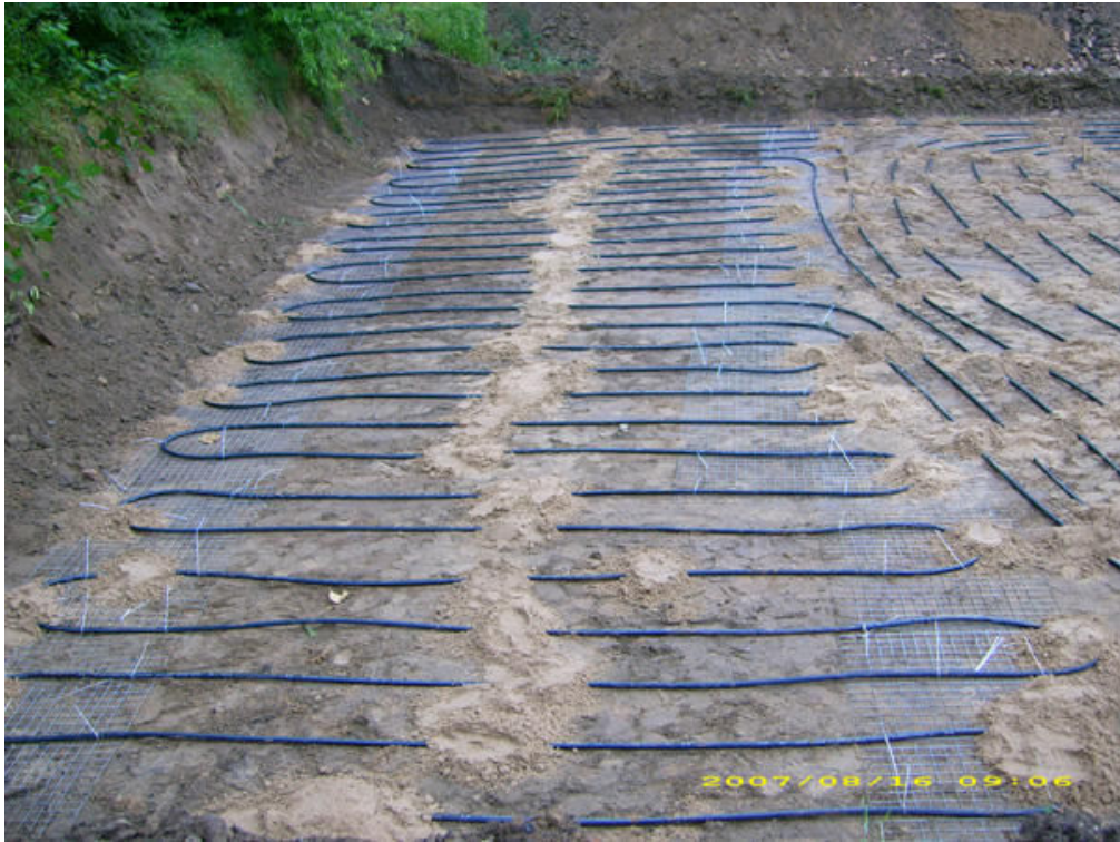
Abbildung 32: Beispielhafte Darstellung der Verlegung von oberflächennahen Erdkollektoren
