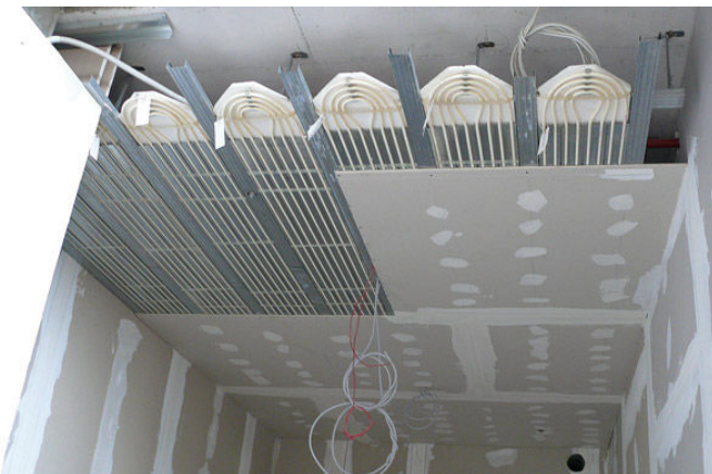
Abbildung 41: Darstellung der Verteilung von Wärme bzw. Kälte in der Baustruktur mittels Rohre in einer abgehängten Decke
