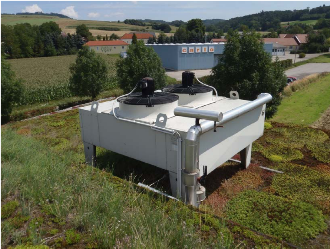
Abbildung 29: Beispielhafte Darstellung einer Rückkühleinheit einer Lüftungsanlage
