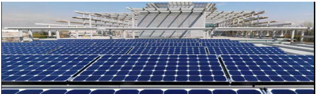
Abbildung 21: Beispielhafte Montagesituation einer Photovoltaikanlage 1
