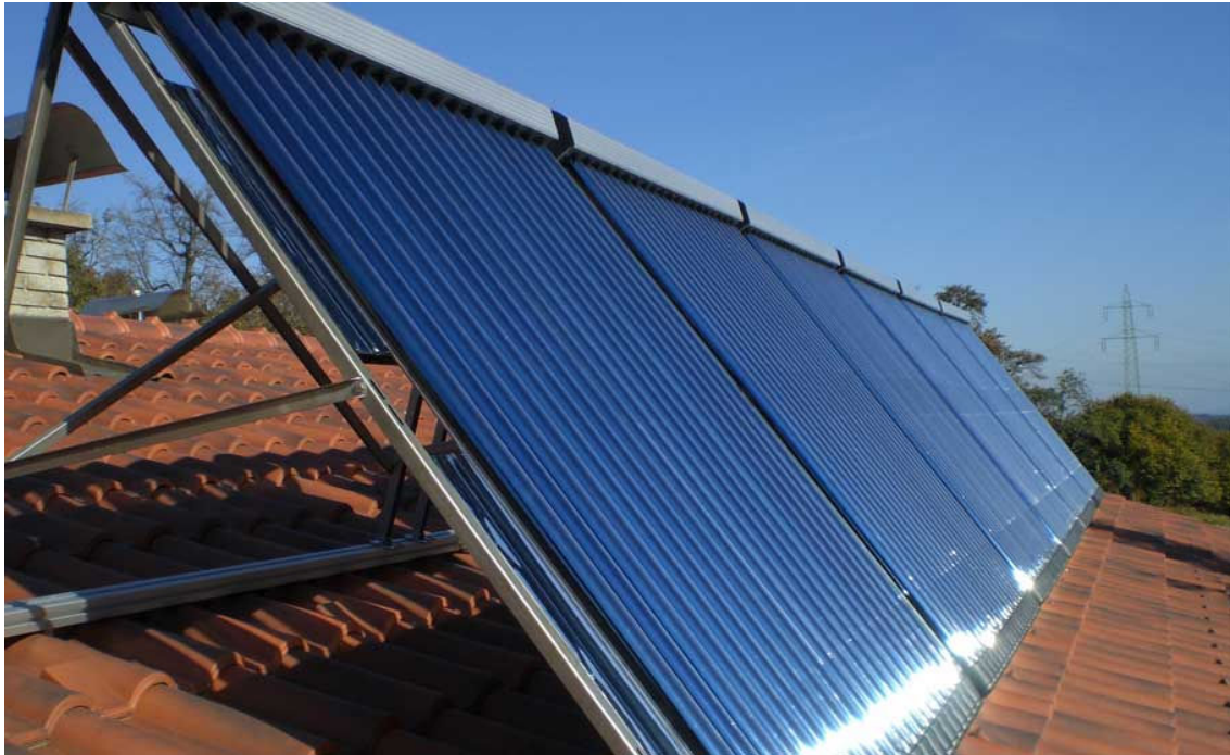
Abbildung 19: Beispielhafte Darstellung der Montage eines solarthermischen Röhrenkollektors
