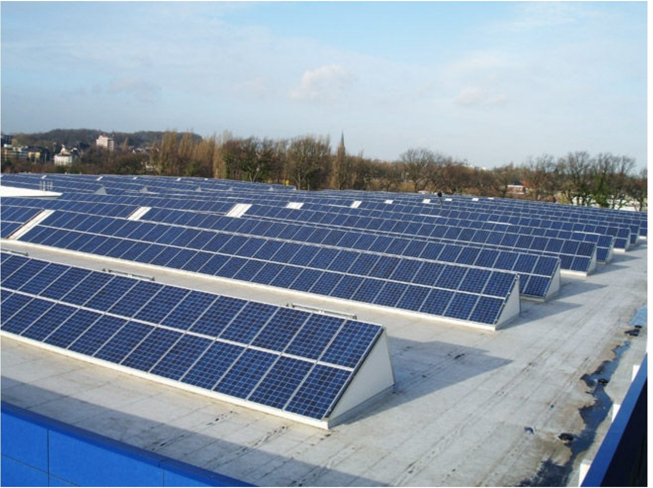
Abbildung 22: Beispielhafte Montagesituation einer Photovoltaikanlage 1
