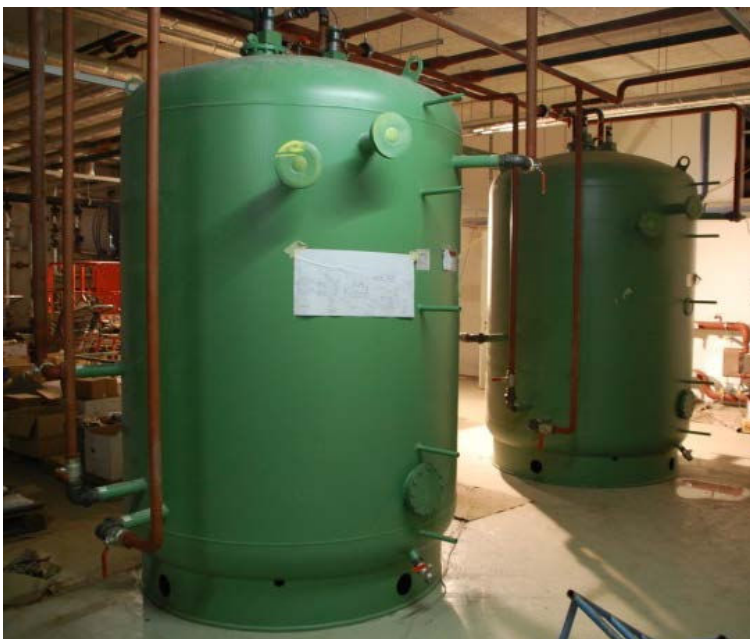
Abbildung 38: Beispiel eines Warmwasserspeichers
