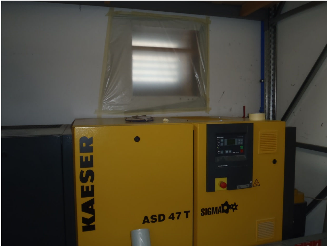
Abbildung 13: Foto des Kompressors bzw. der Druckluftanlage (neu) KAESER ASD 47 T
