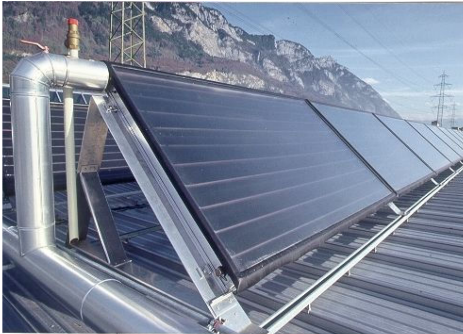
Abbildung 17: Beispielhafte Darstellung der Montage eines solarthermischen Flachkollektors
