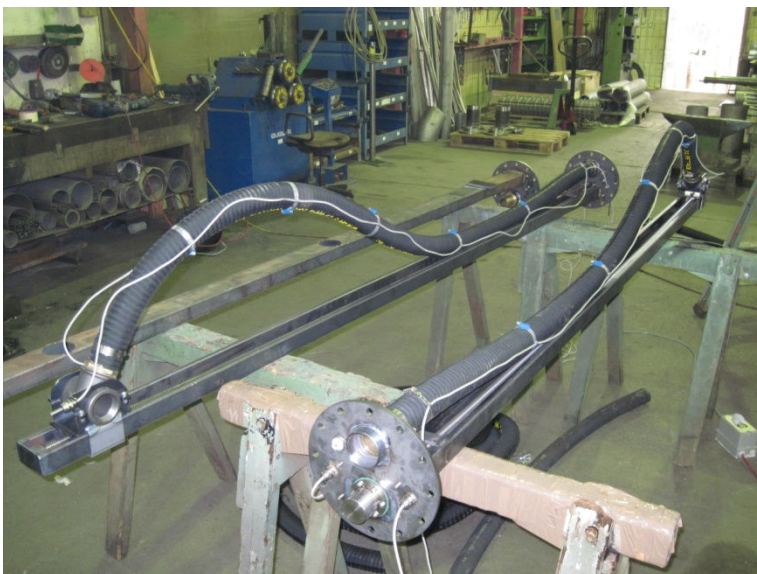
Abbildung 39: Lade- und Entladevorrichtung Warmwasserspeicher
