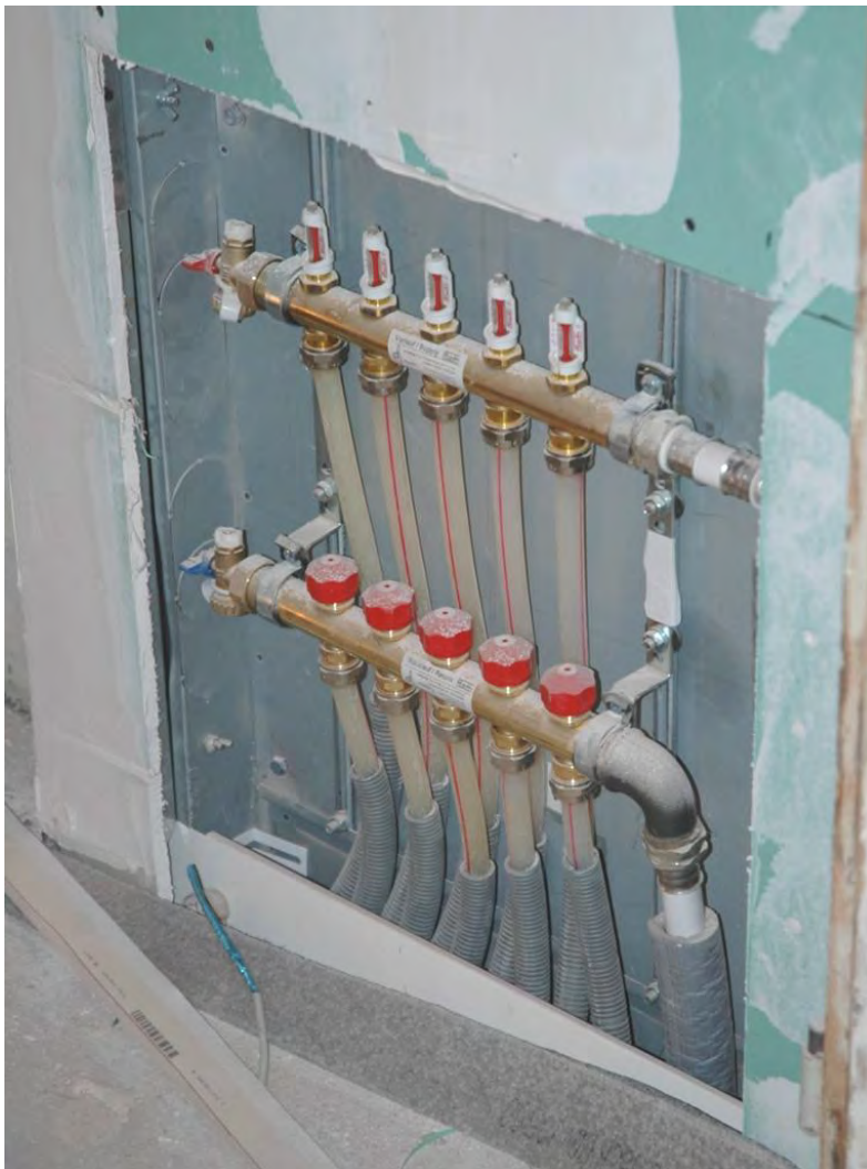
Abb. 7.: Fußbodenheizungsverteiler
