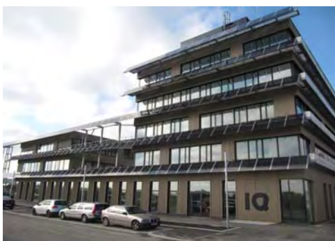
Abbildung 1: Add-On Fassade aspern IQ
