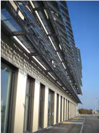
Abbildung 9: Add on - PV Glas-Glas Module
