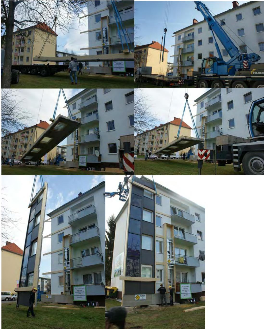
Anordnung des Prototyps 2 an der Westfassade:
