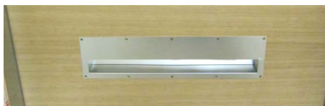
Abbildung 44: Foto der vermessenen Z-Blende.
