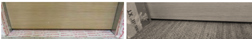
Abbildung 39: Gemessener Türspalt ohne (links) und mit (rechts) Teppich.
