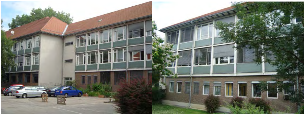
Abbildung 37 Das Haus 12 der LBS Graz St. Peter in Nordwest (links) und Südansicht (rechts)
