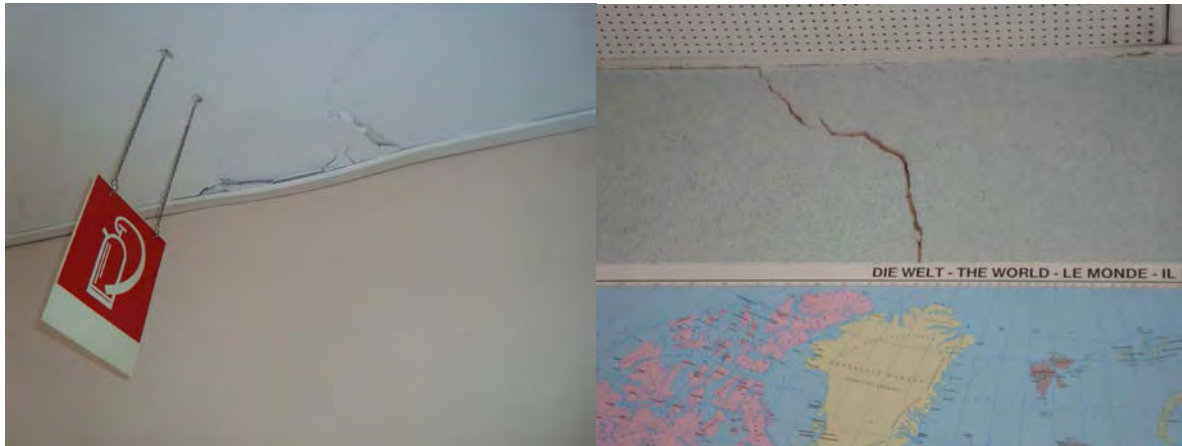
Abbildung 38 Risse in den Decken- und Wandbereichen des Dachgeschoßes (links) und im Kellerbereich (rechts)
