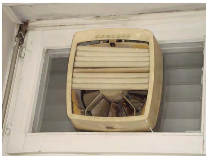
Abbildung 3 Nicht genutzter weil funktionsuntüchtiger Ventilator in einem Klassenzimmer in Graz
