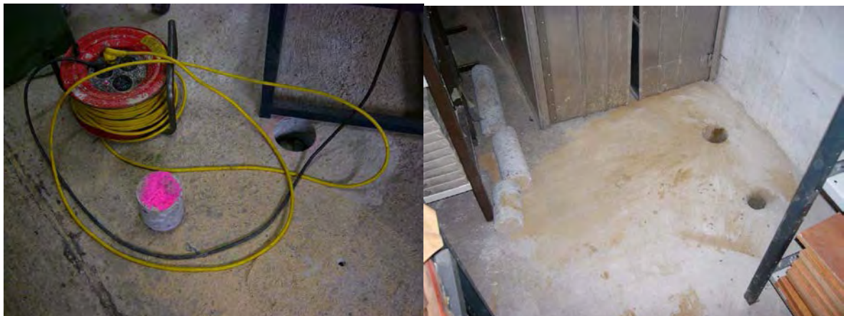
Abbildung 39 Kellerdeckenbohrungen zur Analyse des Bauteil-Aufbaus am 25.10.2005 (Quelle: Arch. Windbichler, LIG)
