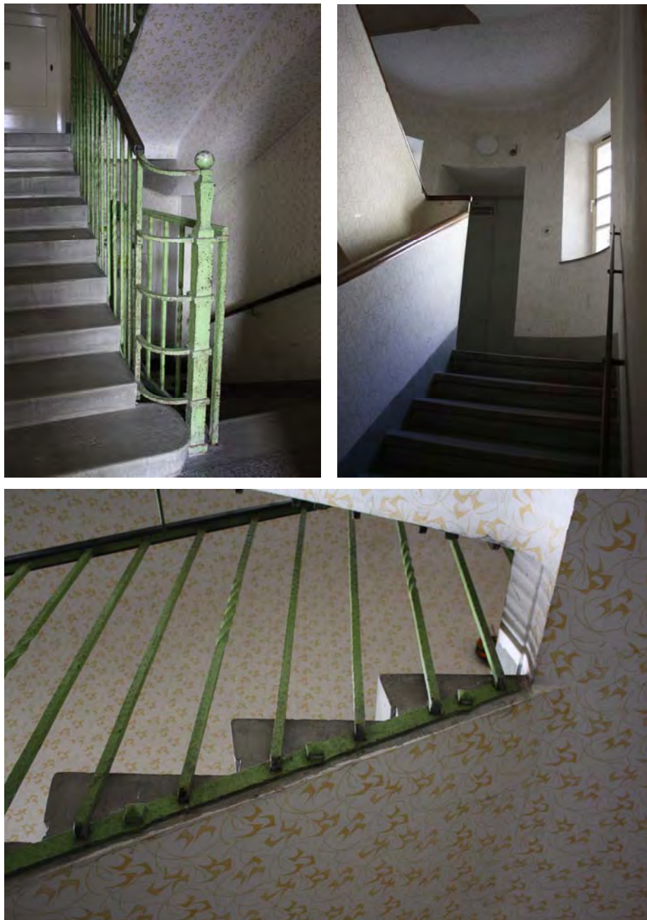
Abbildung 59: Stiegenhaus Heizmann Hof, alle Fotos: M. Lorbek
