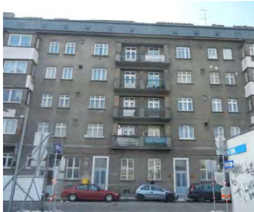
Abbildung 47: Unterschiedliche Fensterelemente Wolmuthstr., Foto: Lorbek
