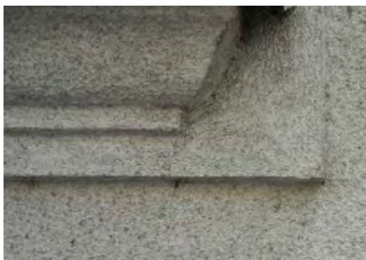
Abbildung 38: Außendämmung im Bereich der Fensterfaschen, Wachauerhof; Foto: M. Lorbek
