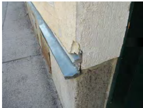
Abbildung 39: Wohnhausanlage Schmelz, Foto: M. Lorbek
