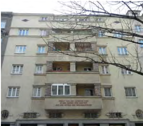
Abbildung 46: Einheitliche Fenstererneuerung Hartkortstrasse, Foto: M. Lorbek
