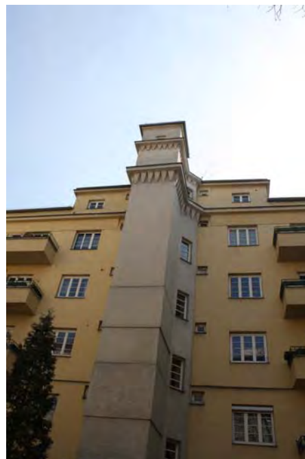
Abbildung 57: Aufwändig angepasster Liftanbau Hermann-Fischer-Hof
