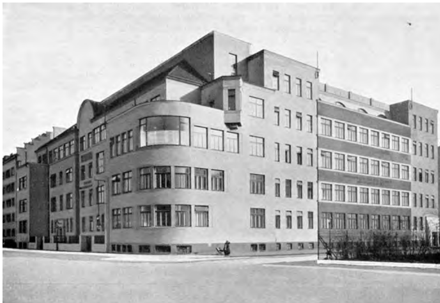
Abbildung 7: Brigittaspital in Wien 20.; Quelle: Das Neue Wien, Wien 1927; S 482
