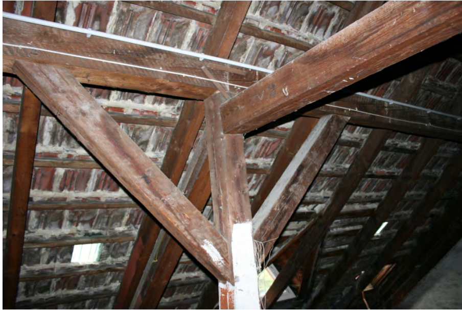
Abbildung 22: Dachstuhl der Wohnhausanlage in der Mollgasse, Foto: M. Höflinger
