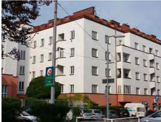
Abbildung 33: Klosehof, nach Sanierung
