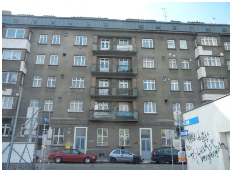
Abbildung 97m Fassade heutiger Zustand, Foto: M. Lorbek
