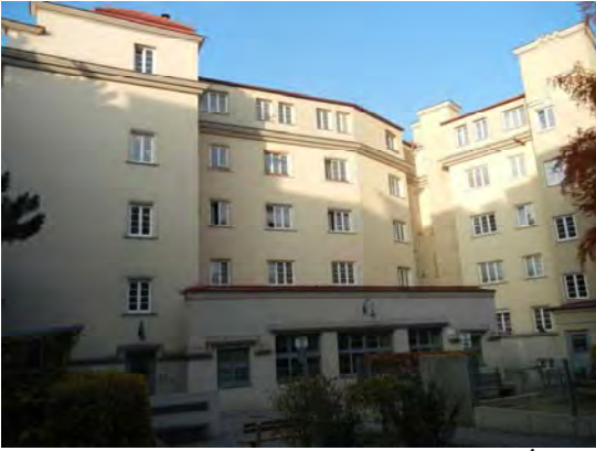
Abbildung 30: Sandleitenhof nach Sanierung 4
