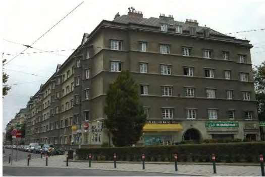
Abbildung 40: Hanuschhof vor der Sanierung; Quelle: Wikipedia
