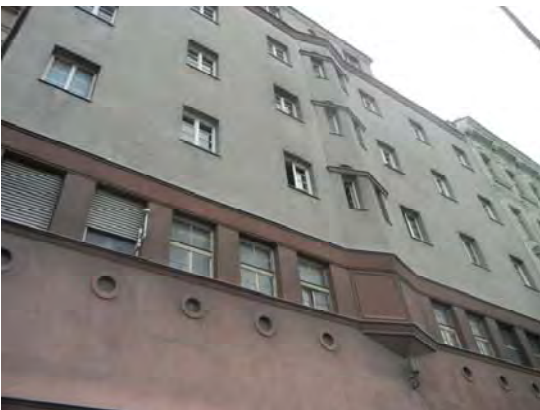
Abbildung 32: Heizmann Hof nach Sanierung,
