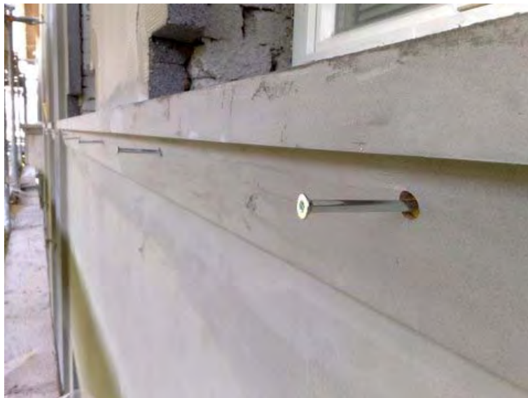
Abbildung 23: Montage Fensterbank-Profile, Malfattigasse 39 (Quelle: Hofer GesmbH)
