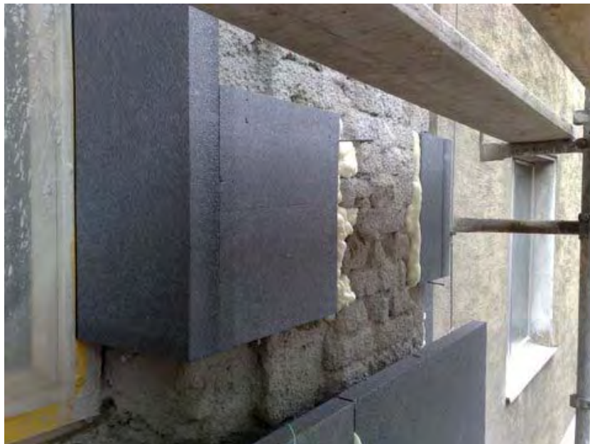
Abbildung 13: Nachbildung der Fassadengrobstruktur mit Dämmplatten, Projekt Malfattigasse 39, Wien (Quelle: Hofer GesmbH)
