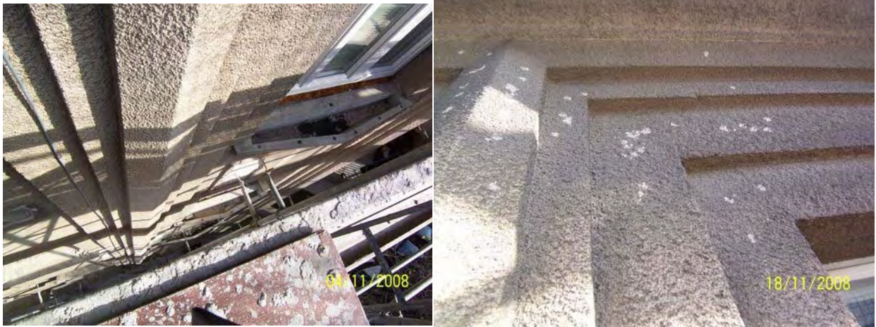
Abbildung 18: Bestandsfassade, Malfattigasse 39 (Quelle: Hofer GesmbH)
