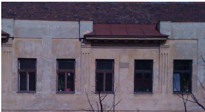
Abbildung 8: tragendes Dachgesimse (Quelle: Schöberl & Pöll GesmbH)
