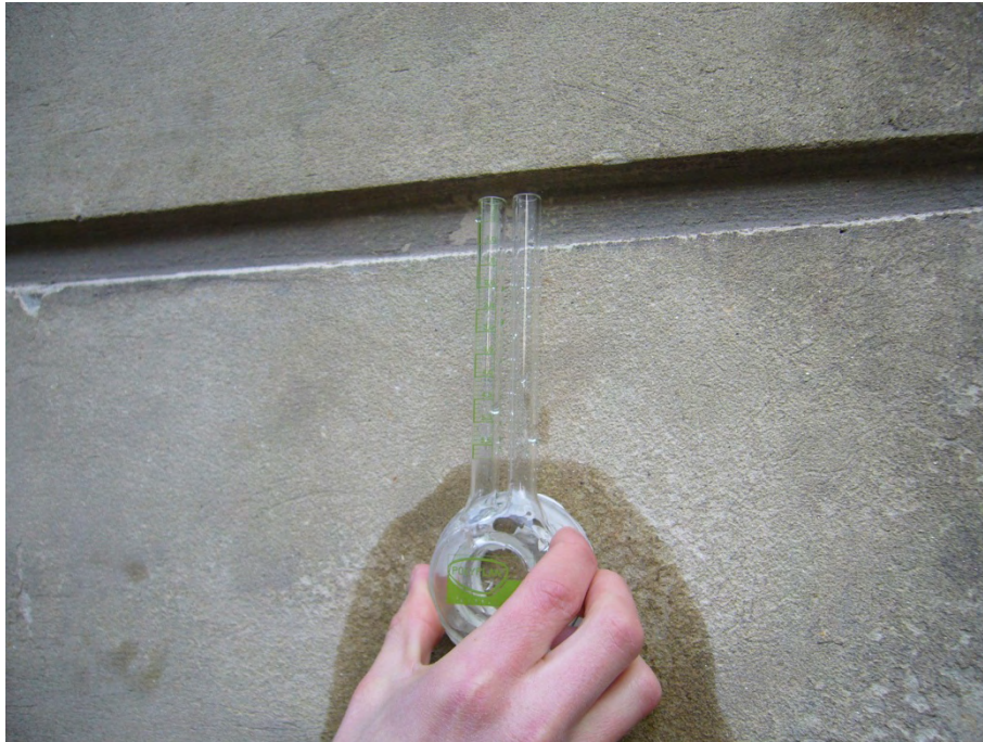
Abbildung 31: Messstelle 1 – Südfassade, EG, Bestandsputz
