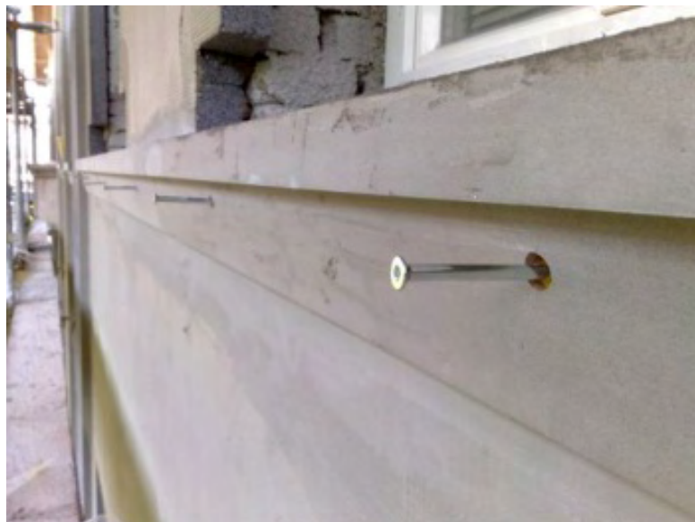
Abbildung 26: Anbringung des Fensterbankprofils, Malfattgasse 39 (Quelle: Hofer GesmbH)
