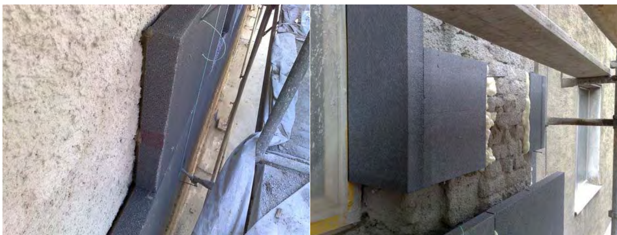
Abbildung 20: Zement-Vorspritzmörtel aufgebracht, Fassadendämmplatten geklebt, Malfattigasse 39 (Quelle: Hofer GesmbH)
