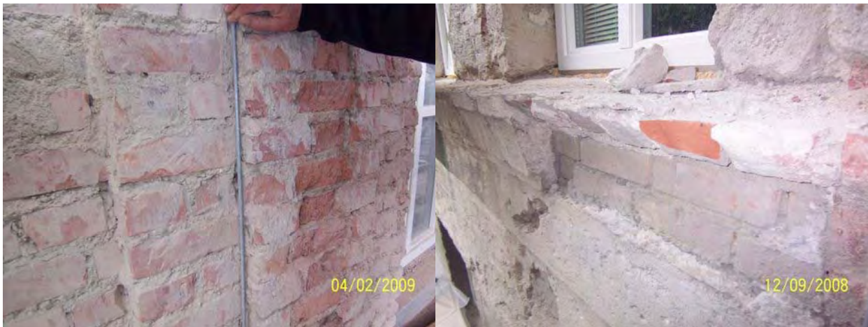
Abbildung 19: Außenputz abgeschlagen, Mauerwerk und Gesimse freigelegt, Malfattigasse 39 (Quelle: Hofer GesmbH)
