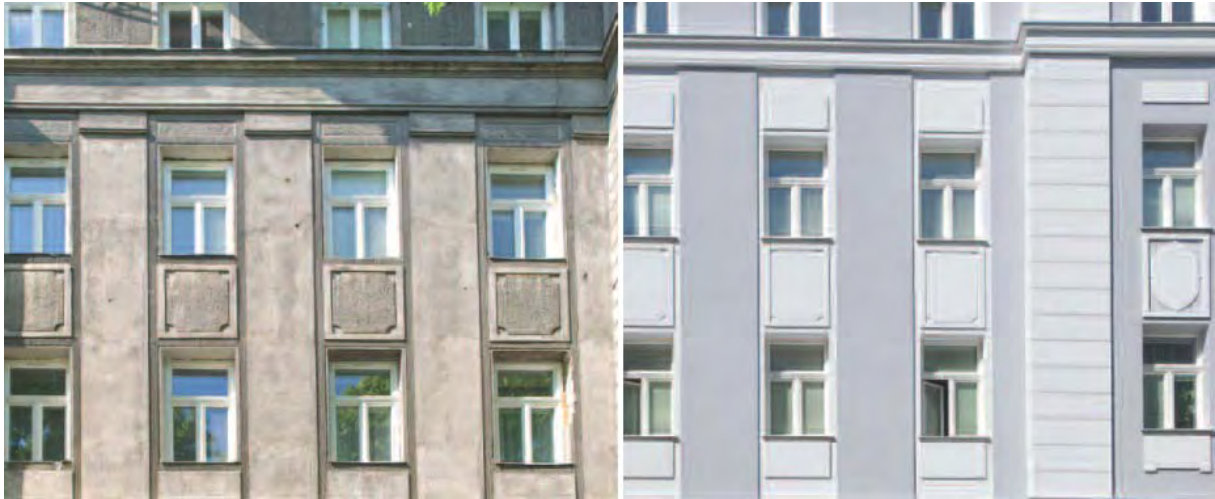
Abbildung 4: Bestandsfassade und sanierte Fassade mit Nachbildung der Fassadenelemente (Quelle: AUSTROTHERM GmbH)
