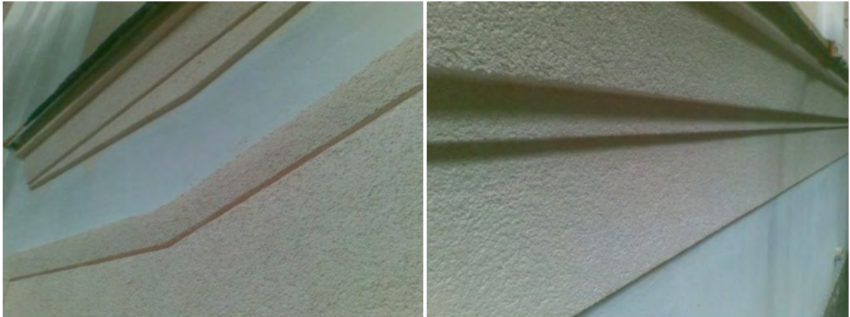
Abbildung 27: Profile und Fassade verputzt, Malfattigasse 39 (Quelle: Hofer GesmbH)
