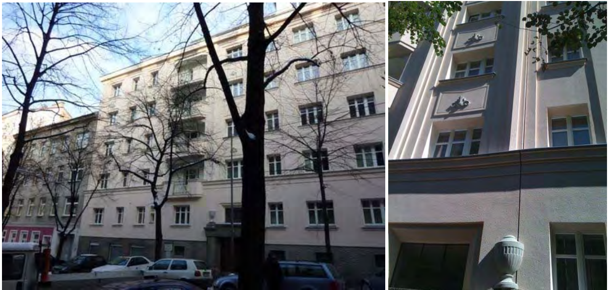
Abbildung 15: Malfattigasse 39, sanierte Fassade (Quelle: Hofer GesmbH)
