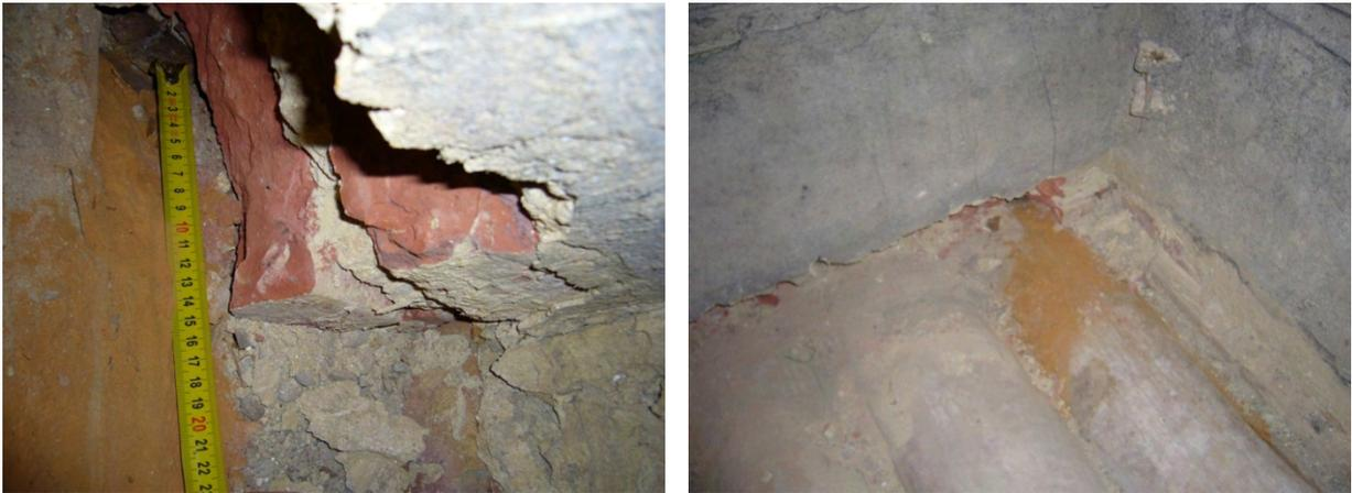
Abbildung 12: Dippelbaumdecke – Auflagerbereich (Foto: Schöberl & Pöll GmbH)
