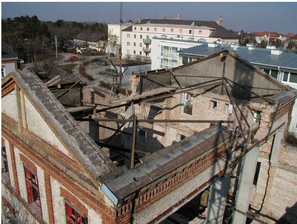
Abbrucharbeiten – Fassadenreste – Aussteifungsarbeiten Bauteil A
