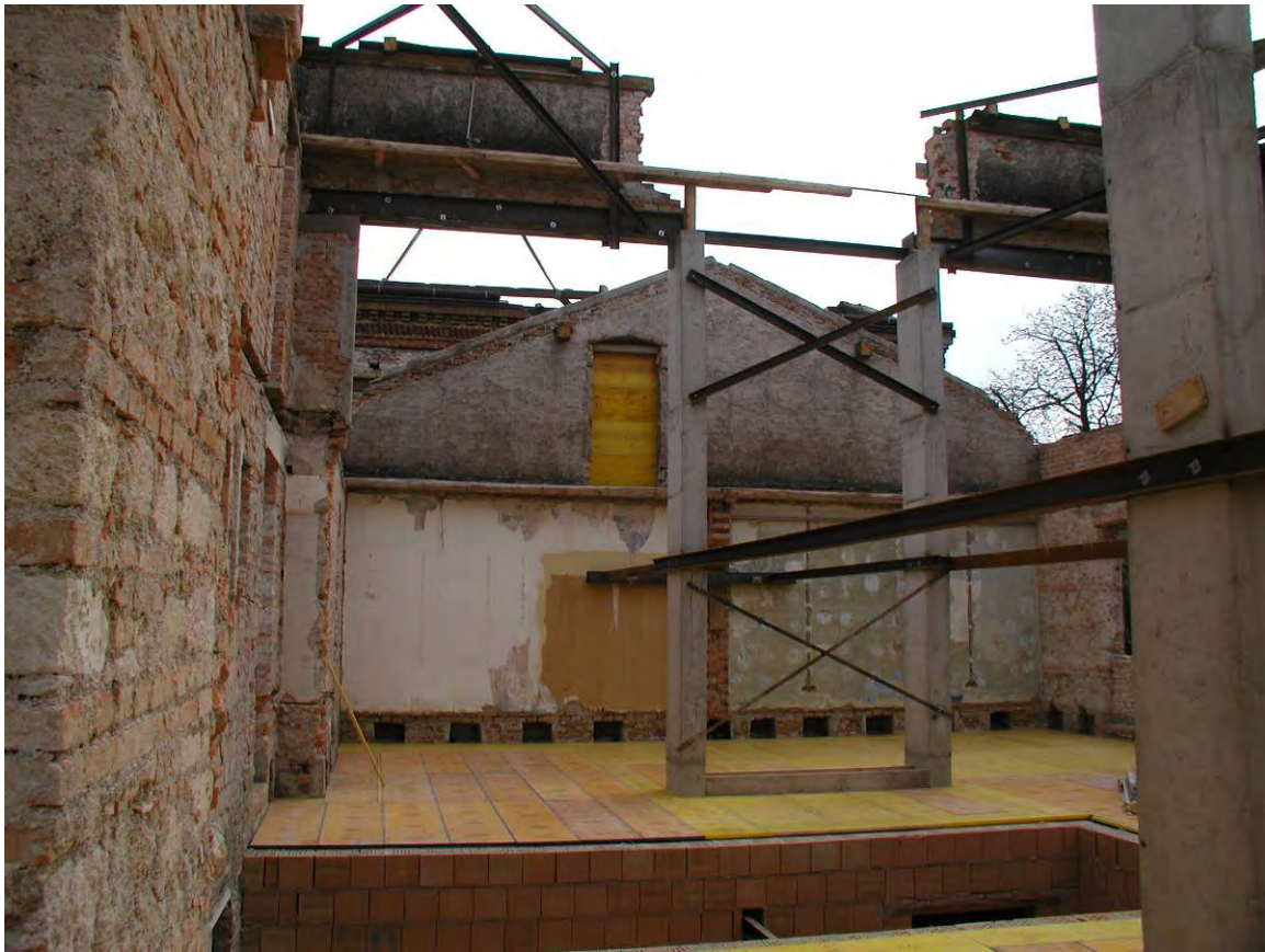
Schalungsarbeiten Decke und EG Bauteil A
