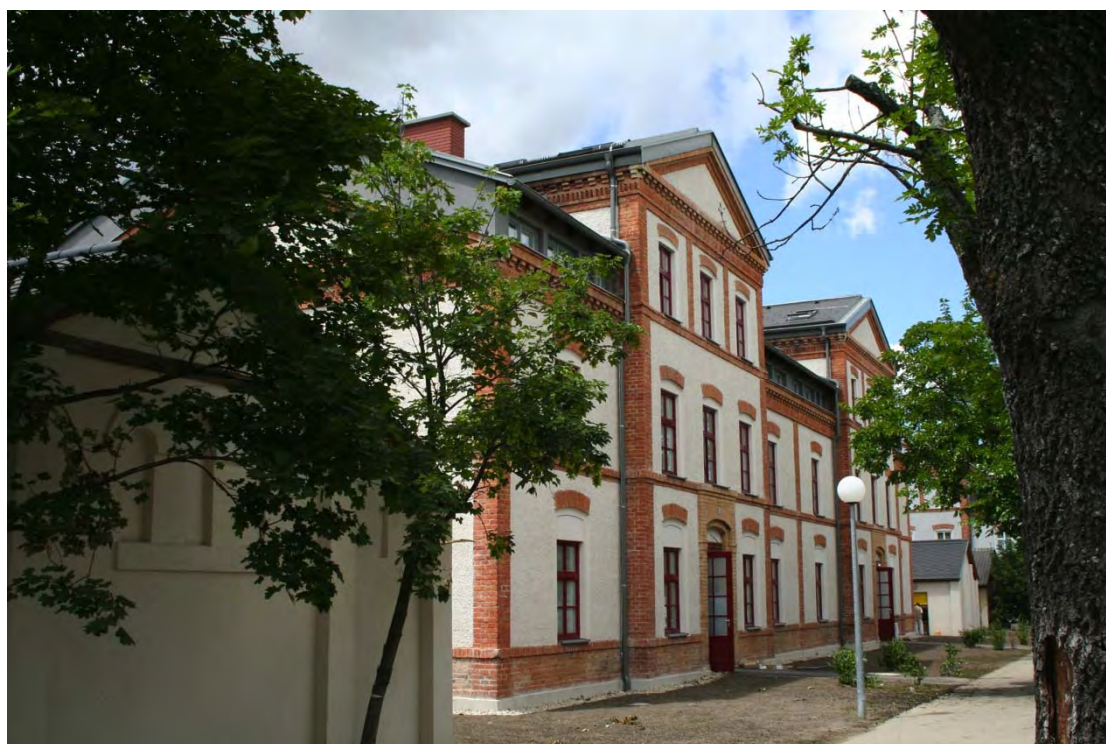
Saniertes Objekt Bauteil A
