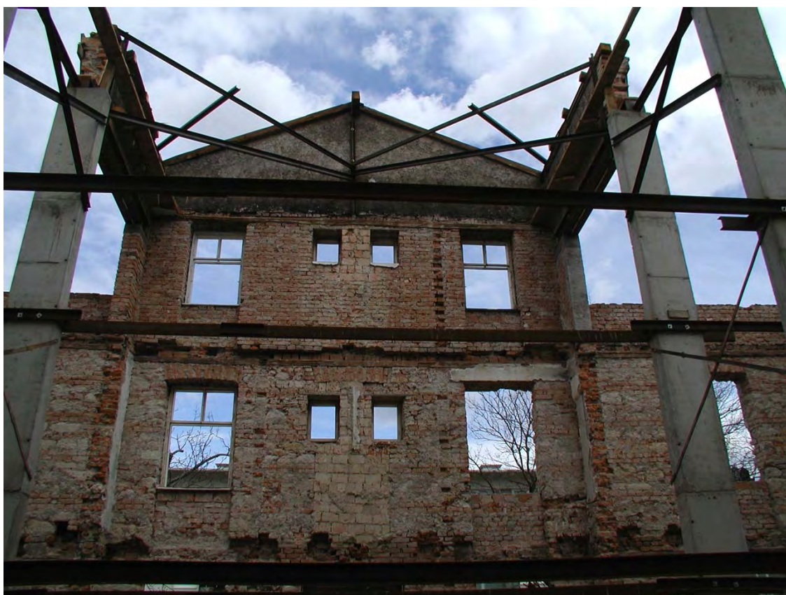
Abbrucharbeiten – Fassadenreste – Aussteifungsarbeiten Bauteil A
