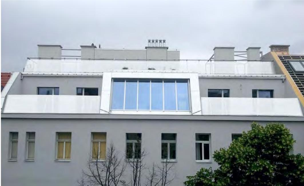
**Abbildung 23: Umsetzungsbeispiel: Plus-Energie-Dachgeschossausbau eines typischen Wiener Gründerzeithauses in der Ybbsstraße in Wien. Das Projekt soll die Anwendbarkeit des Plus-Energie-Konzeptes auf Dachgeschoßausbauten von Gründerzeithäusern aufzeigen. (© Schöberl und Pöll GmbH)**
