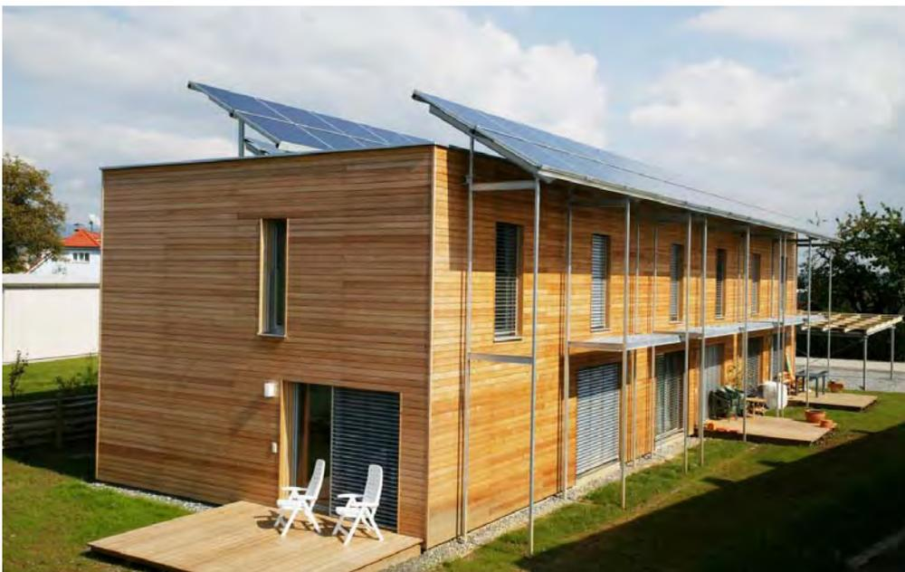
**Abbildung 21: Umsetzungsbeispiel: Plusenergie-Reihenhausanlage in Weiz in der Steiermark. Die 24 Holzfertigteilegebäude wurden in Passivhausqualität ausgeführt. Sie decken mit ihrer**
