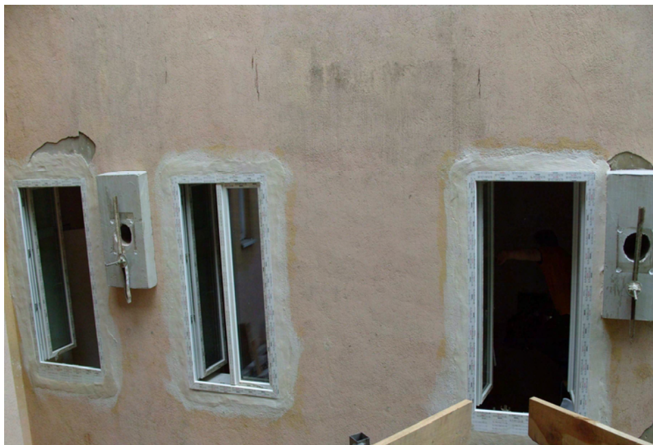
Abbildung 2-4: Foto, Außenfassade Raum Top 06b mit Lüfteröffnungen
