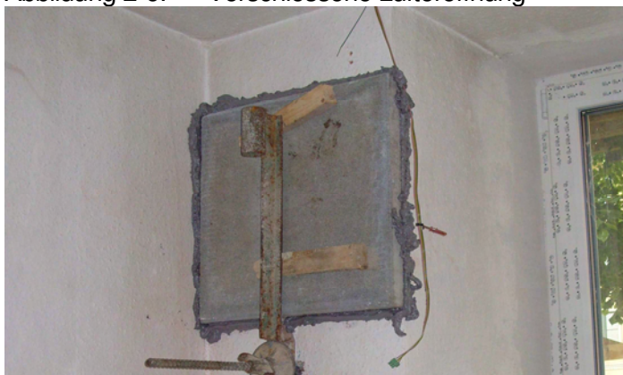
Abbildung 2-6: Verschlussene Lüfteröffnung
