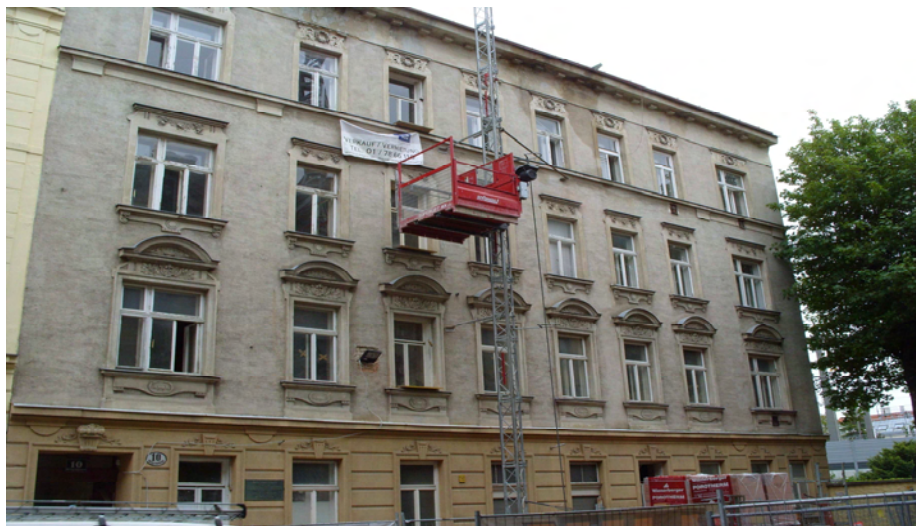
Abbildung 1-1: Wohnhaus Wißgrillgasse 10, 1140 Wien
