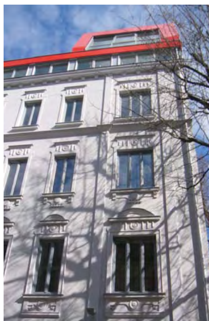
Abbildung 12: Ansicht Fassade (Foto: e7)
