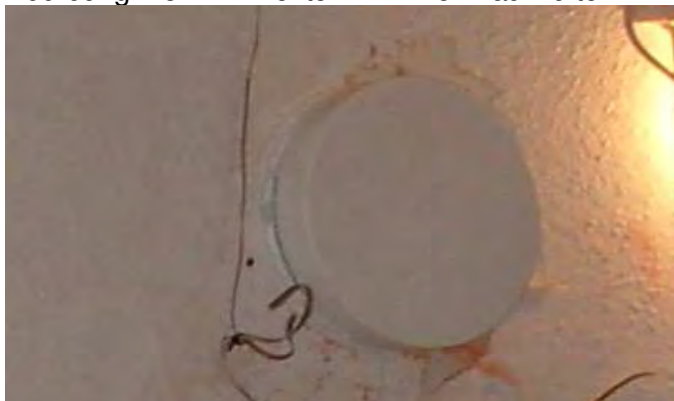
Abbildung 2-5: InVenter iV14 Wohnraumlüfter
