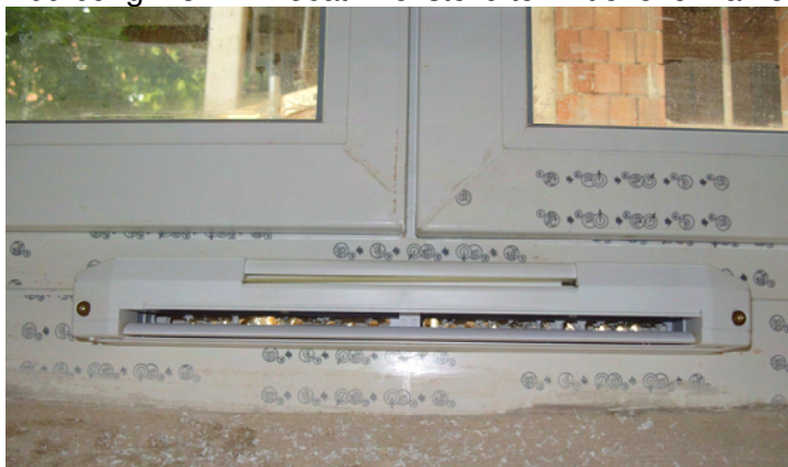
Abbildung 2-8: Krobath Fensterlüfter mit offener Lamelle
