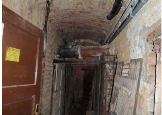
Abbildung 3: Kellergeschoß Bestandsgebäude (Foto: Gassner & Partner)
