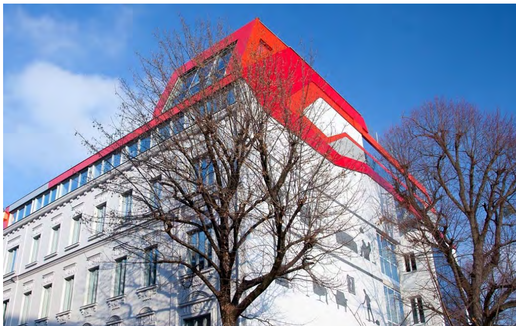
Abbildung 11: Gründerzeithaus Wißgrillgasse nach der Sanierung (Foto: Gassner & Partner)
