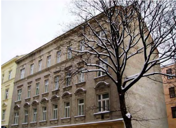
Abbildung 2: Bestandsgebäude Straßenansicht (Foto: Gassner & Partner)
