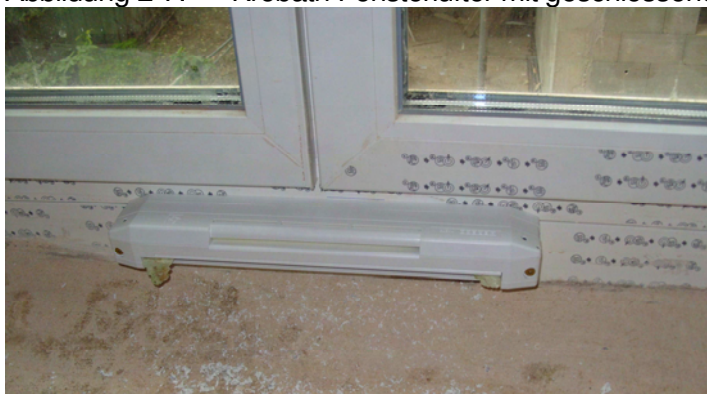
Abbildung 2-7: Krobath Fensterlüfter mit geschlossener Lamelle
