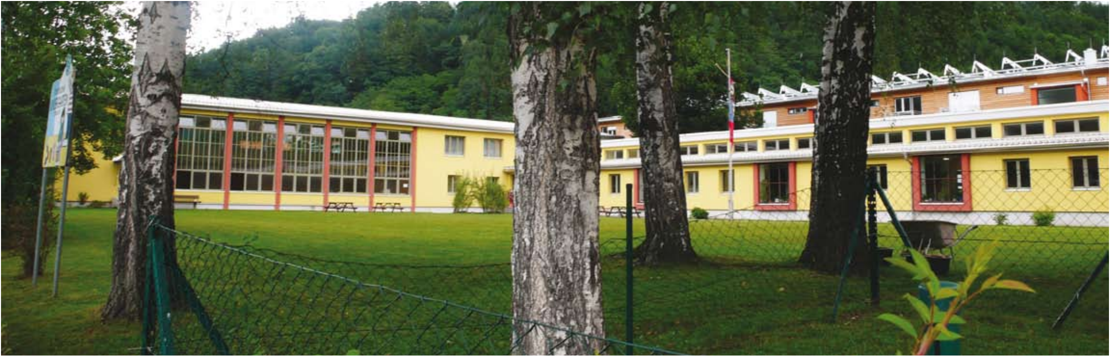
Sanierungsinitiative Gemeinde Kapfenberg (Stmk) - thermische Sanierung der Schule Diemlach unter der Federführung von DI Sabine Christian, Bereichsleitung Raumplanung Gemeinde Kapfenberg
