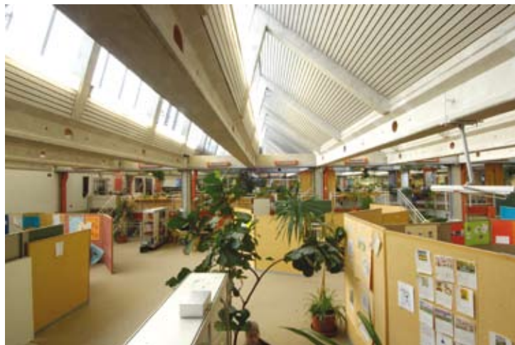
Futurum-Schule: Die satteldachförmigen Aufbauten sind ehemalige Lichthöfe, die im Zuge des Umbaus mit Glas überdacht wurden. Foto: Hans Ahlenius, Futurum
