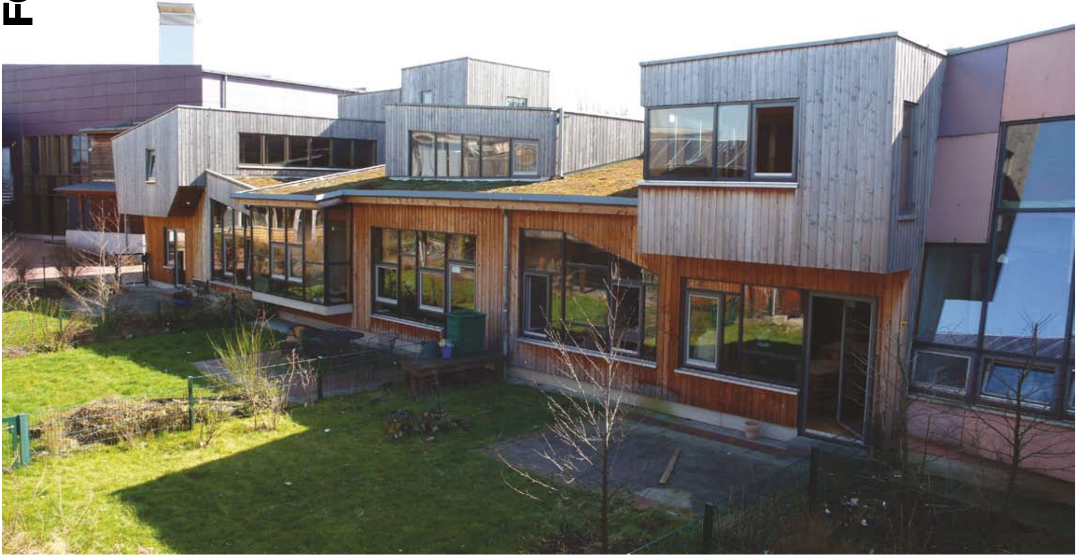
Die Lernhäuser der Evangelischen Gesamtschule Gelsenkirchen, errichtet 1998 bis 2004 von Peter Hübner, plus+ Bauplanung, zusammen mit den Schülern. Foto: Robert Temel
