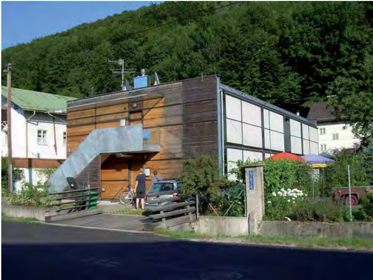
Abb. 9: Mehrfamilienhaus Salzburg - Gnigl, CEPHEUS - Projekt, Straßenansicht
