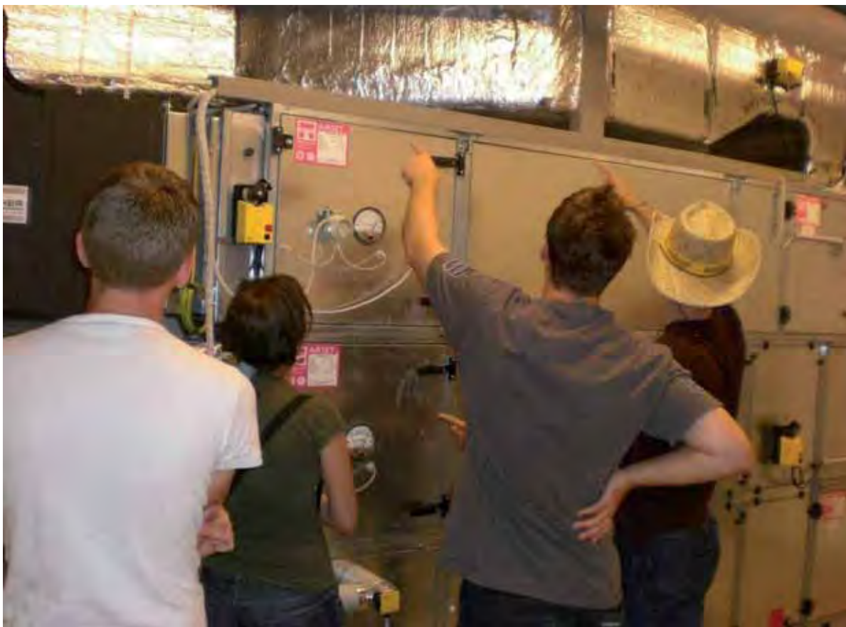
Abb. 13: ... und beantwortet Fragen zur Lüftungsanlage mit Wärmerückgewinnung
