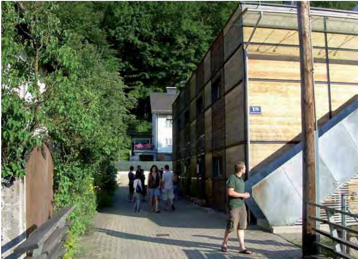
Abb. 10: Rundgang um das Mehrfamilienhaus
