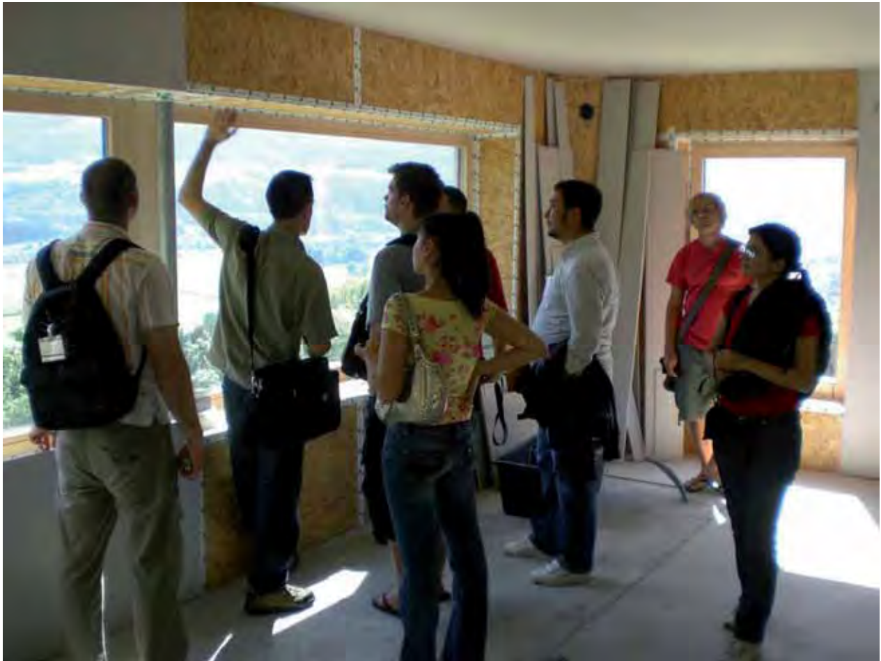
Abb. 3: Begutachtung der luftdichten Ebene
