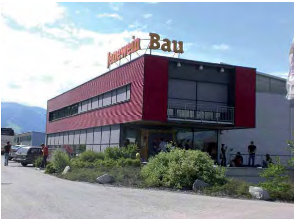
Abb. 31: Südostansicht des Betriebsgebäudes der Baufirma Jenewein
