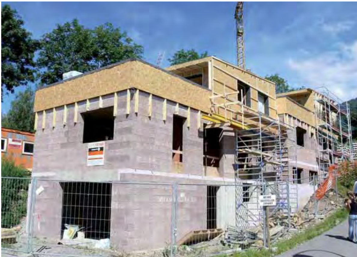
Abb. 7: Mantelbeton-Rohbau mit Holzleichtbau-Elementen
