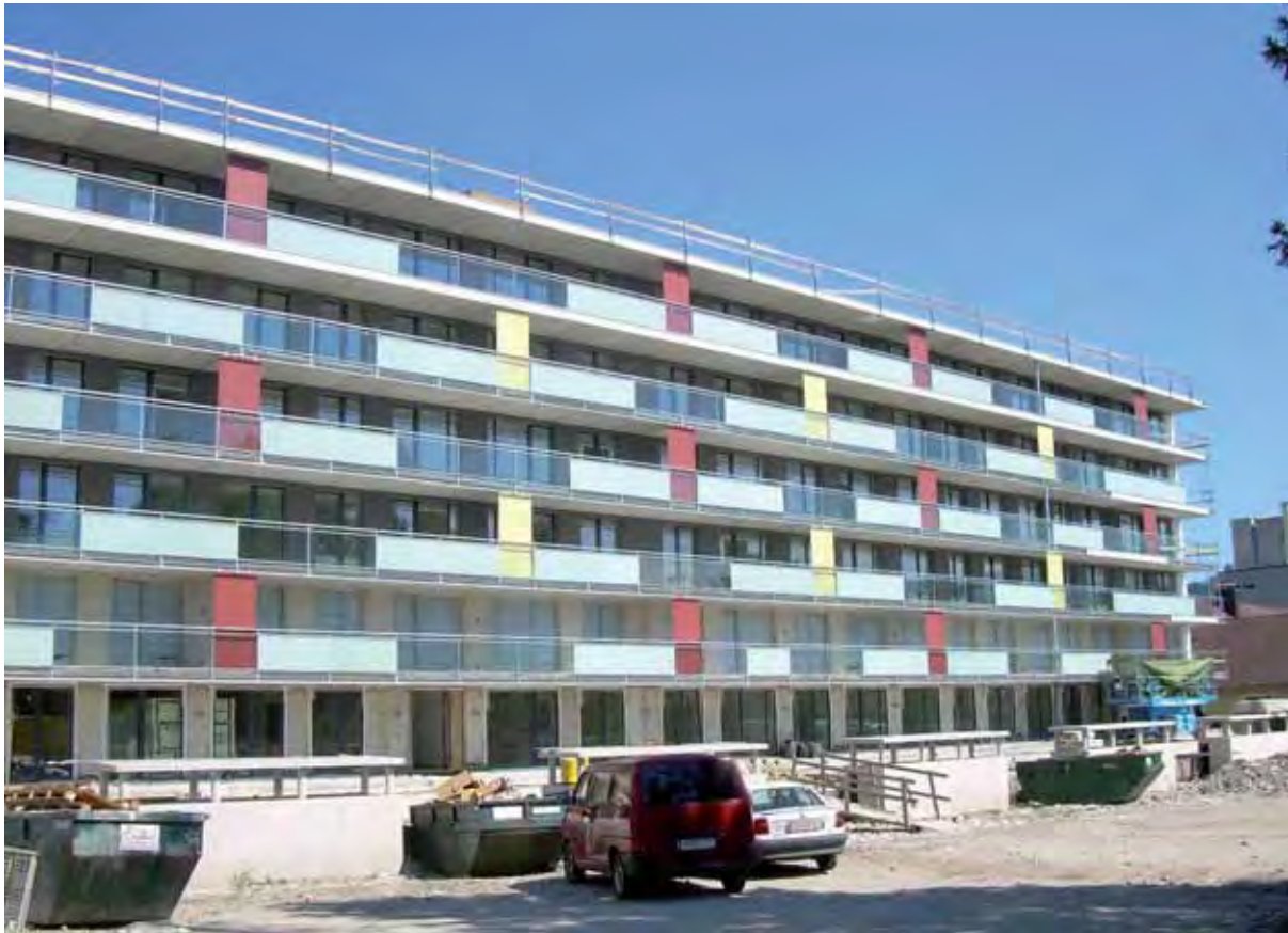
Abb. 3: Ansicht der Baustelle Mehrfamilienhaus Salzburg, „low - budget - living“
