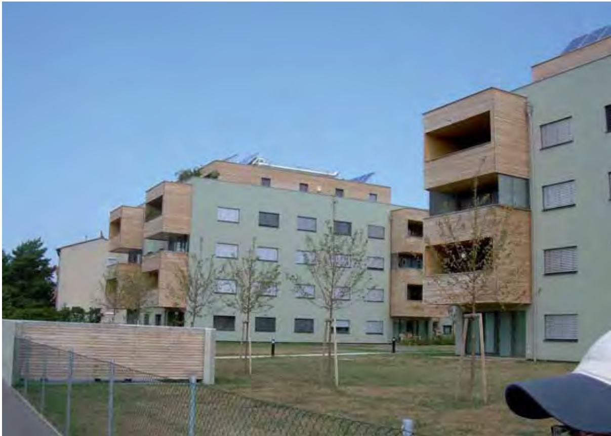
Abb. 40: Mehrfamilienhäuser Wien 21 - Mühlweg, Rundgang
