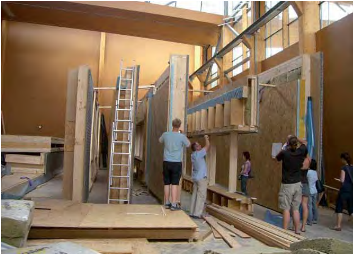
Abb. 26: Besichtigung der Entstehung der Wandelemente für das Schulzentrum Schwanenstadt
