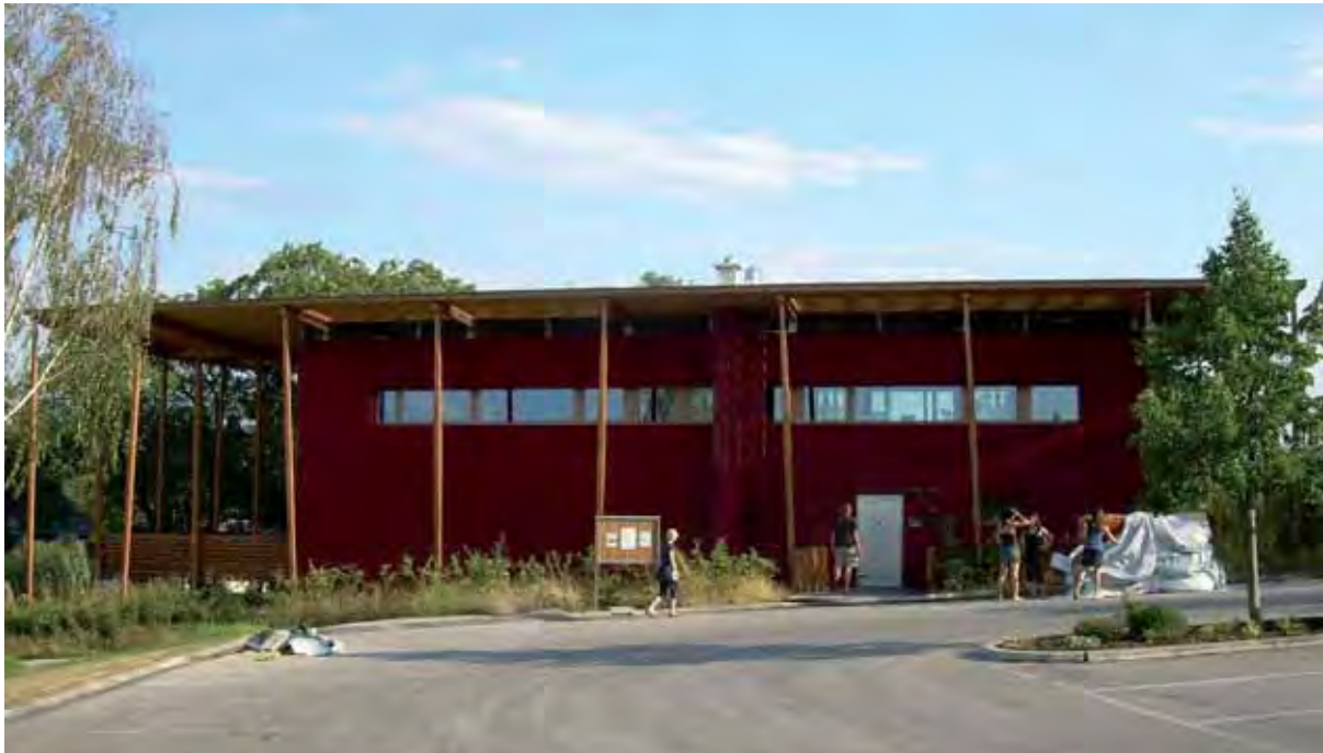
Abb. 35: S-House - Böheimkirchen, Ansicht N
