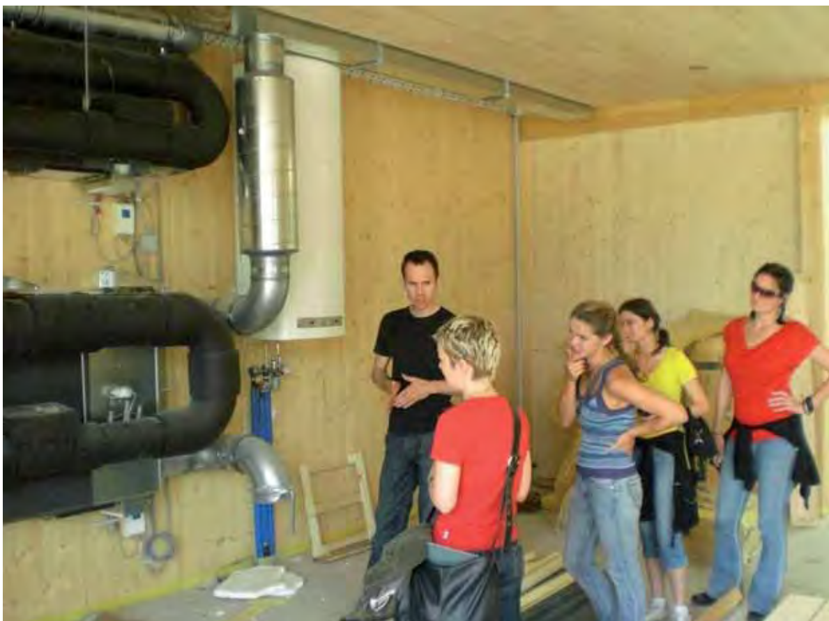
Abb. 30: ... wie auch von Lüftungsdetails.
