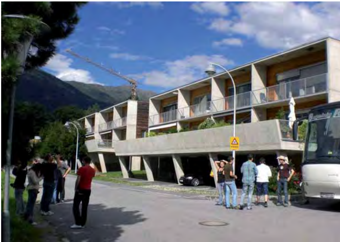
Abb.1 :Vor der Reihenhausanlage Patriasdorf in Lienz
