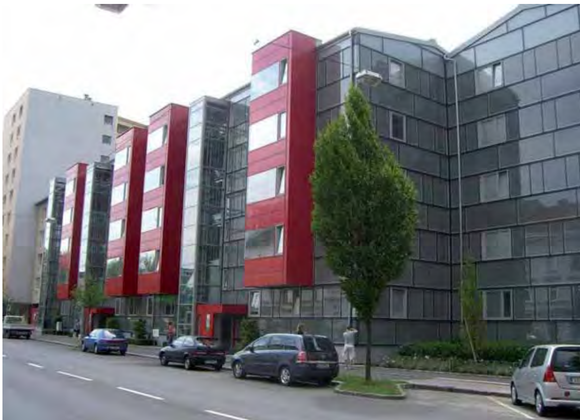
Abb. 32: Besichtigung der Sanierung Wohnhausanlage Makartstraße, Linz
