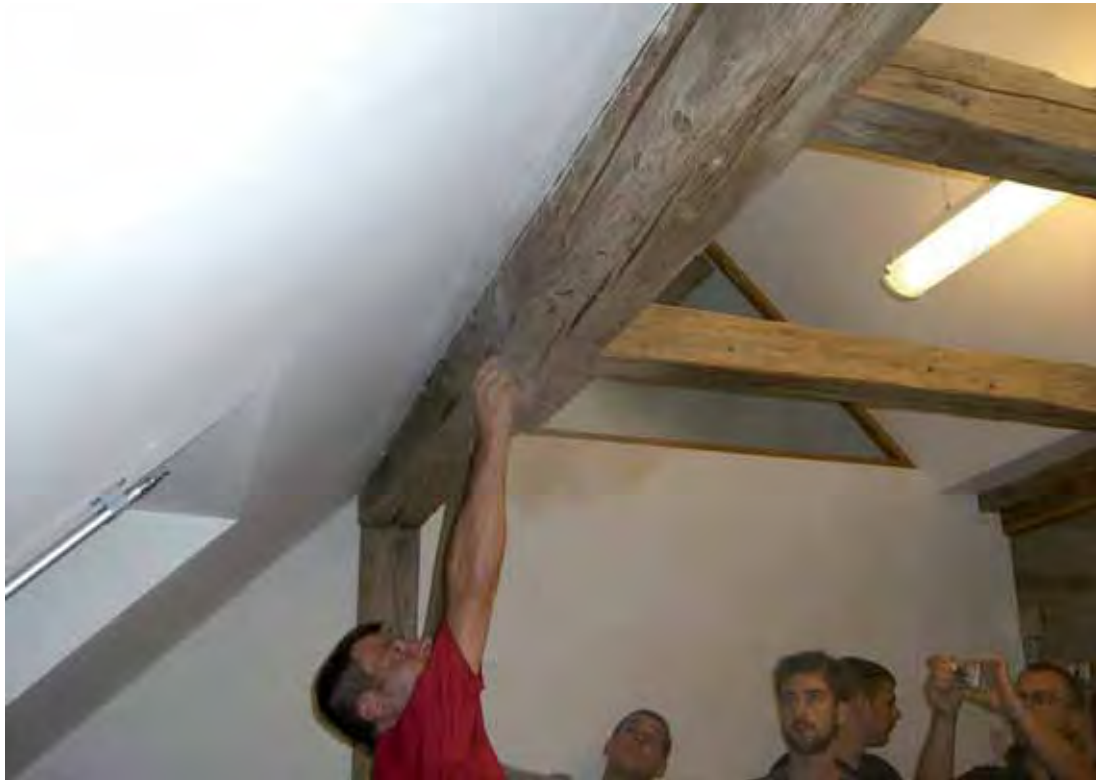
Abb. 29: Suche nach Leckagen mit Kaltrauch bei Unterdruck
