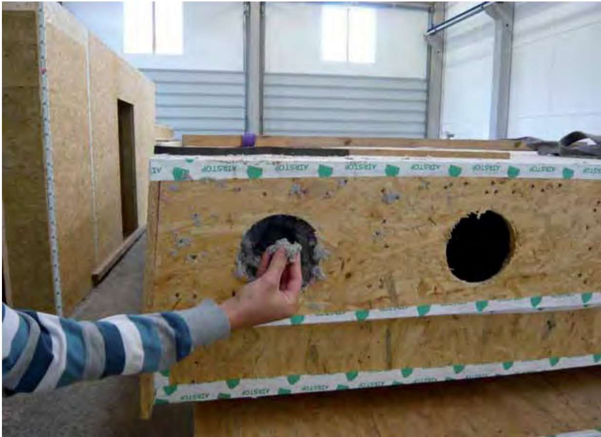
Abb. 13: Begutachtung der verfüllten Zellulosedämmung
