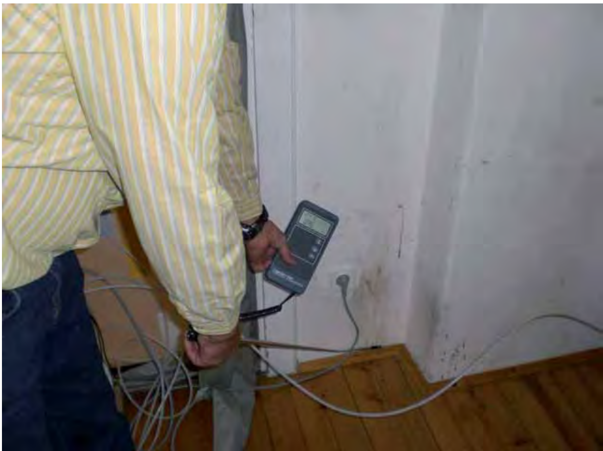
Abb. 21: Messung von Anschlussfugen
