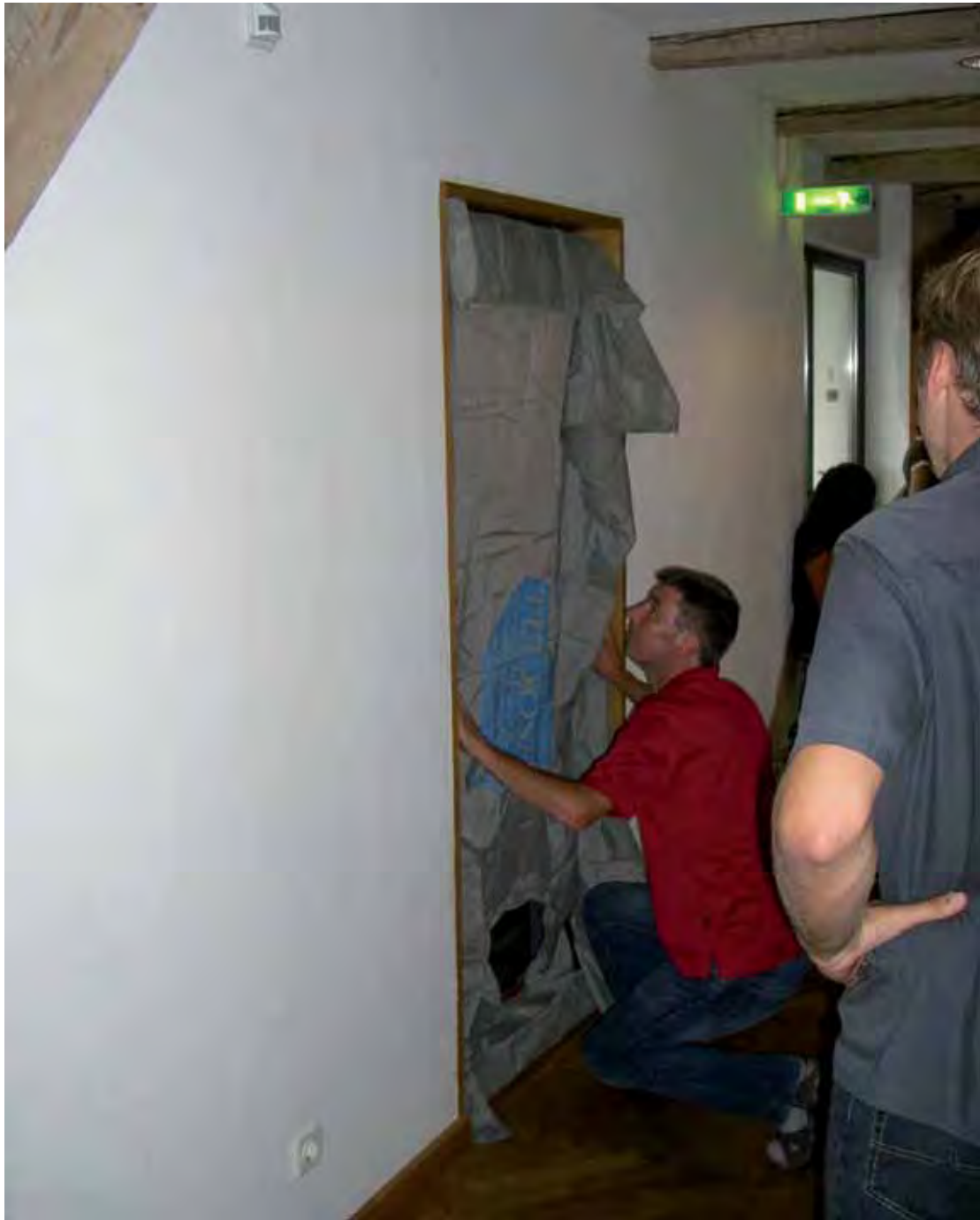
Abb. 28: Vorbereitung des Differenzdruckaufbaus
