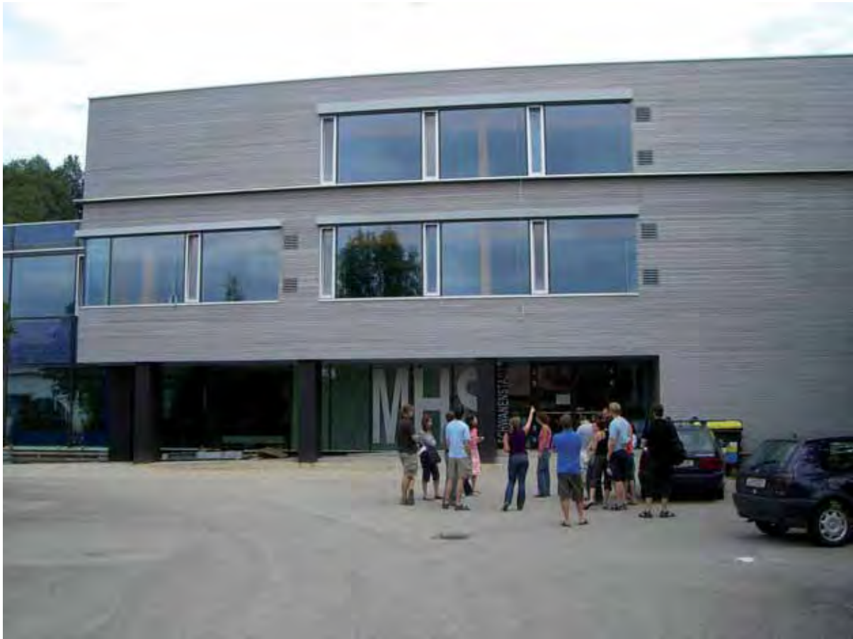
Abb. 19: Schulzentrum Schwanenstadt, Besichtigung des sanierten Bauabschnitts
