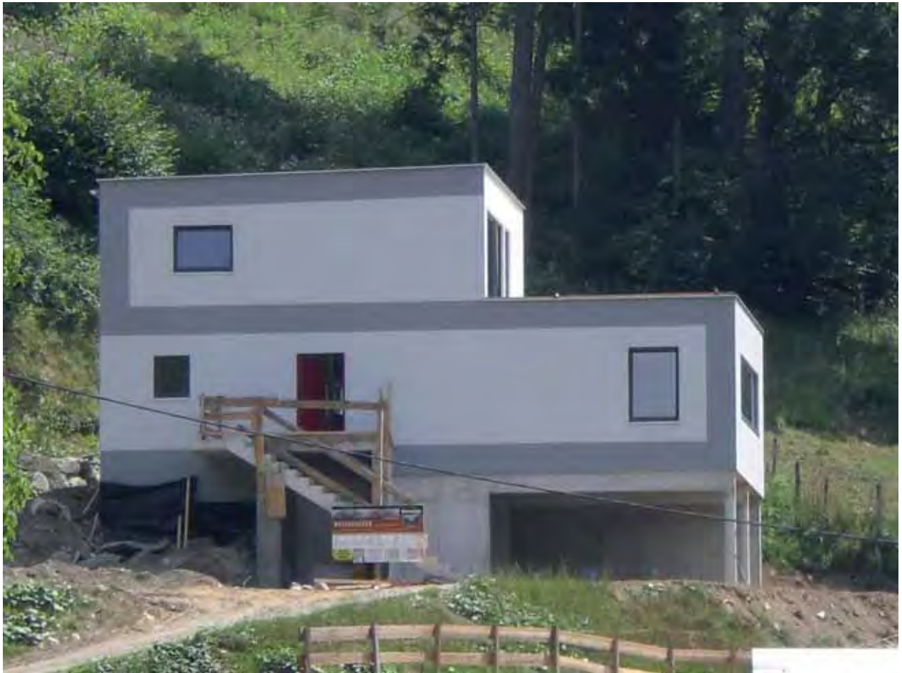
Abb. 2: Westansicht der Baustelle für das Einfamilienhaus S.,
