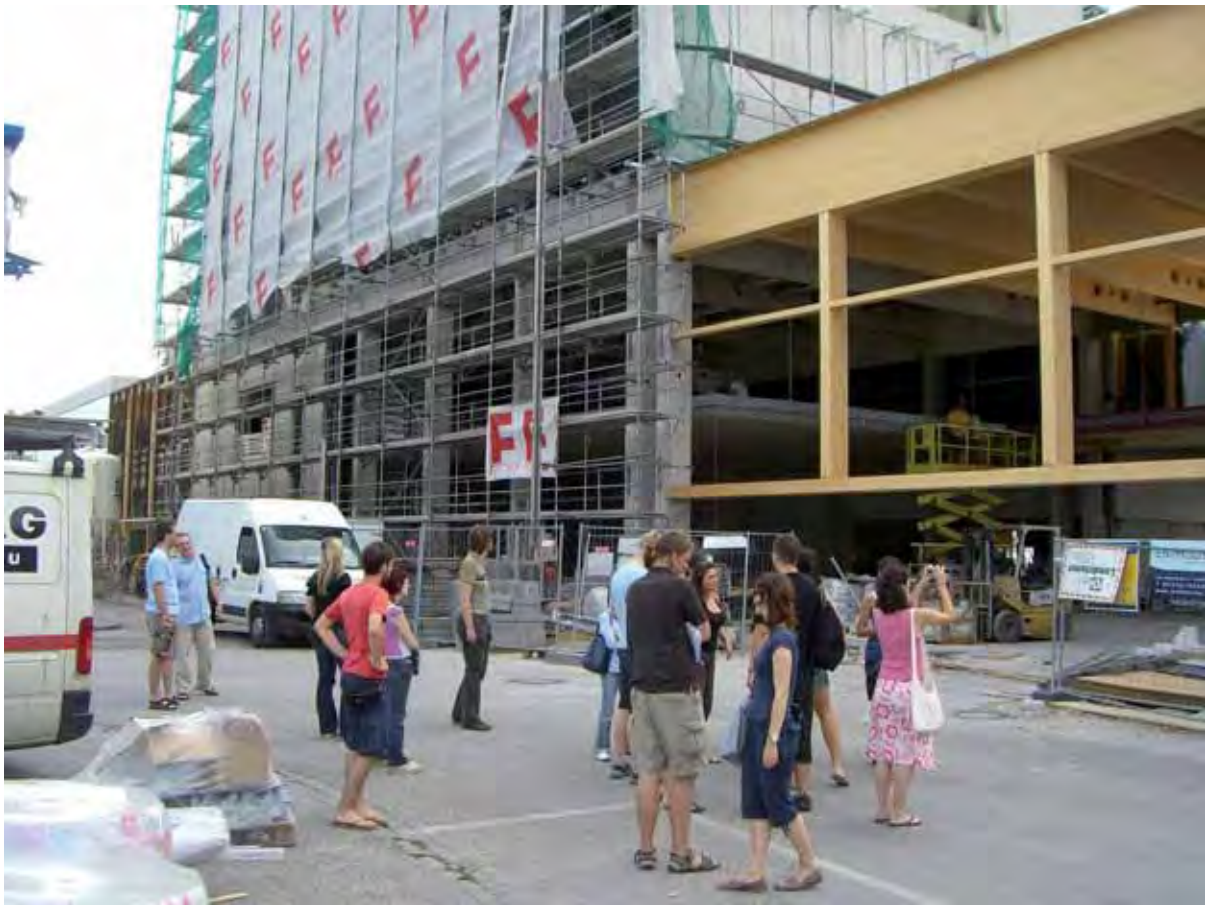
Abb. 17: Baustellenbesichtigung des Eingangsbereichs
