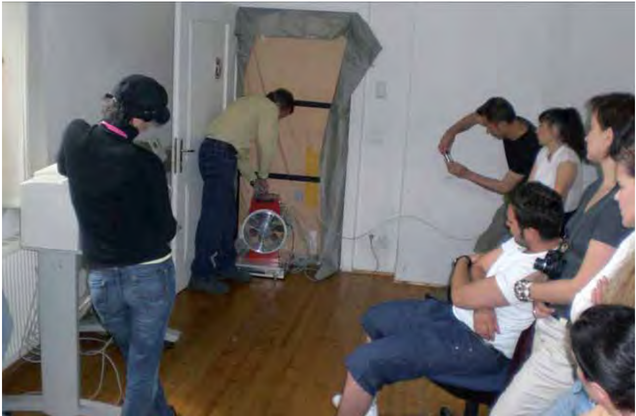
Abb. 18: Einbau des Messventilators in die Folientürfüllung
