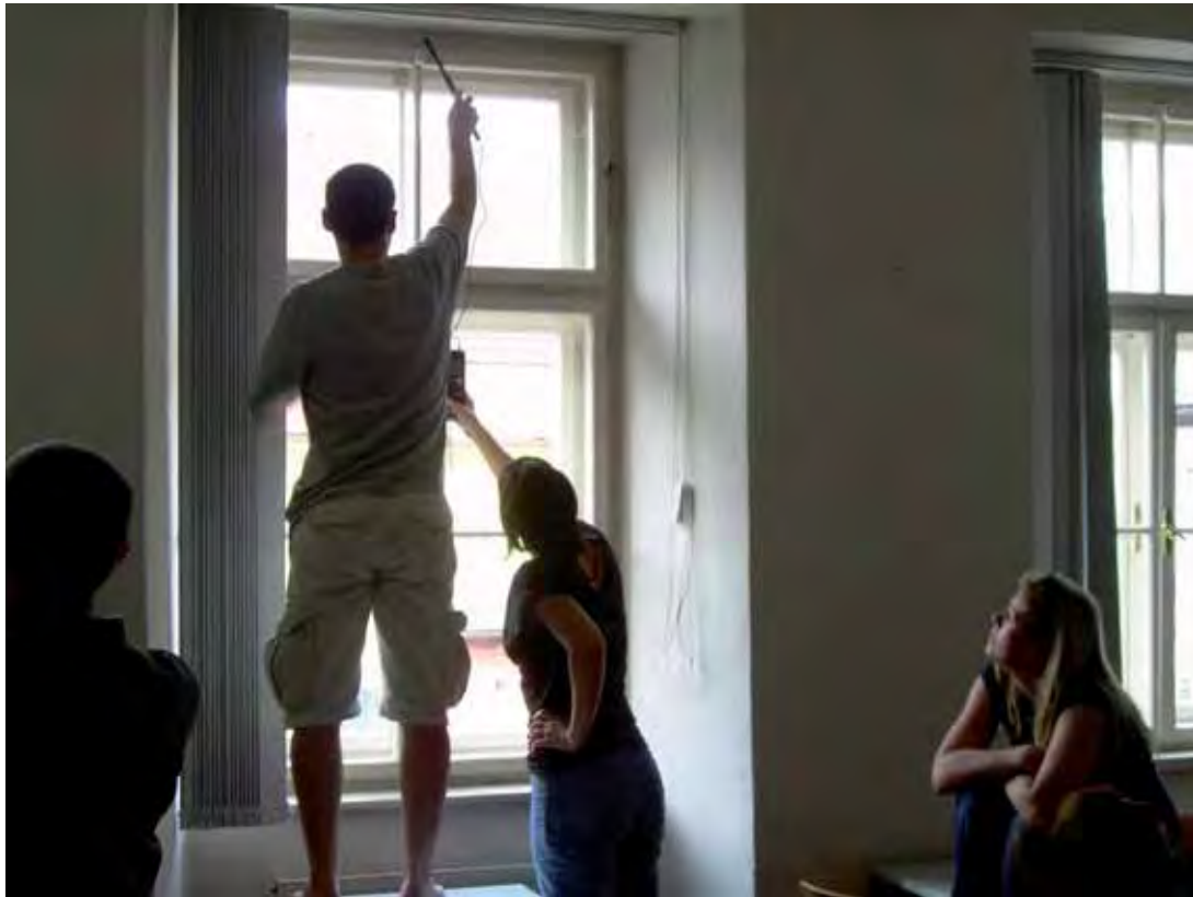
Abb. 27: Suche nach Leckagen mit Anemometer bei Überdruck
