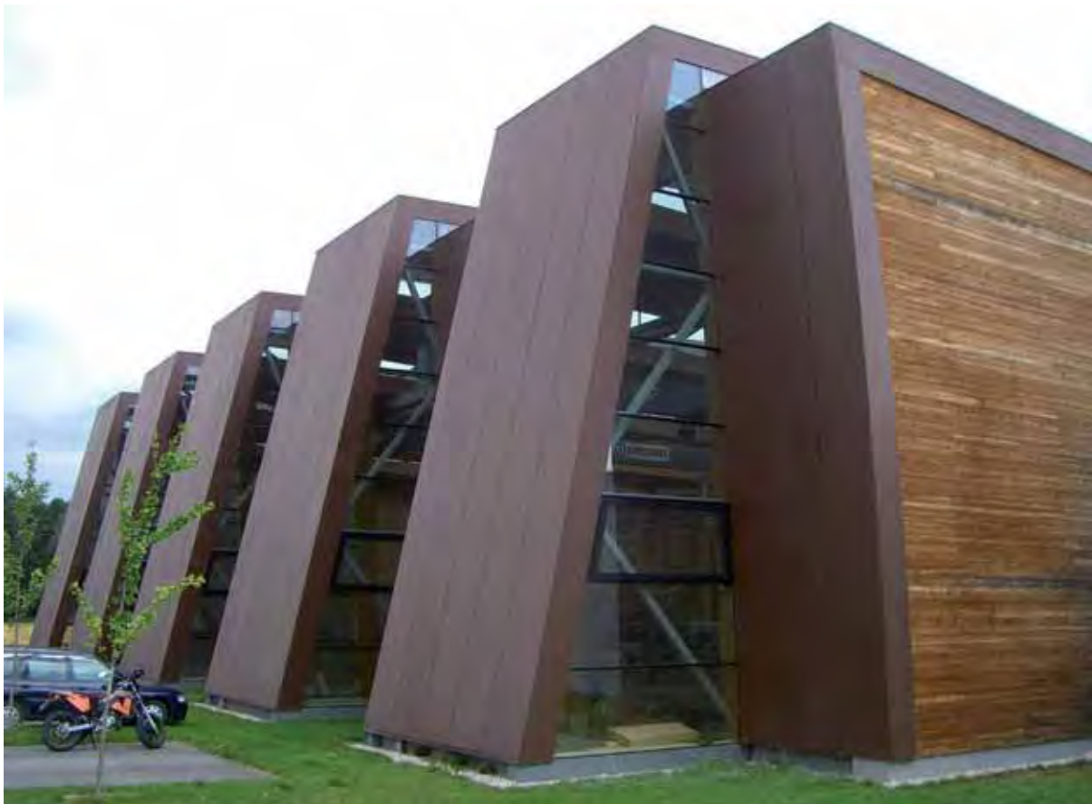
Abb. 23: Produktionshalle Fa. Obermayr, Schwanenstadt, Außenansicht
