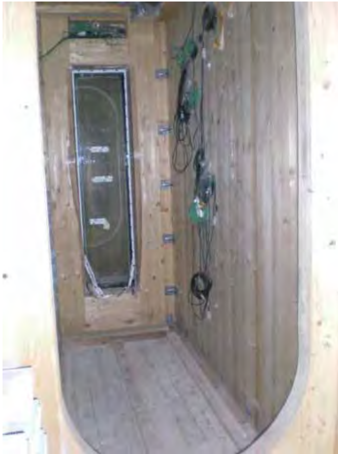
Abb. 18: Blick in das Unter-Wasser-Untergeschoss mit Messsonden
