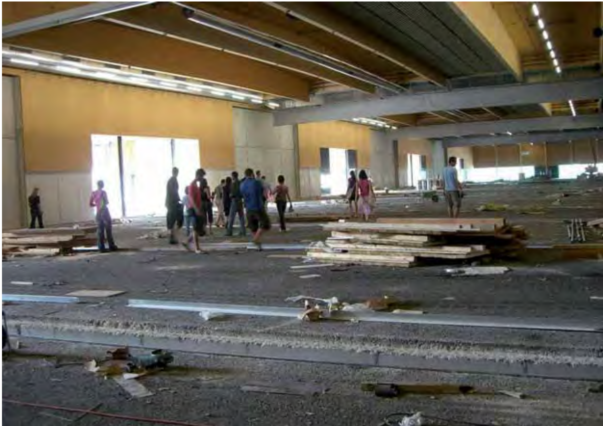
Abb. 18: Baustellenbesichtigung neue Messehalle
