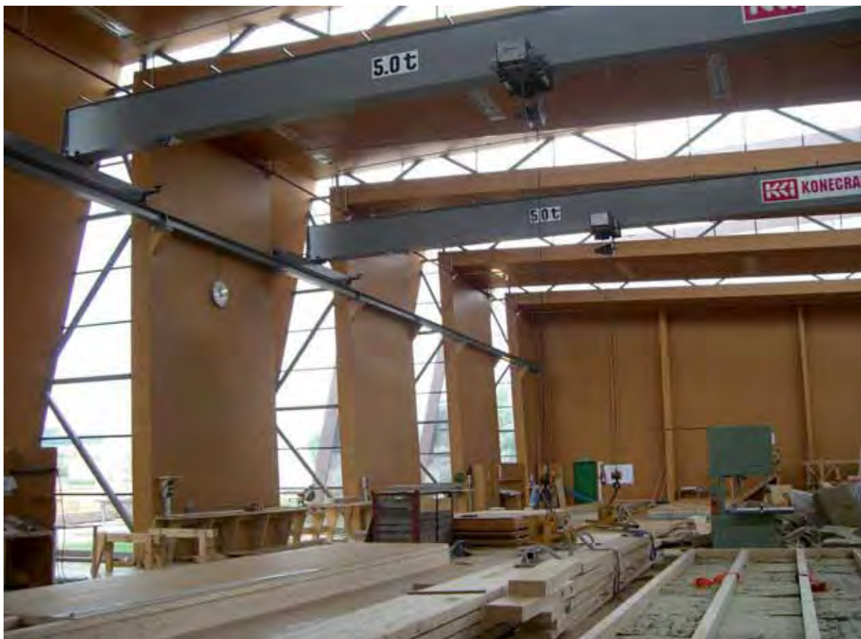
Abb. 24: Innenansicht der Produktionshalle Fa. Obermayr in Schwanenstadt
