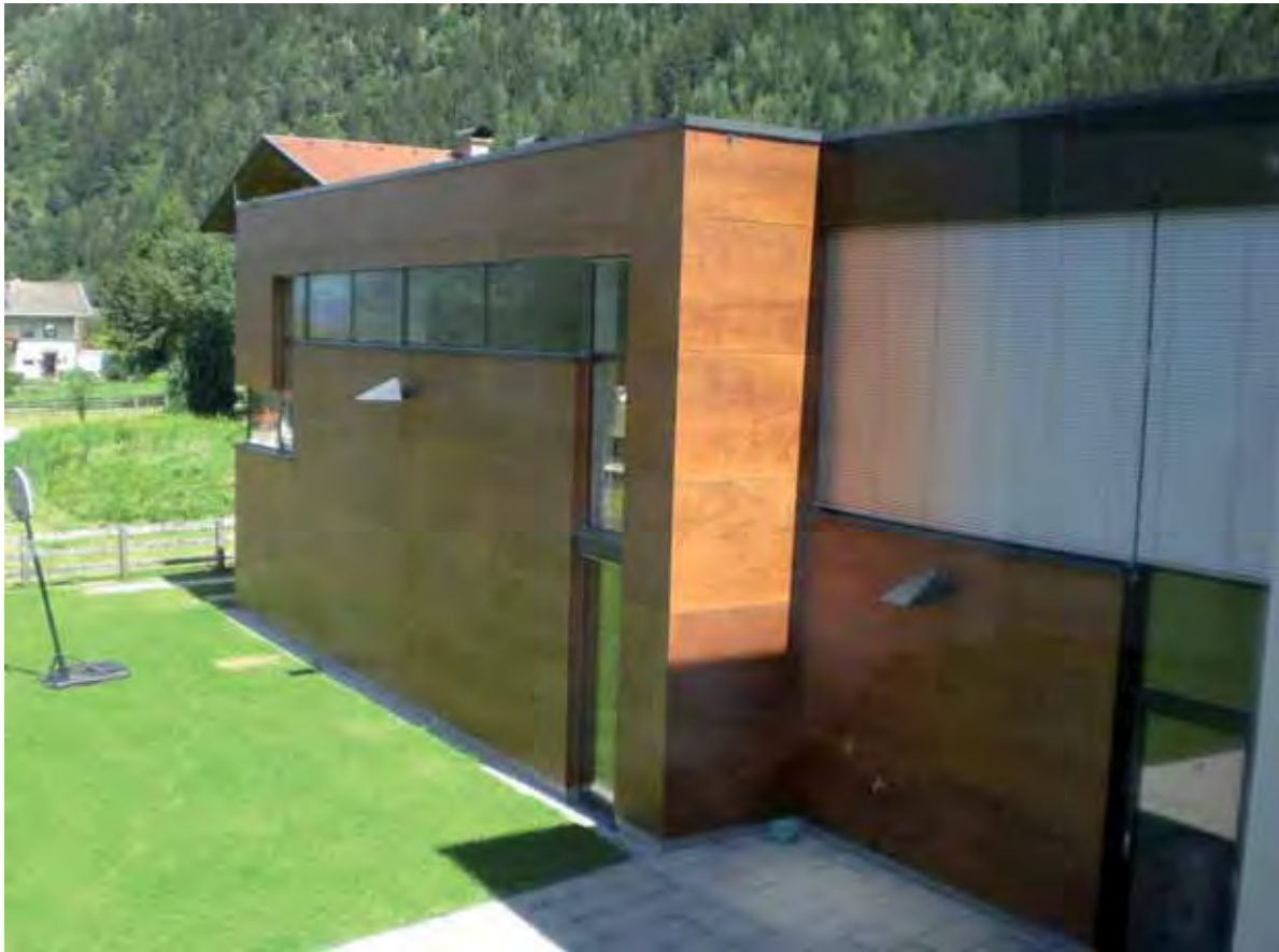
Abb. 10: Seitenansicht des neuen Turnsaals
