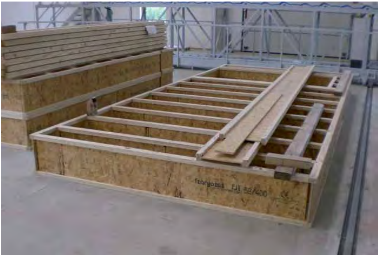
Abb. 11: Die Grundkonstruktion der Wandelemente
