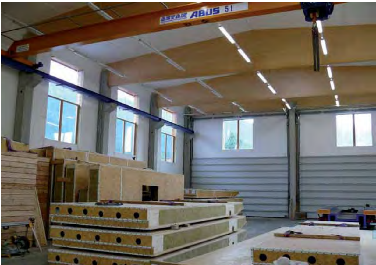
Abb. 12: Geschlossene Wandelemente mit Einblasöffnungen für Zellulosedämmung
