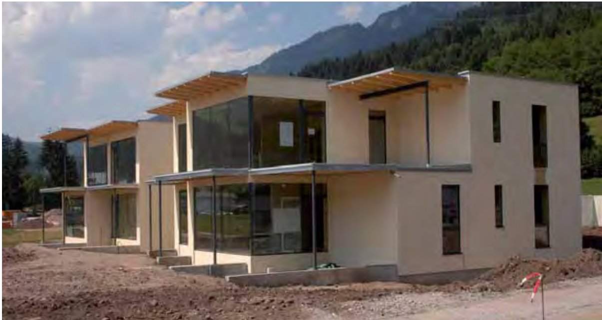
Abb. 4: Südostansicht der Baustelle für das 4-Familienhaus
