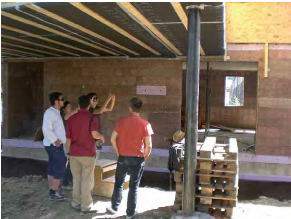
Abb. 8: Besichtigung des Baustellenteils
