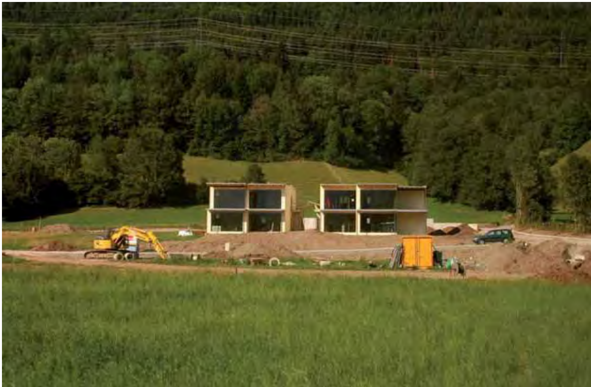
Abb. 3: Südansicht der Baustelle für das 4-Familienhaus
