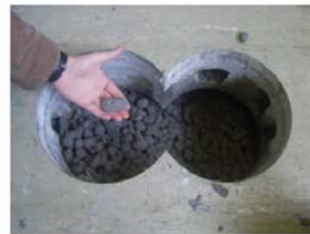
Blick in den mit Schaumglasschotter ausgeblasenen ca. 60 – 70 cm hohen Hohlraum unter der Bodenplatte, bevor dieser vollständig ausgeblasen wurde.
