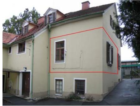
Versuchsgebäude Zellulose-Innendämmung ohne Dampfsperre
