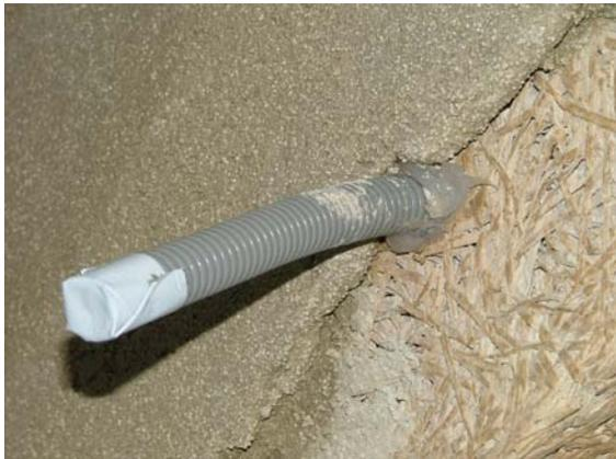
01.02.2006: Musterfertigteile: luftdichte Elektrodurchführung
