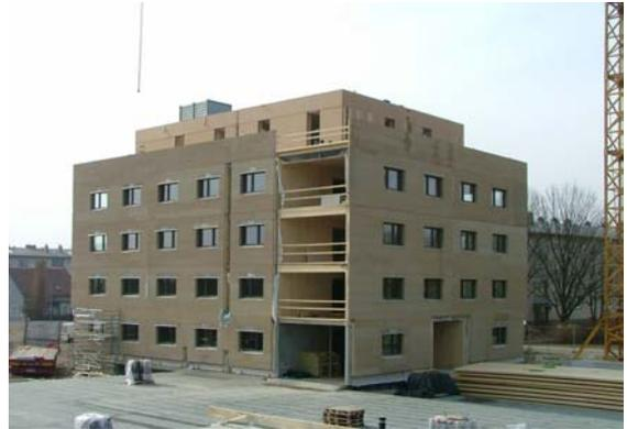
24.02.2006: Haus A – Montage der Fertigteile fertig (ausgenommen Loggien)
