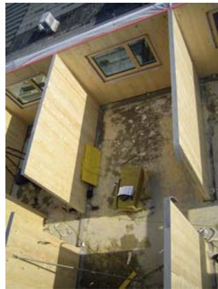
14.02.2006: Wände bereit zur Montage der Decke Fugenbänder
