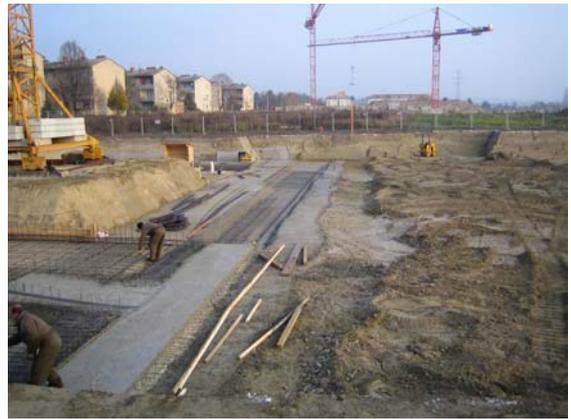
09.11.2005: Baugrube Haus A und B sowie Tiefgarage, Sauberkeitsschicht, bewehren und betonieren der Bodenplatte
