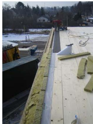
15.02.2006: Nachbearbeitung am Detail Fassade - Decke
