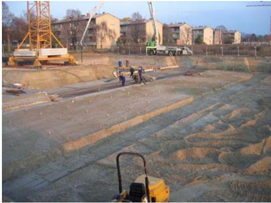
11.11.2005: Baugrube Tiefgarage, Herstellen des Niveaus, Sauberkeitsschicht, bewehren der Streifenfundamente für die Säulen der Tiefgarage
