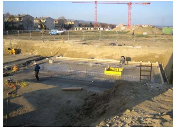
15.11.2005: Betonieren der Bodenplatte Haus C
