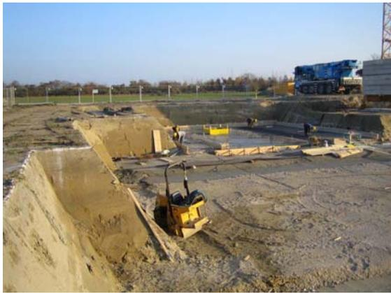
15.11.2005: Herstellen Niveau für Bodenplatte TG
