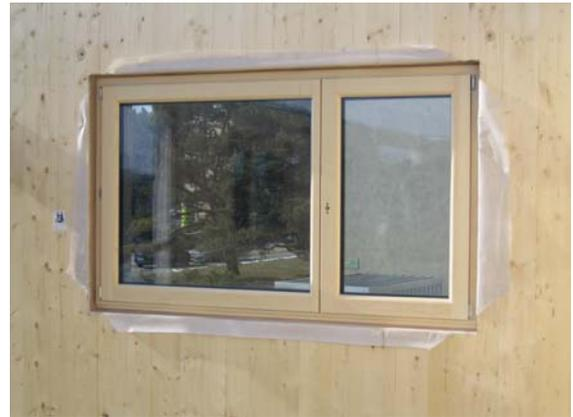
14.02.2006: Strömungsdichter Fenstereinbau werkseitig
