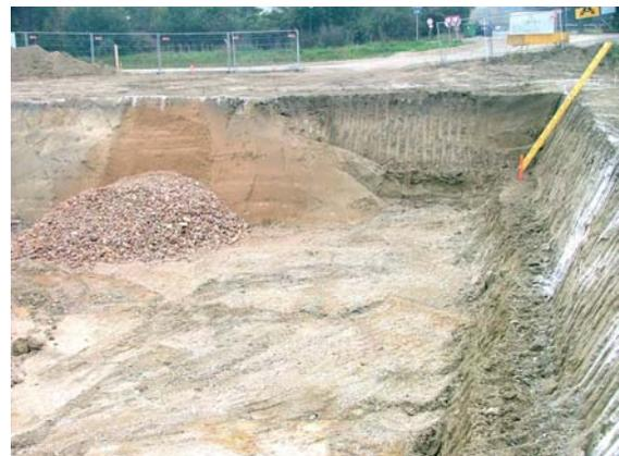
20.10.2005: Baugrubenaushub auf tragfähige Schicht, Bodenaustausch
