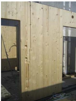
14.02.2006: Fräsungen für die Elektroverkabelung
