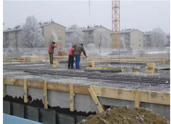
02.12.2005: Halbfertigteile Decke über UG, Haus D
