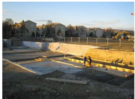
17.11.2005: Betonieren der Bodenplatte Haus C
