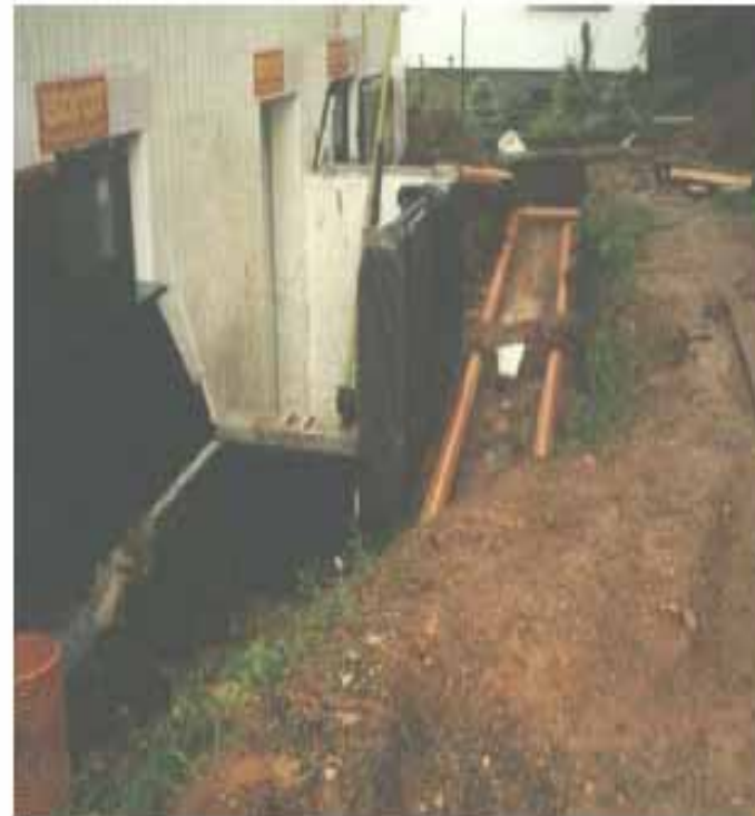
Bild 3: Zwei parallele Erdwärmetauscher-Rohre 2 m neben dem Fundament
