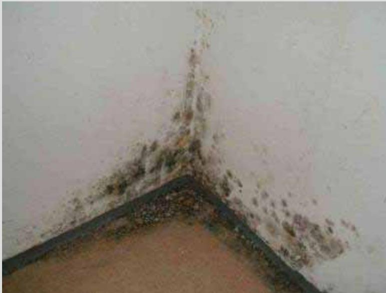
Schimmelbefall in unsanierter Raumecke durch deutliche Wärmebrücke
