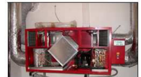
Bild 11: Lüftungsgerät mit Kreuzstrom-Wärmetauscher und integrierter Wärmepumpe (Wärmeabgabe)
