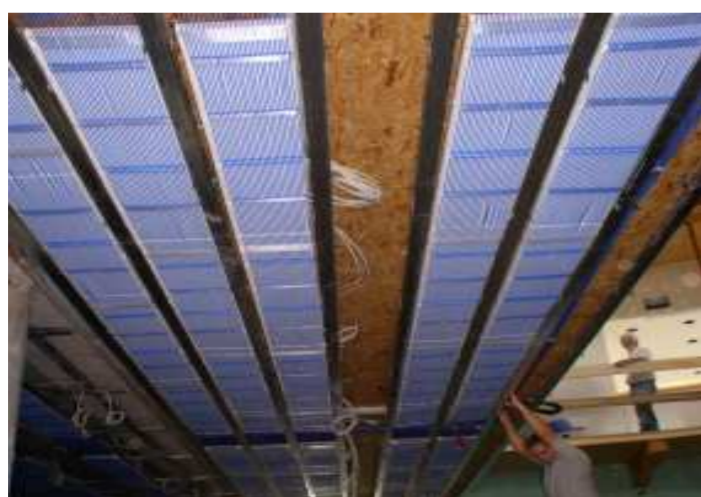
Bild 5: installierte Kühldecke
