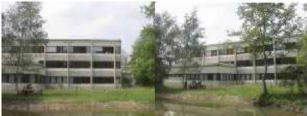
Altbestand vor Sanierung
