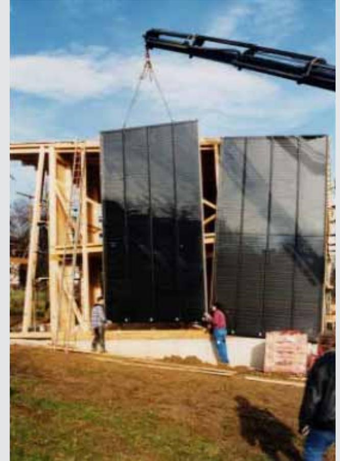
Bild: Montage der Kollektoren der Testfassade mit Hilfe eines Kranes [AEE INTEC]
