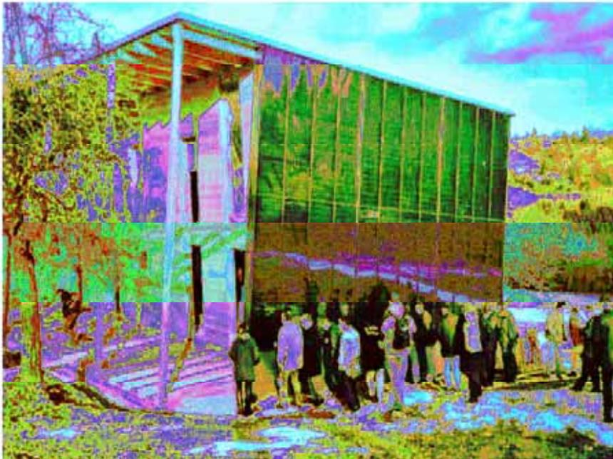
Abbildung 7.3: Testfassade mit 55 m<sup>2</sup> Kollektorfläche auf einem Zweifamilienwohnhaus in Graz
