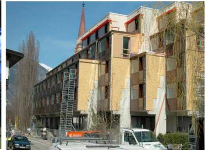
Nach Abnahme der Blumenträge und Terrassenbeläge wurde **fünfseitige Box in Holzfertigbauweise** versetzt. Fassade jeder Box mit 2 Fixverglasungen, Brüstung mit Sitzbank sowie Dreh-Lüftungsclappe. Nutzflächengewinn 17%, Heizkostenreduktion ca. 60 %.
