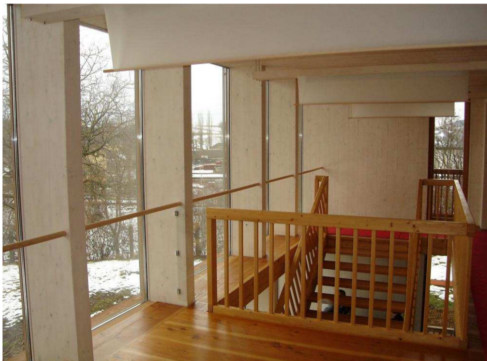
Oben: Bauphase: Grundkonstruktion, Lehmarbeiten, Neu entwickeltes Befestigungselement aus Biokunststoff, Holzdübel, Innenansicht Obergeschoß
