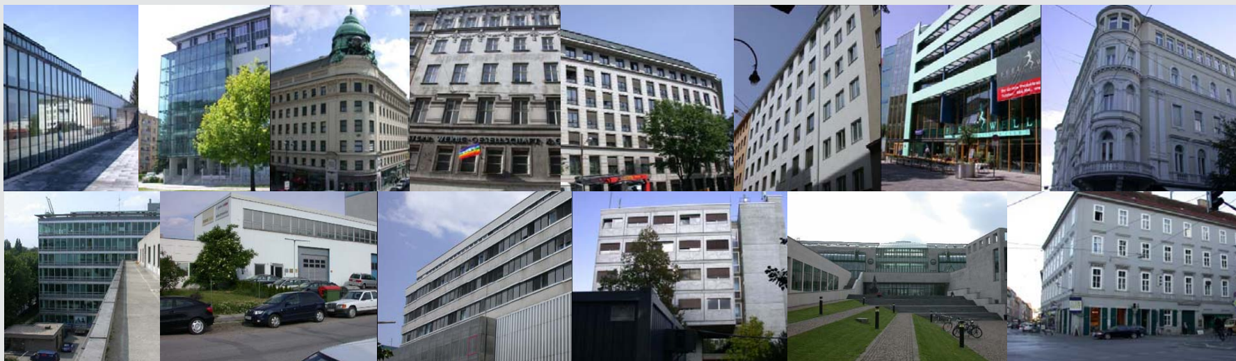
Bild: ausgewertete Bürogebäude [AEE INTEC]
