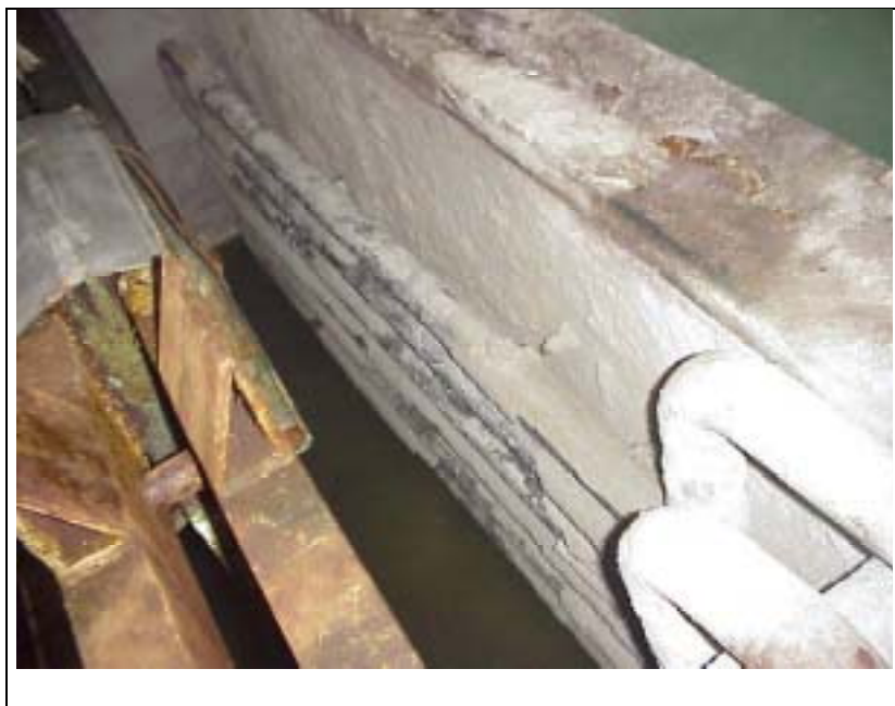
Abbildung II-1: Rohrschlangen zur Beheizung der Bäder
