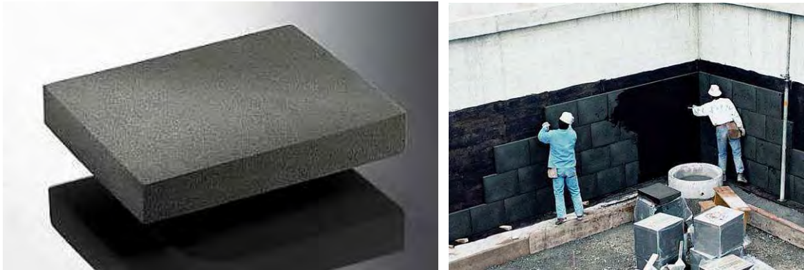
Abbildung 108: Links: Glasschaumplatte 71 . Rechts: Anbringung der Glasschaumplatten 72
