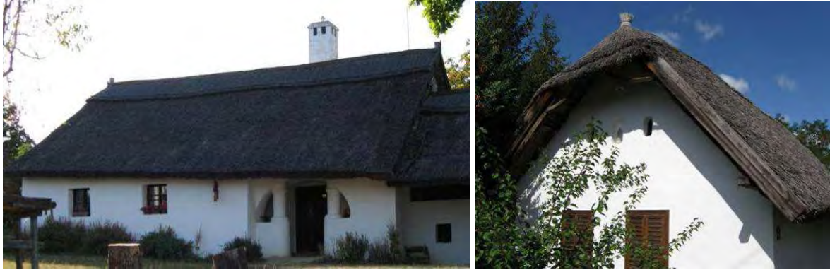
Abbildung 10: Gebäude mit Schilfdächern (Tihany, Ungarn)
