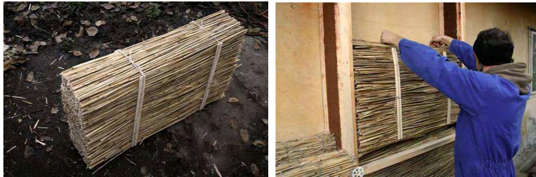
Abbildung 77: Links: Gebündelte Schilfrohre; Rechts: Einbringung in Steico-Stegträgersystem
