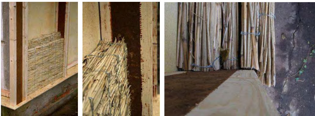
Abbildung 75: Einbringen von drahtgebundenen Schilfrohrplatten
