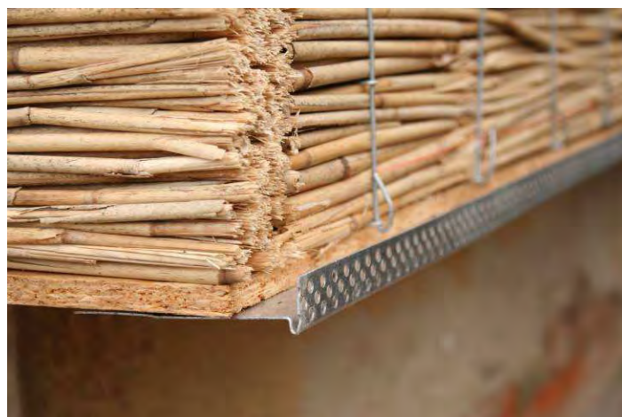
Abbildung 105: Sockelabschluss mittels Putzprofil aus korrosionsbeständigem Metall
