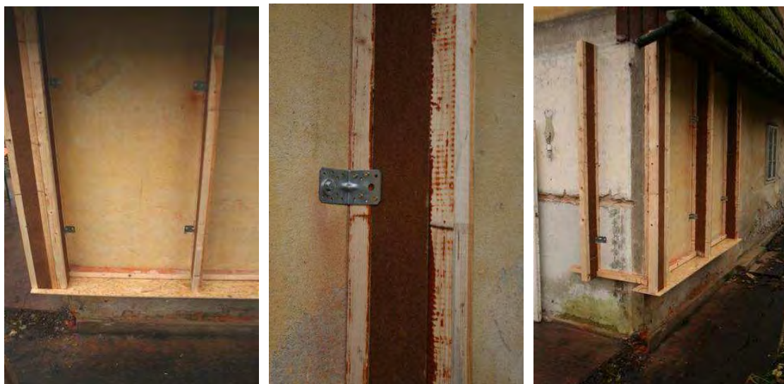
Abbildung 72: Befestigung der Stegträger Steico mittels Winkeleisen
