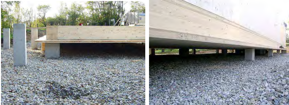
Abbildung 107: Punktfundament-Säulen aus Stahlbeton unter dem Rohbau des S-HOUSE
