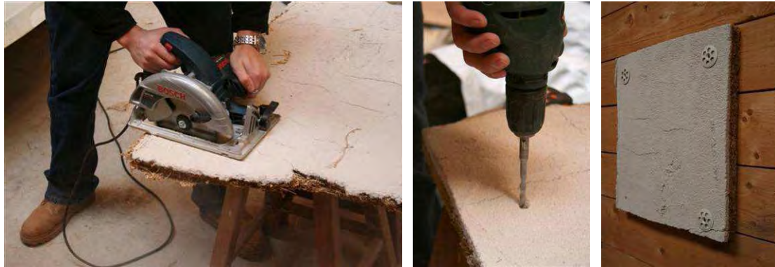
Abbildung 117: Links und Mitte: Zuschnitt und Bohrung. Rechts: Befestigung des Prototyps an der Testwand mit Tellerdübeln
