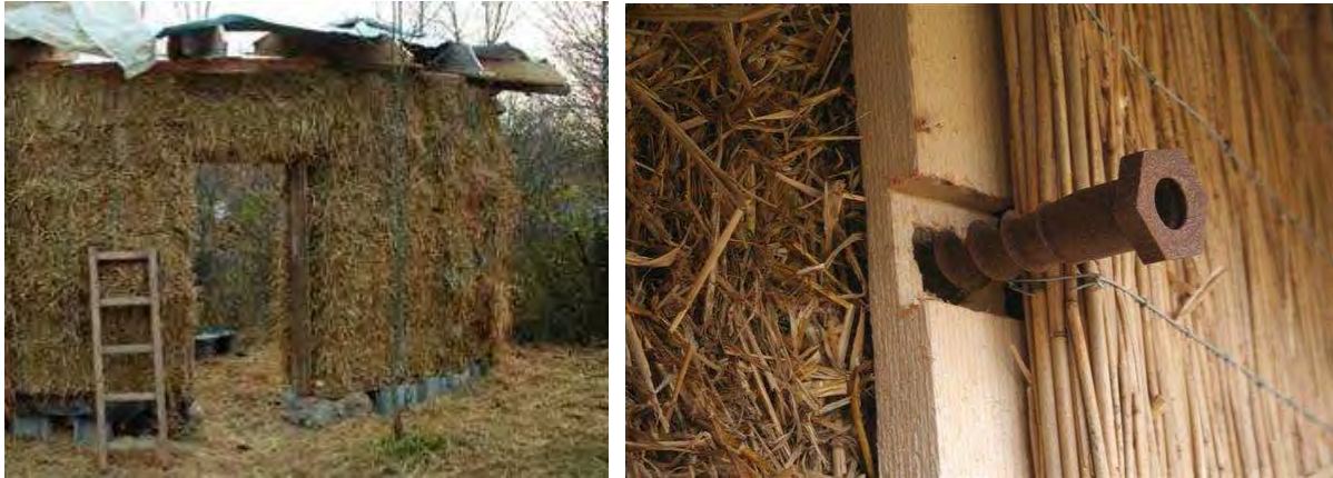
Abbildungen 84: Links: lasttragende Strohballen-Musterwand mit gebogenem Wandverlauf. Rechts: Wandaufbau mit Strohballen, Holzsteher, Schilfrohrplatte und Treeplast-Schraube
