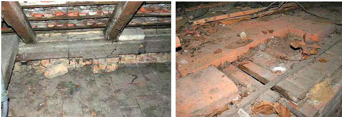
Abbildung 139: Oberste Geschoßdecke vom Dachboden aus betrachtet
