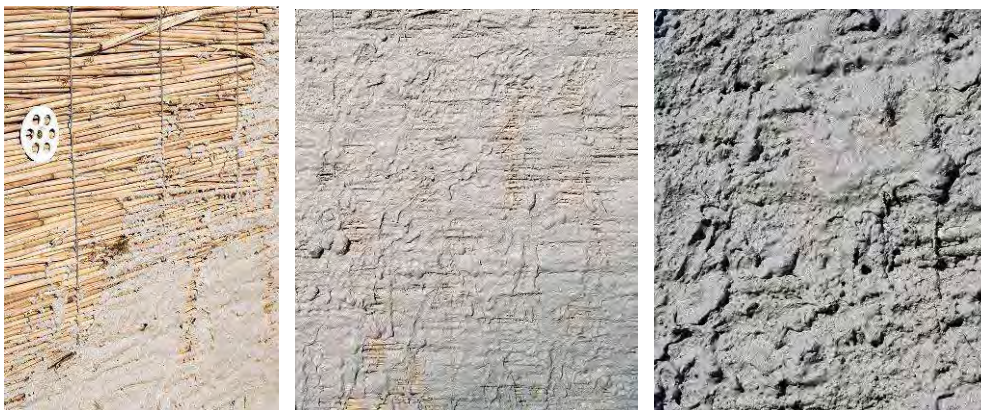
Abbildung 89: Aufbringen der ersten Putzschicht (Vorspritzer NHL 5) auf die Dämmplatten
