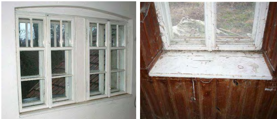
Abbildung 134: Links: Fensterlaibung im Obergeschoß (Mauerstärke 30 cm). Rechts: Fensterlaibung im Regelgeschoß (Mauerstärke 50 cm)
