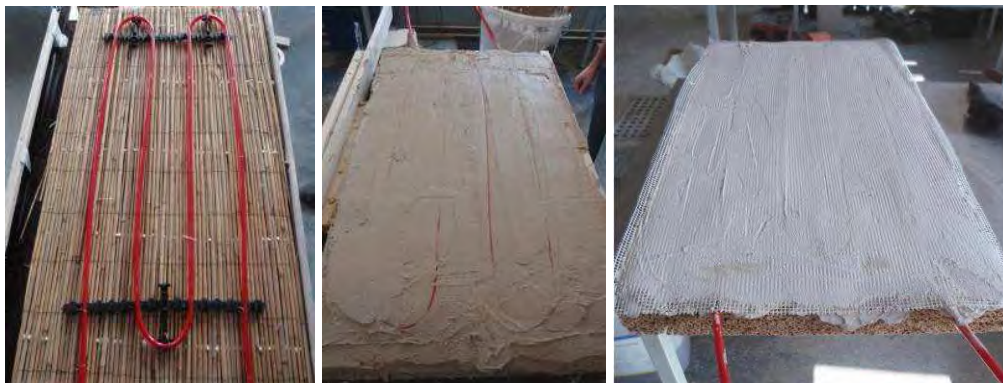
Abbildung 122: Putzauftrag auf thermoplastgebundene Schilfrohrplatte inkl. Wandheizungsrohren
