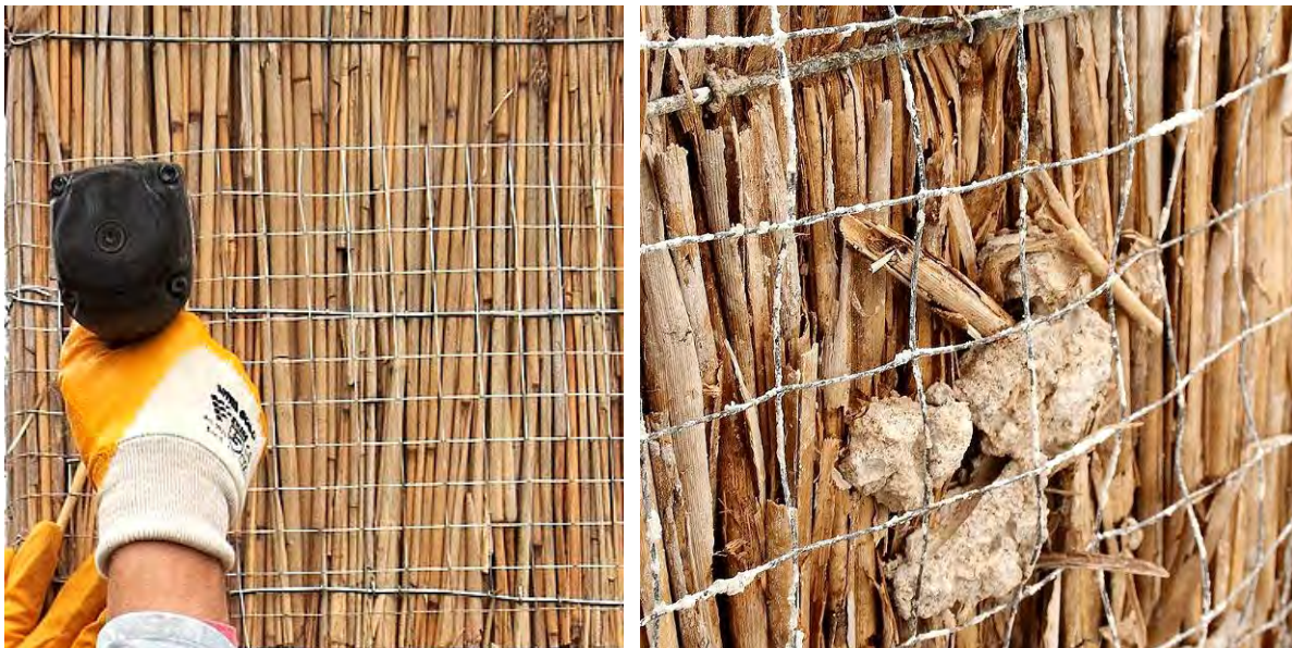
Abbildung 100: Links: Befestigung des Metallgitters mittels Klammerung. Rechts: Metallgitter nach Putzabschlag
