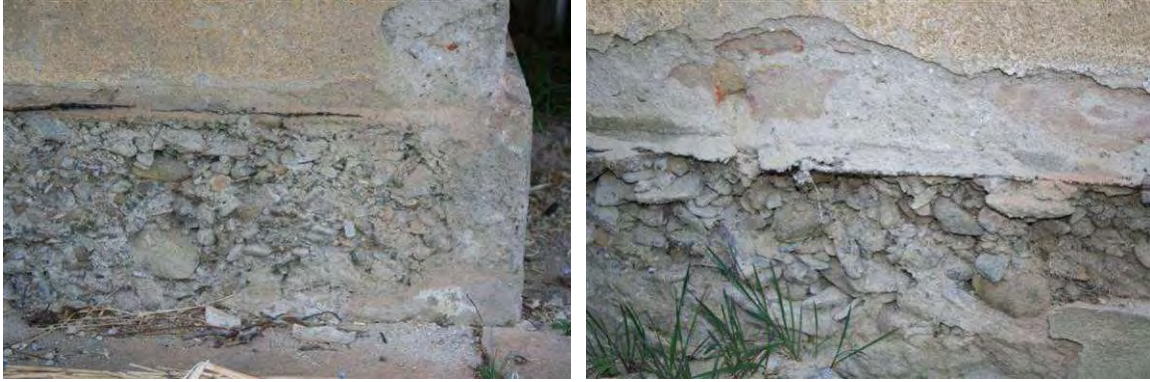
Abbildung 140: Sockelzone der Außenwand mit freigelegter Bodenplatte
