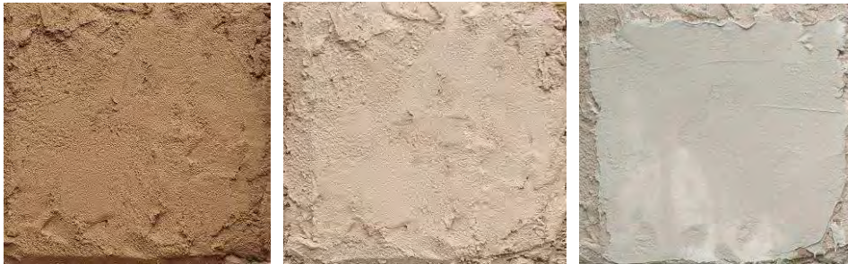
Abbildungen 92: Thermoputz NHL 5. Links: Grundputzauftrag. Mitte: Grundputz erhärtet. Rechts: Feinputzauftrag
