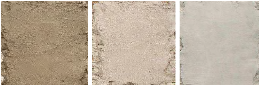
Abbildungen 95: NHL 3,5 BSM mit Porenbilderzusatz. Links: Grundputzauftrag. Mitte: Grundputz erhärtet. Rechts: Feinputzauftrag
