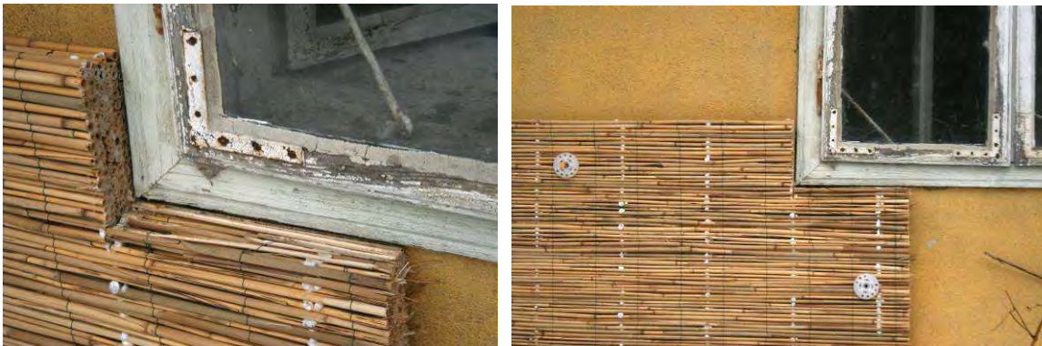
Abbildung 65: Verdübelung thermoplastgebundener Schilfrohrplatten am Anwendungsfall, Detail Fensteranschluss
