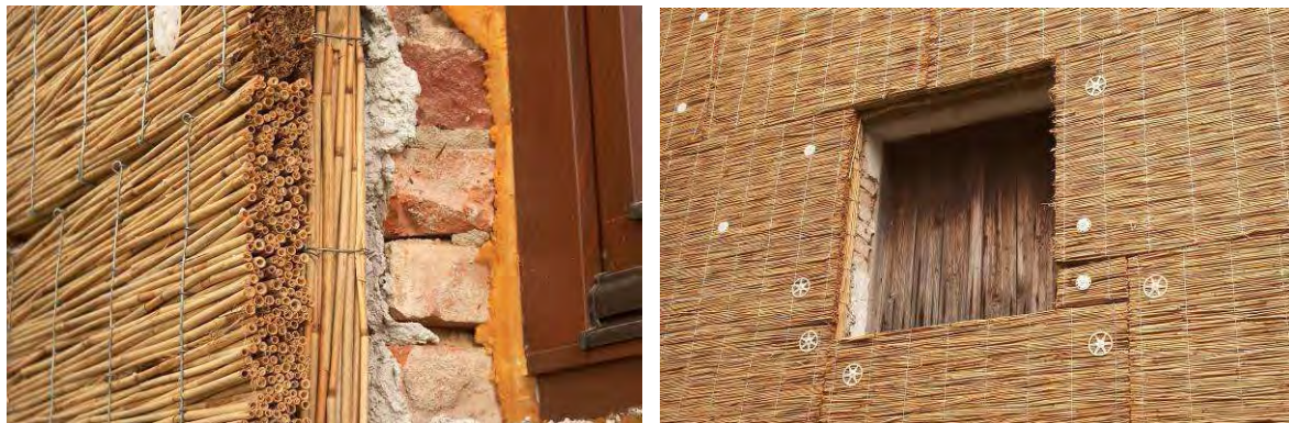
Abbildung 55: Zweilagig verdübelte Schilfrohrplatten, 5 cm, in Mörtelbett
