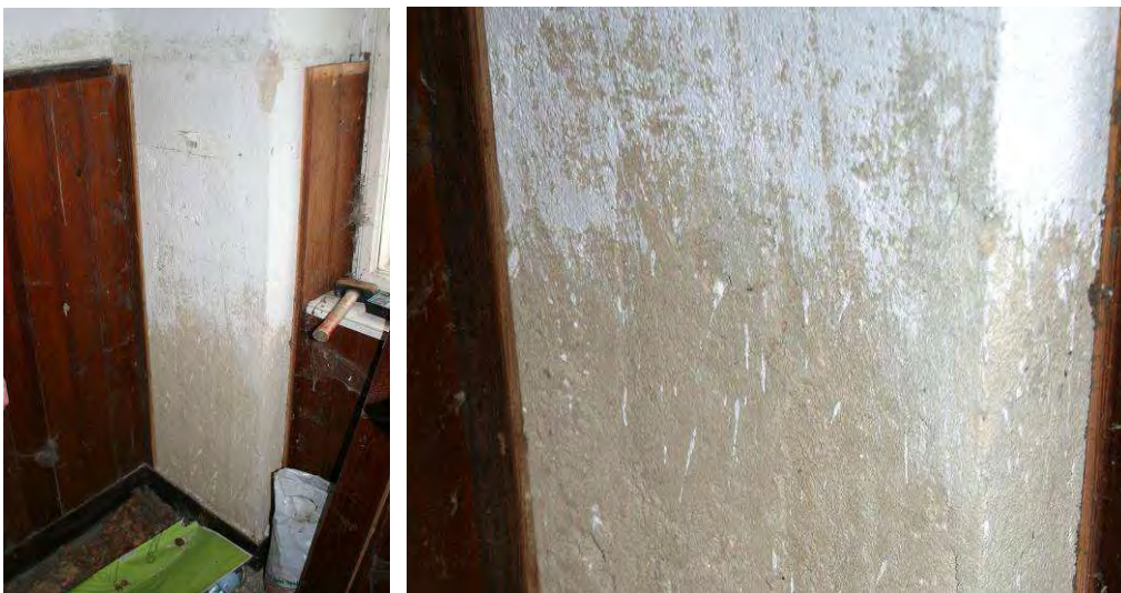
Abbildung 144: Freigelegtes Wandsegment hinter Holzvertäfelung im Erdgeschoß
