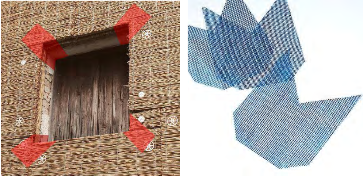
Abbildung 101: Links: Diagonalbewehrung in einer Fensteröffnung; Rechts: Diagonalbewehrungspfeile 64
