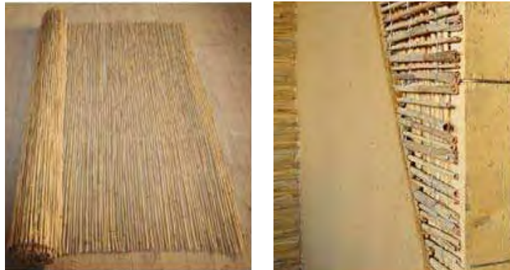
Abbildung 12: Schilfrohrmatte; rechts: im Einsatz als Putzträger
