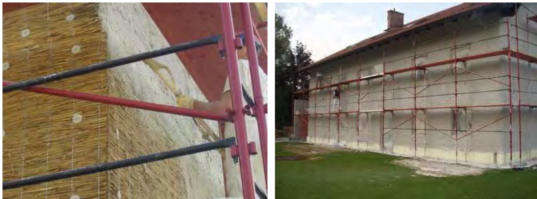
Abbildung 56: Zweilagig verdübelte Schilfrohrplatten, 5cm, und Thermoputz 49
