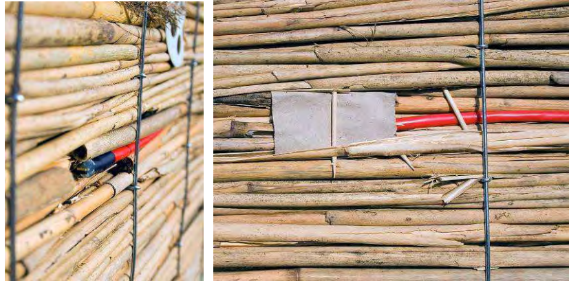
Abbildung 88: Einbau der Sensoren zur Ermittlung von Temperatur und Feuchtigkeit
