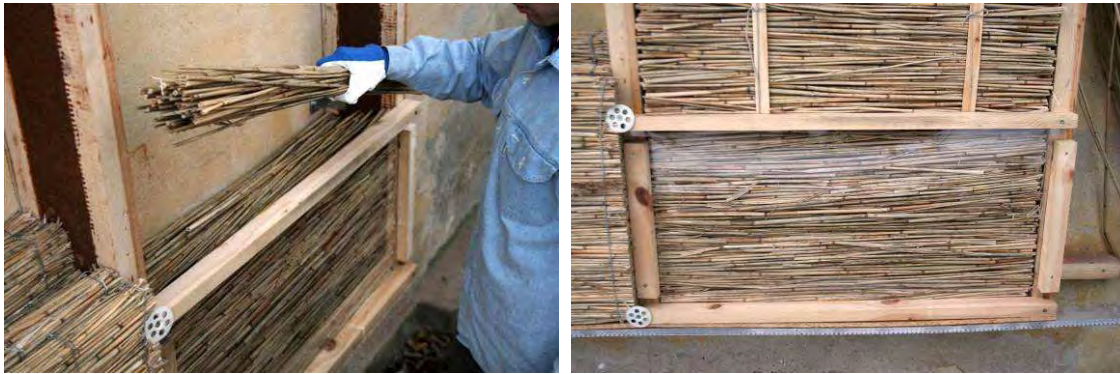
Abbildung 76: Einbringung von losen Schilfrohren
