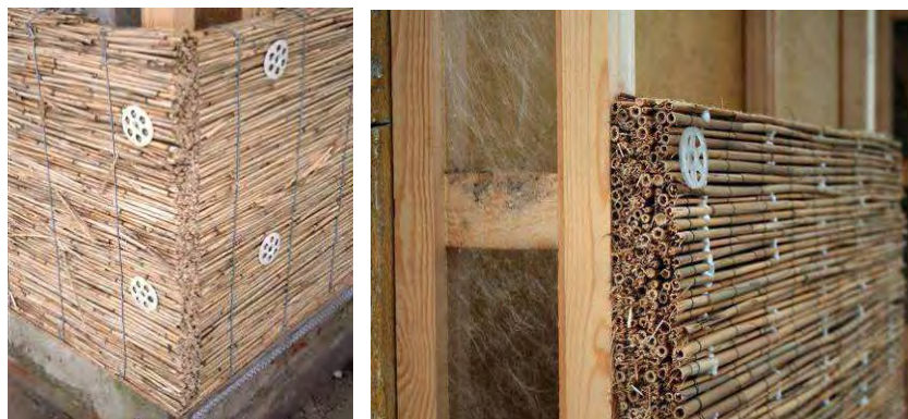
Abbildung 79: Abschluss-/Putzträgerplatte. Links: Drahtgebundene Schilfrohrplatte; Rechts: Thermoplastgebundene Schilfrohrplatte
