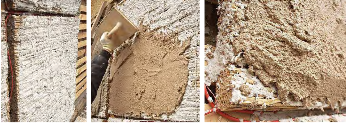
Abbildung 90: Links: trockener Spritzbewurf. Mitte: Auftragen des Grundputzes. Rechts: Detailaufnahme Grundputz (Kalkputzvariante 2)
