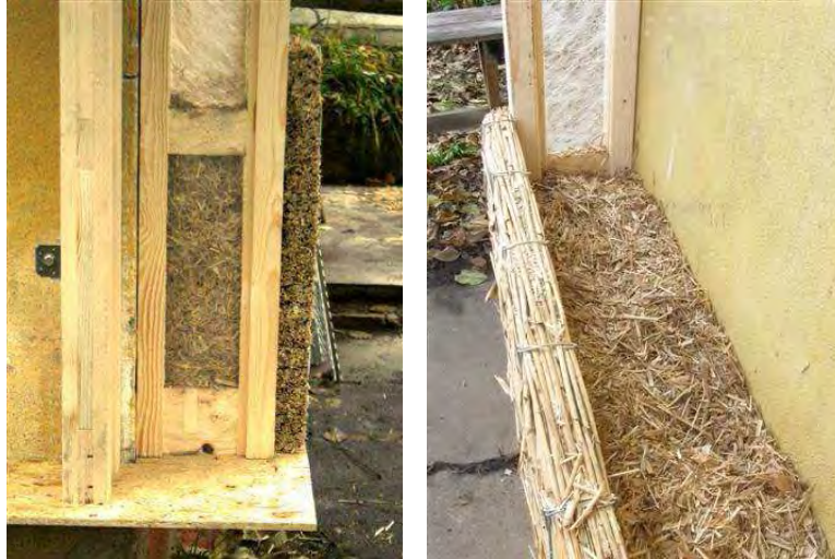
Abbildung 78: Schilfhäcksel-Schüttung zwischen Stegrägern, Bestandsmauerwerk und Putzträgerplatte
