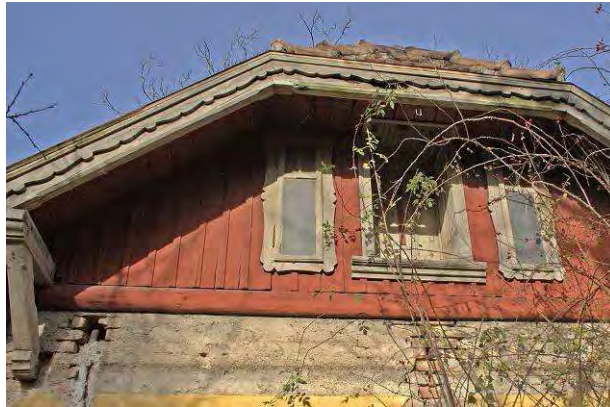
Abbildung 133: Holzkonstruktion im Obergeschoß des Giebelbereichs
