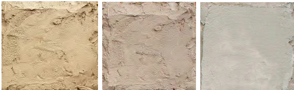
Abbildungen 93: Thermoputz „Kalkmix“. Links: Grundputzauftrag. Mitte: Grundputz erhärtet. Rechts: Feinputzauftrag
