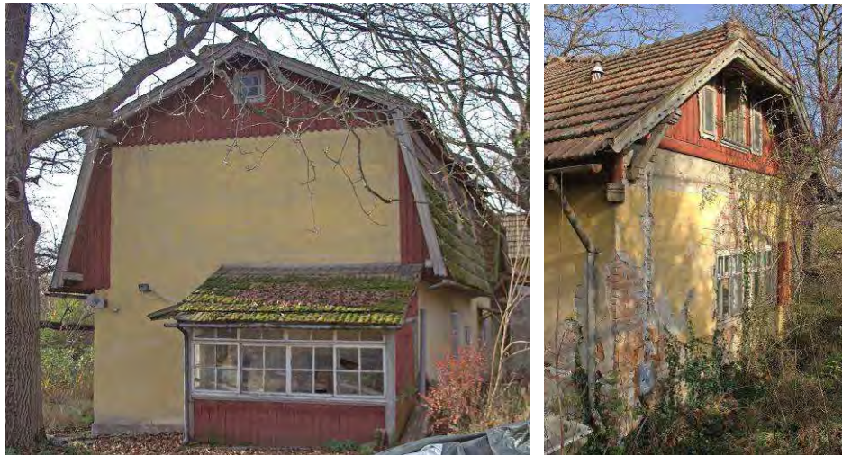
Abbildung 125: Ansichten Sanierungsobjekt „Wohnhaus Riedl“ Böheimkirchen
