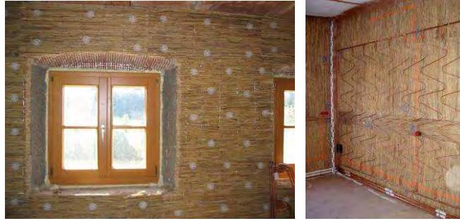
Abbildung 112: Links: Schilfrohrplatten als Innendämmung 76 Rechts: Schilfrohrplatten und Wandheizung 77
