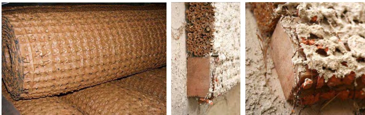
Abbildung 104: Links: Ziegelrabit aufgerollt. 66 Mitte und Rechts: Sockelprofile mit verputztem Ziegelrabit-Armierungsgewebe
