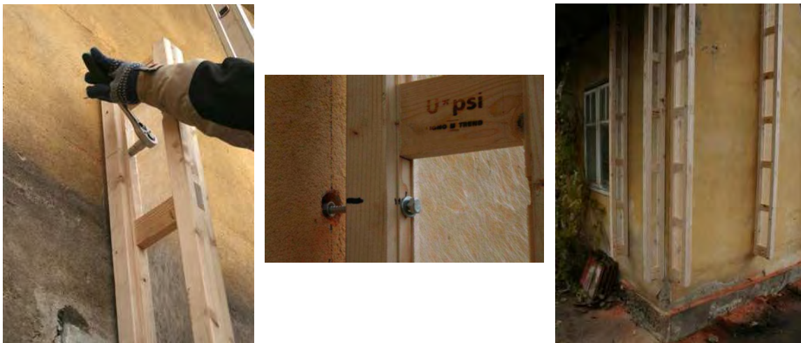
Abbildung 74: Anbringen der Stegträger vom Lignotrend U*Psi F
