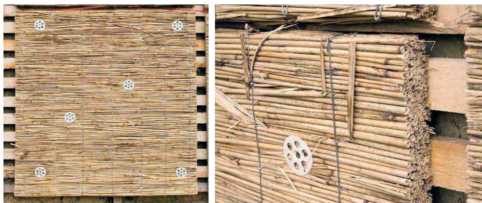
Abbildung 87: Unterkonstruktion der Musterflächen und angedübelte Schilfrohrplatten
