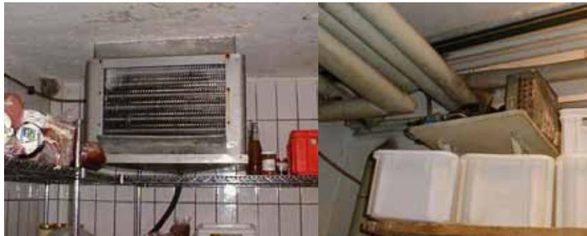
Abbildung 18: ungünstige Anbringung und mangelnde Reinigung der Kühlaggregate
