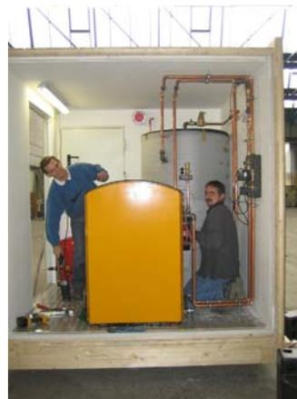
Absorptionskälteprojekt mit Flachkollektoren zu realisieren. In Verbindung mit solarem Kühlen bietet der Biomassekessel den Vorteil, bei länger andauernden Wetterperioden mit heißem aber bedecktem Wetter die Klimatisierung ohne Rückgriff auf konventionelle Kompressorkühlmaschinen weiter betreiben zu können. Das Konzept der energycabin® stellt wiederum sicher, dass nicht durch Fehler in der Umsetzung der komplexen Technik vor Ort die Funktion des Systems in Frage gestellt wird.
