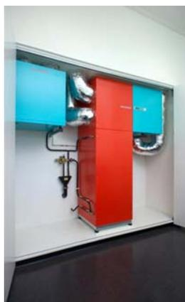
auf die Vorzüge dieser Technologie verzichten zu müssen. Diese Gerätetypen nutzen zusätzliche Erdwärme, um die Kleinst-Wärmepumpe leistungsfähiger zu machen. Dieses Konzept wurde im Frühjahr 2005 zum Patent angemeldet.
