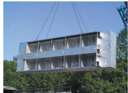
Einbau der Edelstahlkomponenten eines Großabscheiders in ein Ortbetonbecken
