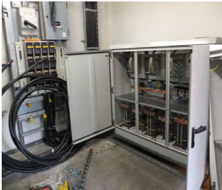
Schaltschrank mit 3 Phasen (630kVA; BxHxT = 160x120x50)
