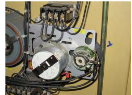
Motorpotentiometer KW Graggaber
