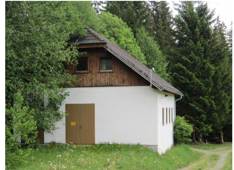
KW Zaunschirm mit montierter Antenne
