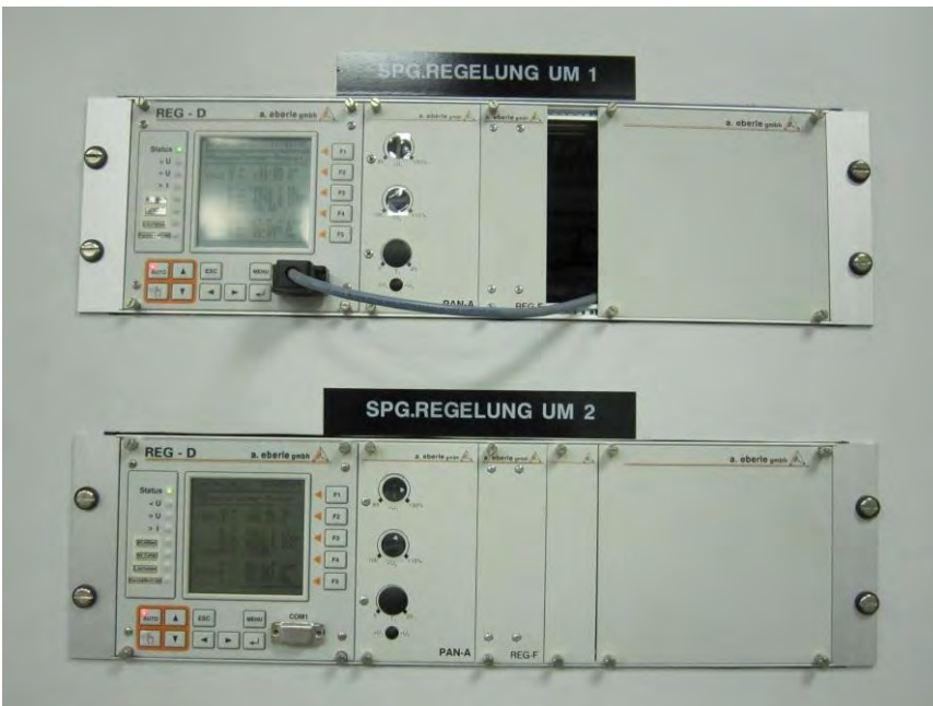
Spannungsregler für Umspanner
