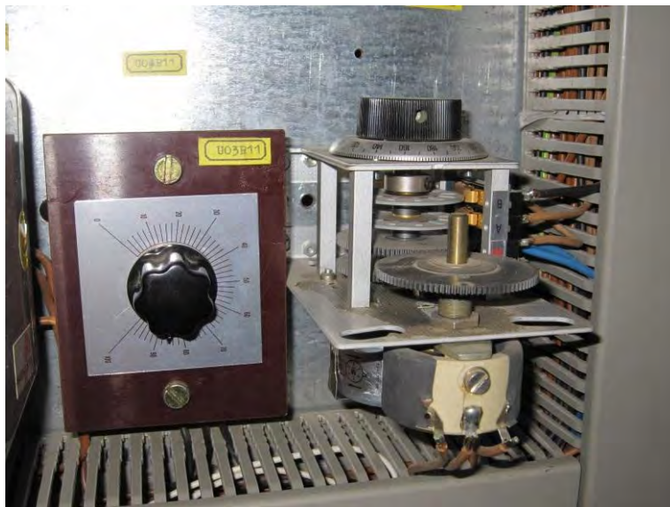
KW Zaunschirm, Motorpotentiometer rechts, \cos\phi -Sollwert links
