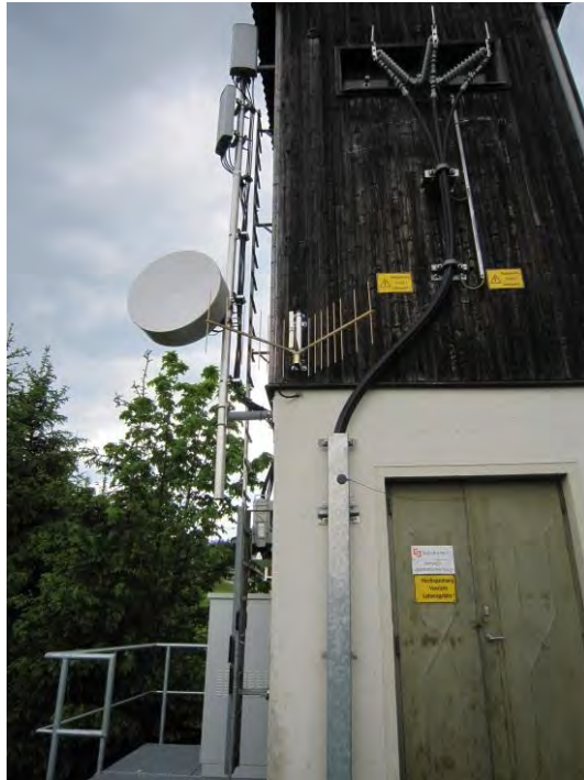
Wimax- Antennenmast
