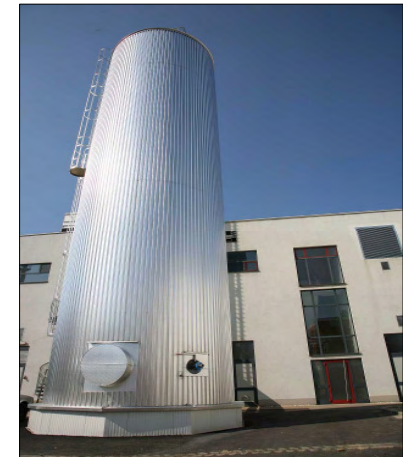
Schichtwasserspeicher (200m 3 )
