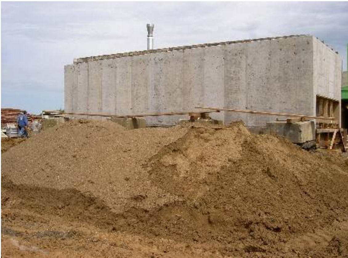
Abbildung 3: Feststoffbehälter in Betonbauweise nach vorgegebenem Schalungsplan
