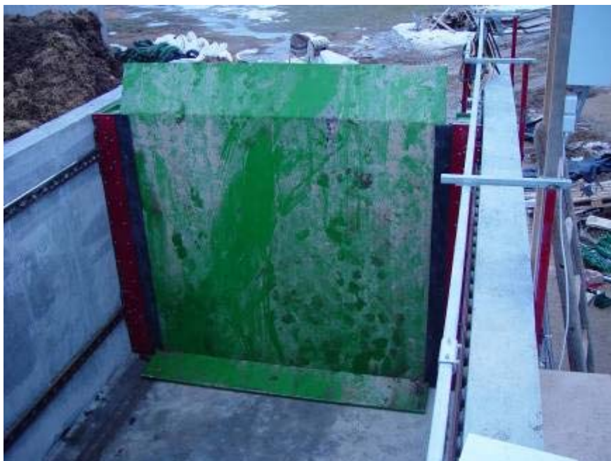
Abbildung 11: Aufbau der Abschiebewand und Funktionstest des Absteckmechanismus der Hydraulikzylinder
