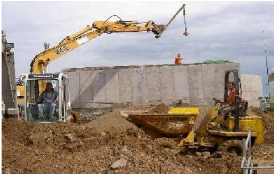
Abbildung 7: Errichtung des Feststoffbehälters nach genauen Detail- und Schalungsplänen
