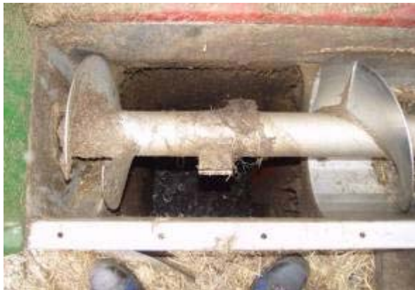
Abbildung 16: Umbau der Einbringschnecke, da Quickmixpumpe nicht die vorgegebene Leistung erbrachte
