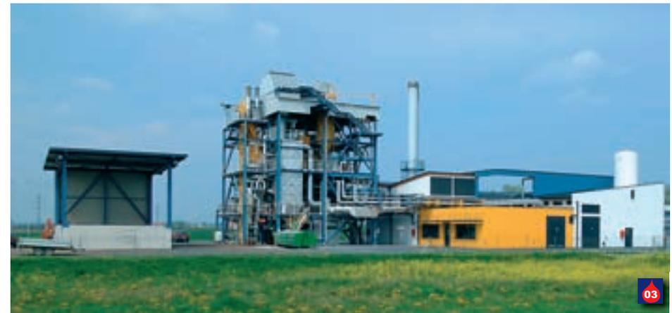
singer Fernwärme zum Kompetenznetzwerk RENEZ zusammen und entwickelten dieses neue, wirtschaftliche und technisch ausgereifte System der Kraft-Wärme-Kopplung auf Basis Biomassevergasung.
