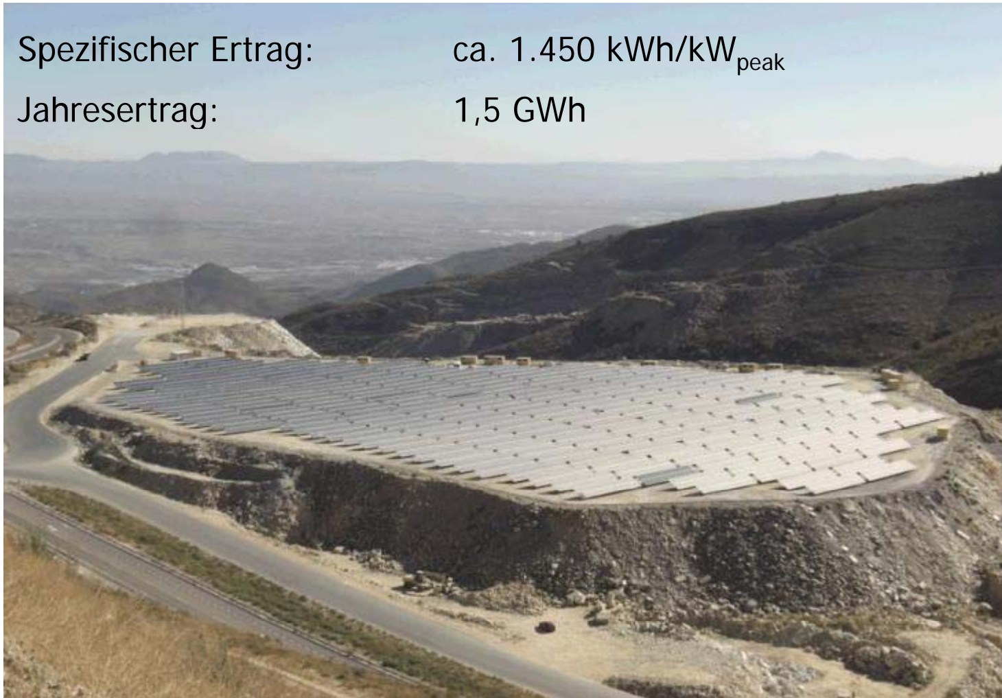
Ansicht der Gesamtanlage (1,5 MW)
