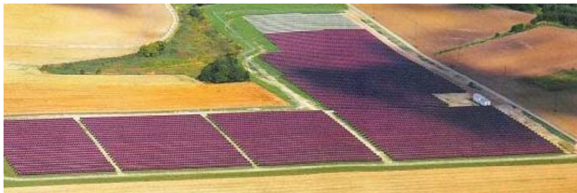
a-Si: Solarpark Buttenwiesen, 2004. (1 MWp Mitsubishi Heavy Industries) Quelle: Phönix SonnenStrom AG
