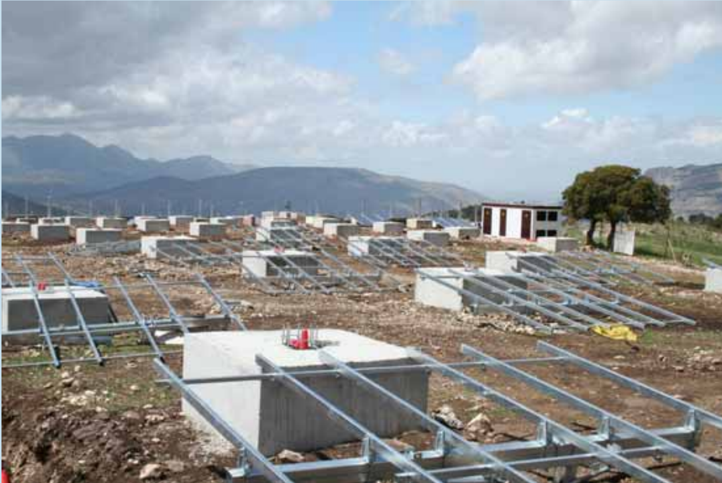
Vor-Ort-Montage auf der Baustelle
