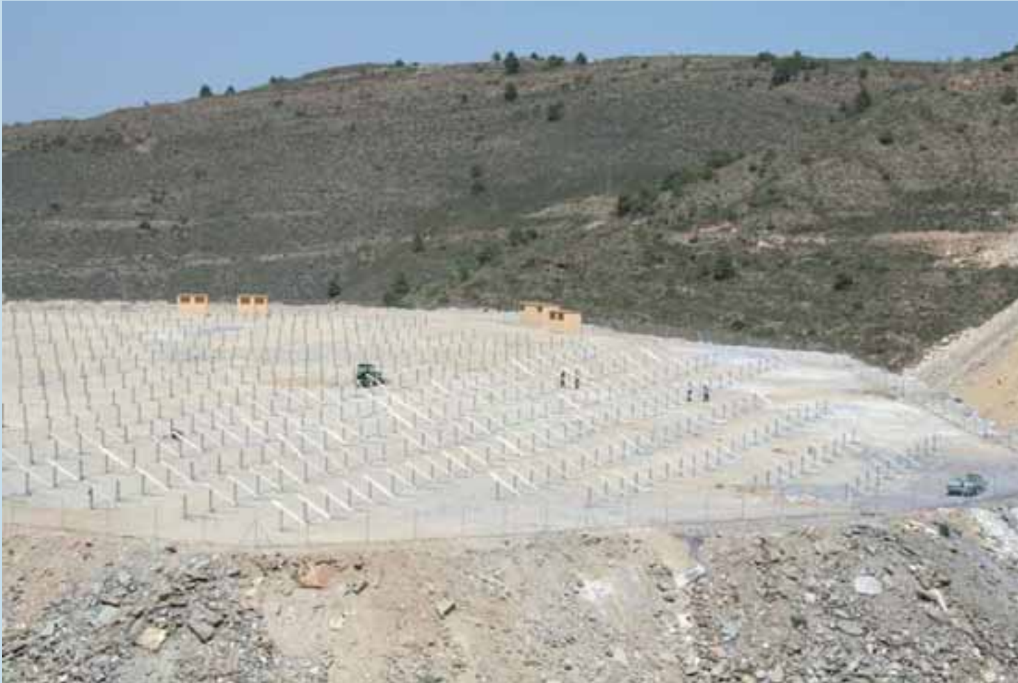
Baustelle kurz vor Modulmontage
