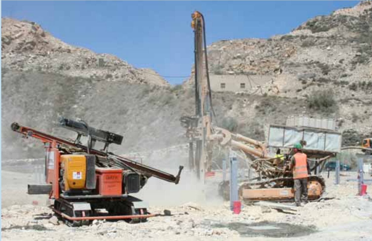
Bohrgerät und Rammgerät in Aktion
