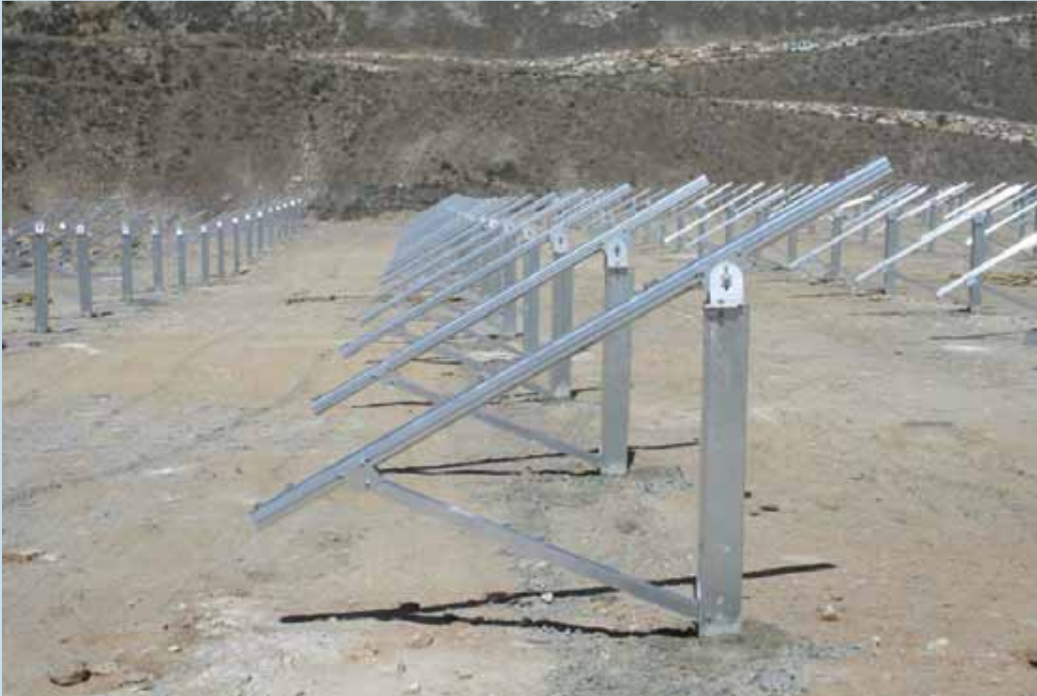
Unterbau fertig zur Modulmontage
