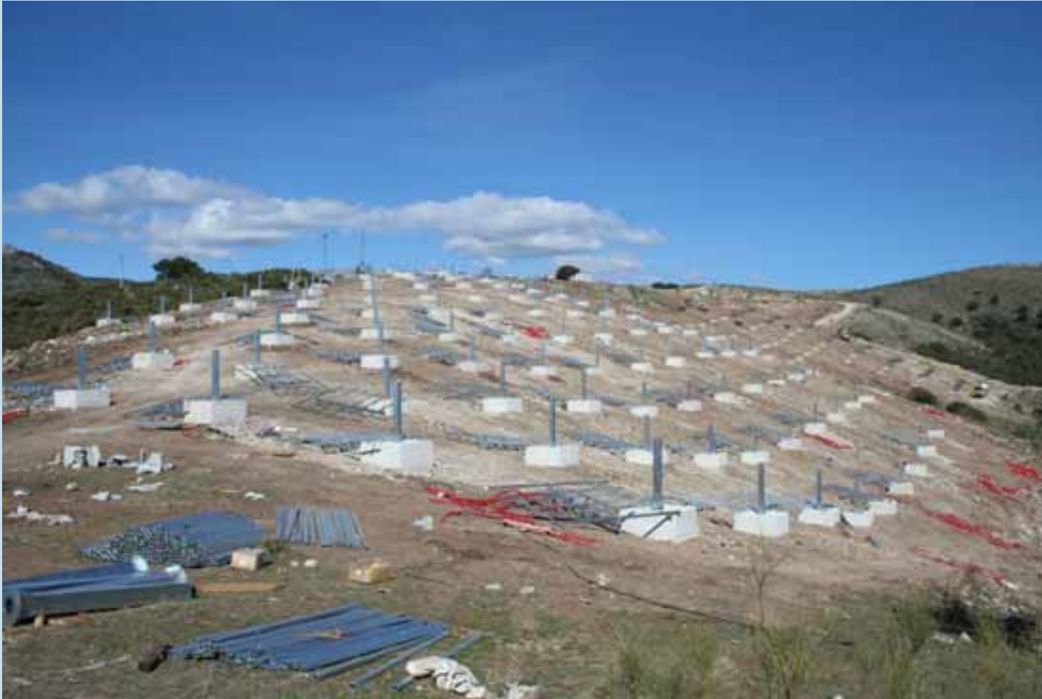
Montage des Tracker-Unterbaus
