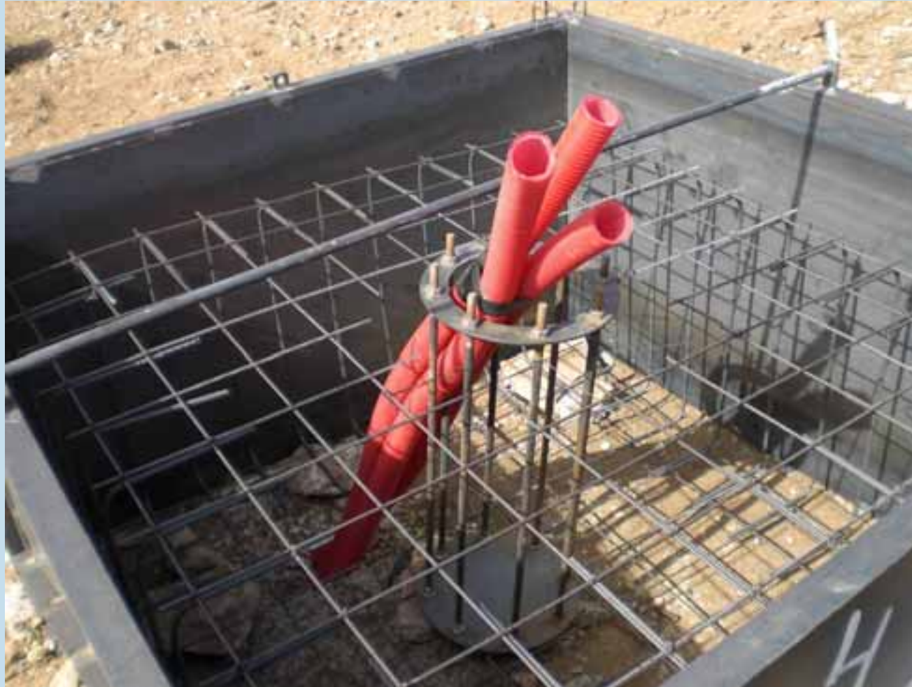
Stahlarmierte Betonfundamente
