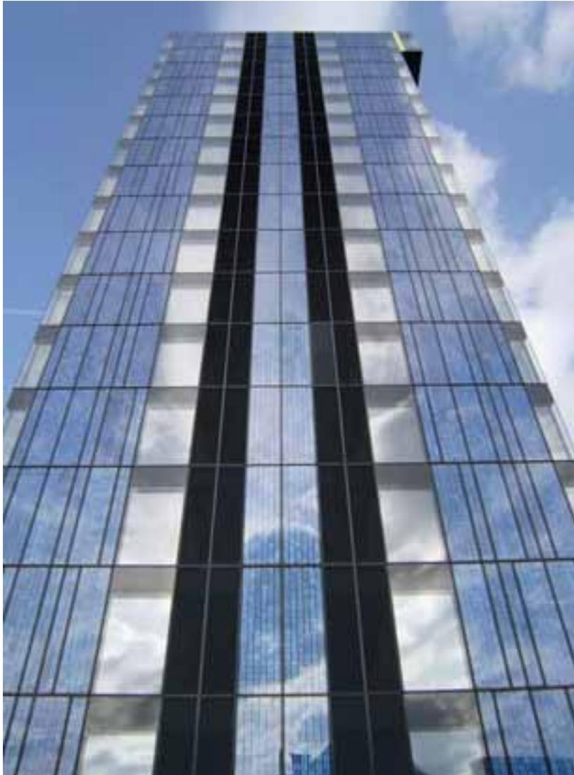
Die Südfassade wurde mit opaken Solarpaneelen ausgestattet:
