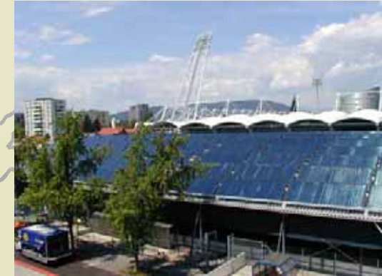
Solaranlage UPC – Stadion (800 kWth)
