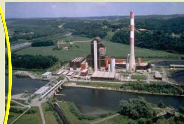
FHKW Mellach (230 MWth)
