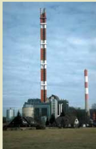
FHKW Neudorf/ Werndorf (200 MWth)
