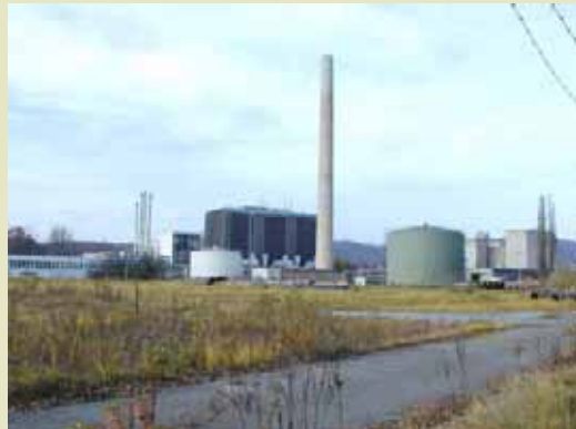
FHKW Puchstraße (275 MWth)
